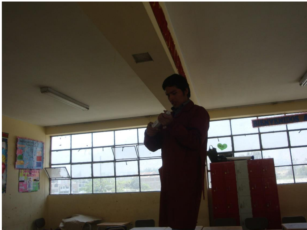
Lectura de rebote de la viga peraltada del segundo piso
