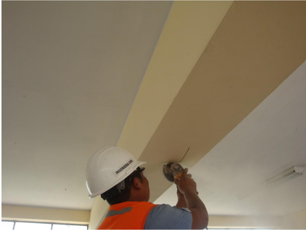
Preparación de la viga peraltada del segundo piso
