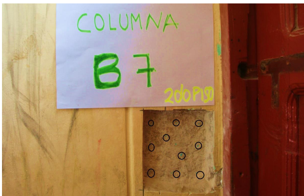
Figura 66. Ubicación de los puntos de aplicación. Fuente: Propia.
