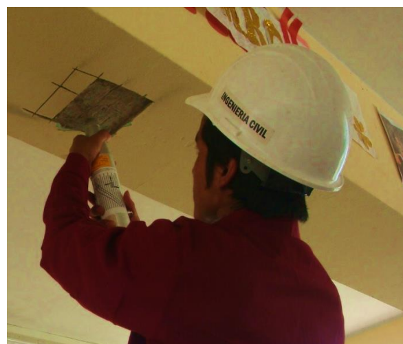
(b) Ensayo a la viga peraltada.
