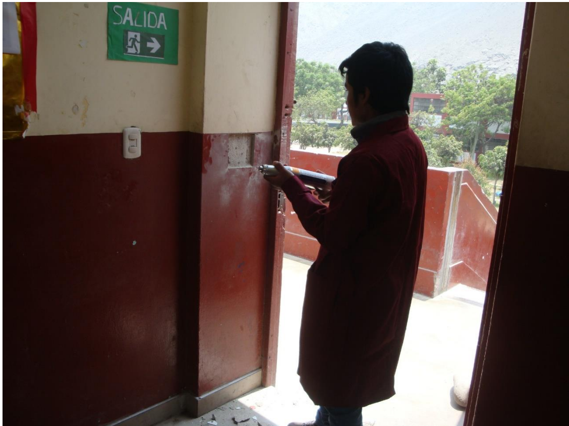
Ensayo de la columna B-3 del Segundo piso
