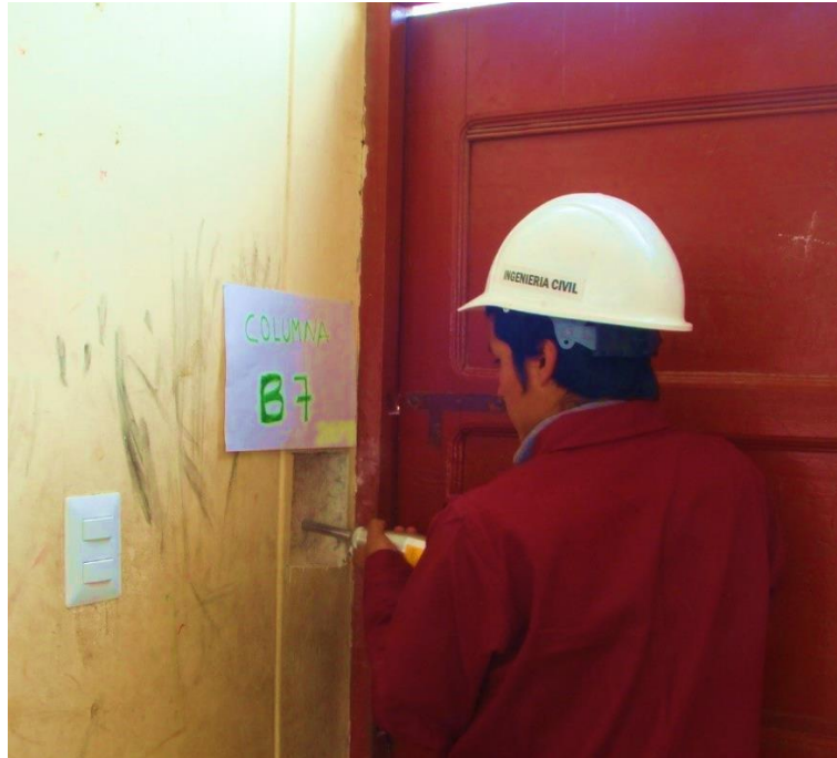
Figura 68. Posicionamiento para realizar el ensayo. Fuente: Propia.
