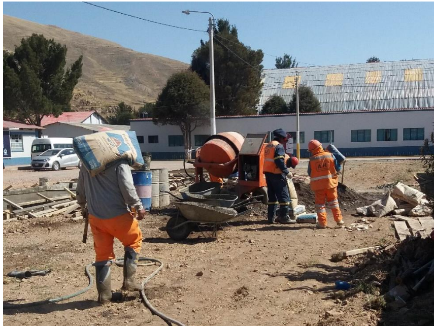
Figura 53: Se observa el trabajo en obra, y el traslado de las bolsas de cemento y exposición al polvo.
