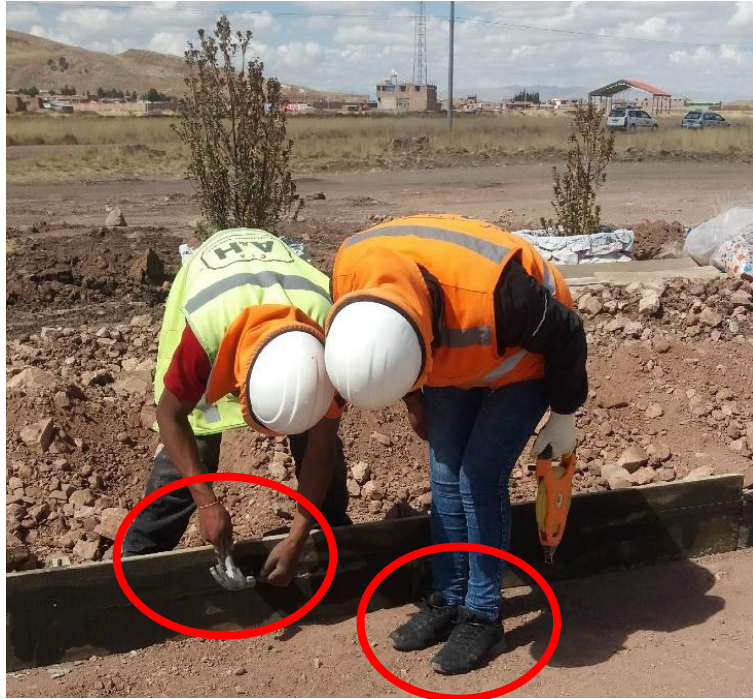
Figura 56: Se visualiza personal en obra, sin uso de equipos de protección personal de fecha 18 de setiembre.
