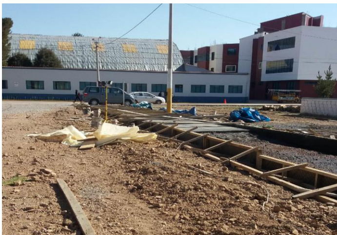
Figura 49: Se visualiza que el 04 de setiembre de 2018 no se realiza la señalización de la obra.
