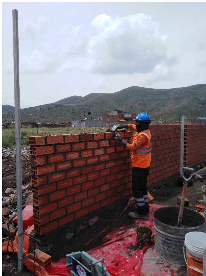
Imagen 43. Emboquillado con mortero a una altura de 1.30 m.
