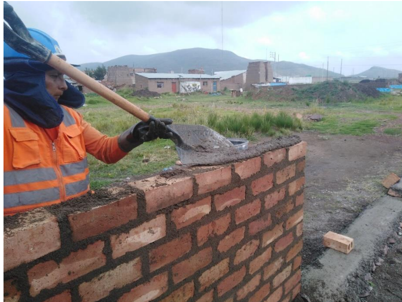
Imagen 38. Colocado de mortero a una altura de 1.30m.
