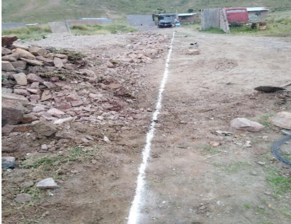
Imagen 22. Trazo replanteo del terreno.
