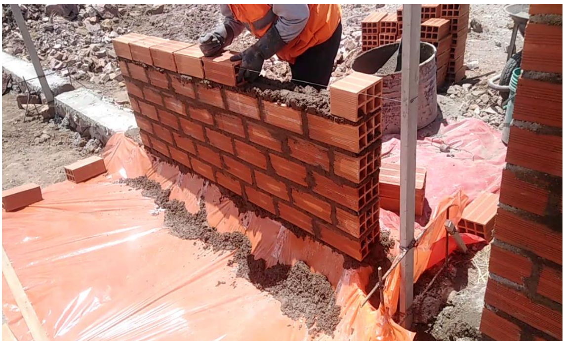
Imagen 37. Asentado de ladrillo en sentido de soga alineado al cordel.
