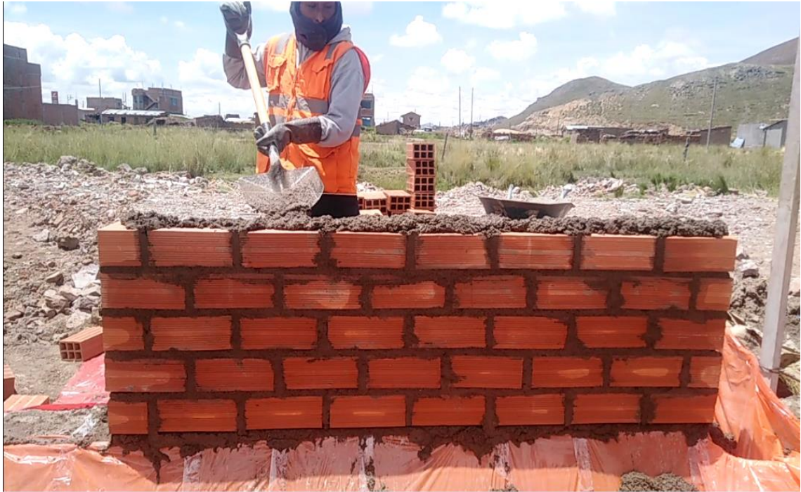
Imagen 36. Colocado de mortero en la base de ladrillo con pala.
