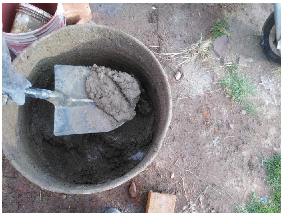
Imagen 45. Consistencia homogénea de mortero trasladado en pala.
