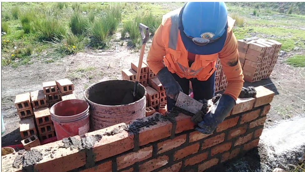
Imagen 15. Emboquillado de juntas verticales, ya que el deslizador no realiza esta función.
