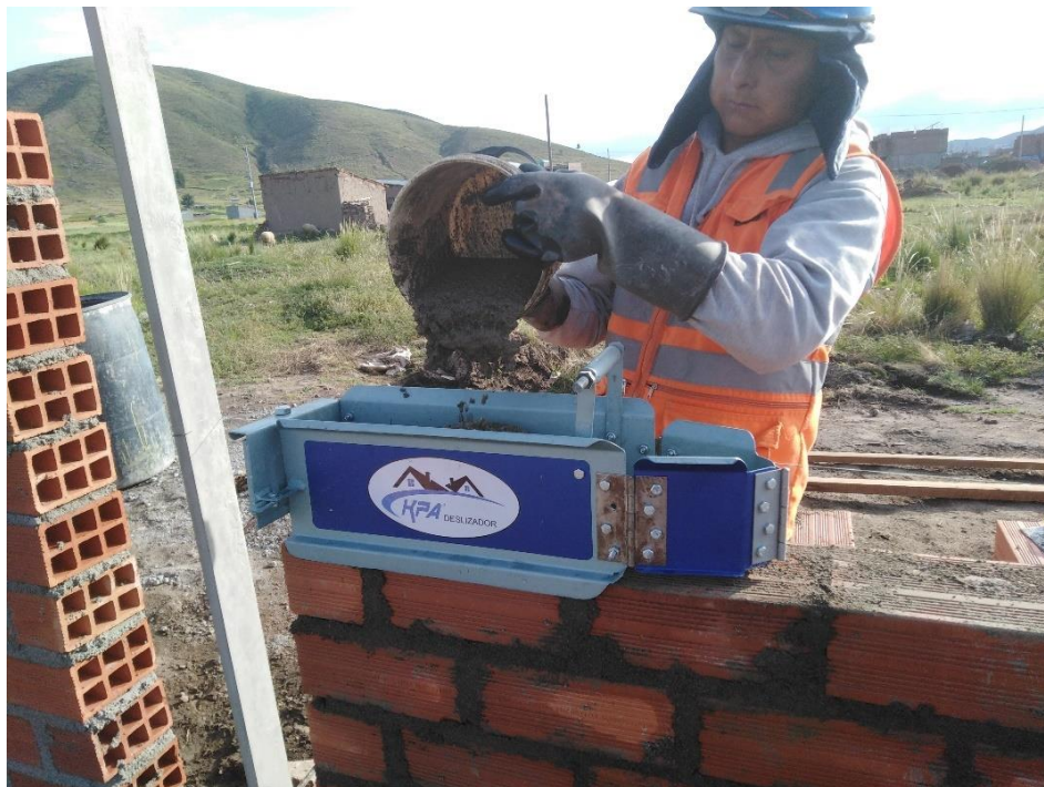
Imagen 61. Insertar el mortero a molde de deslizador.
