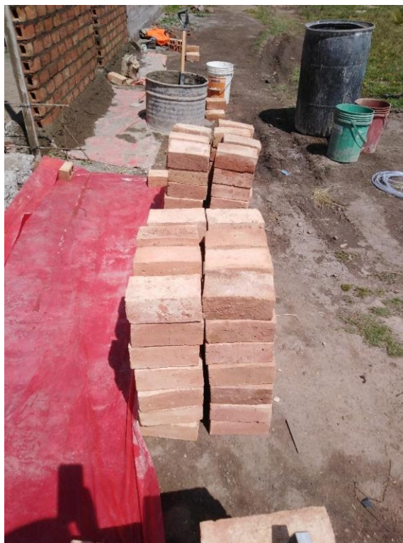
Imagen 31. Traslado de material para el proceso constructivo.
