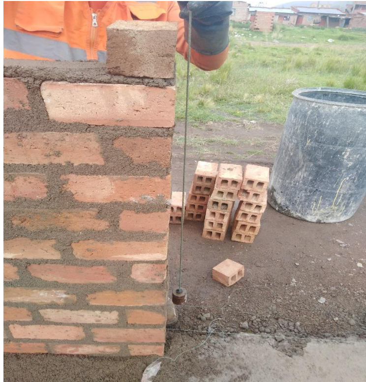
Imagen 40. Realizando verticalmente la plomada al inicio de colocación de ladrillo.
