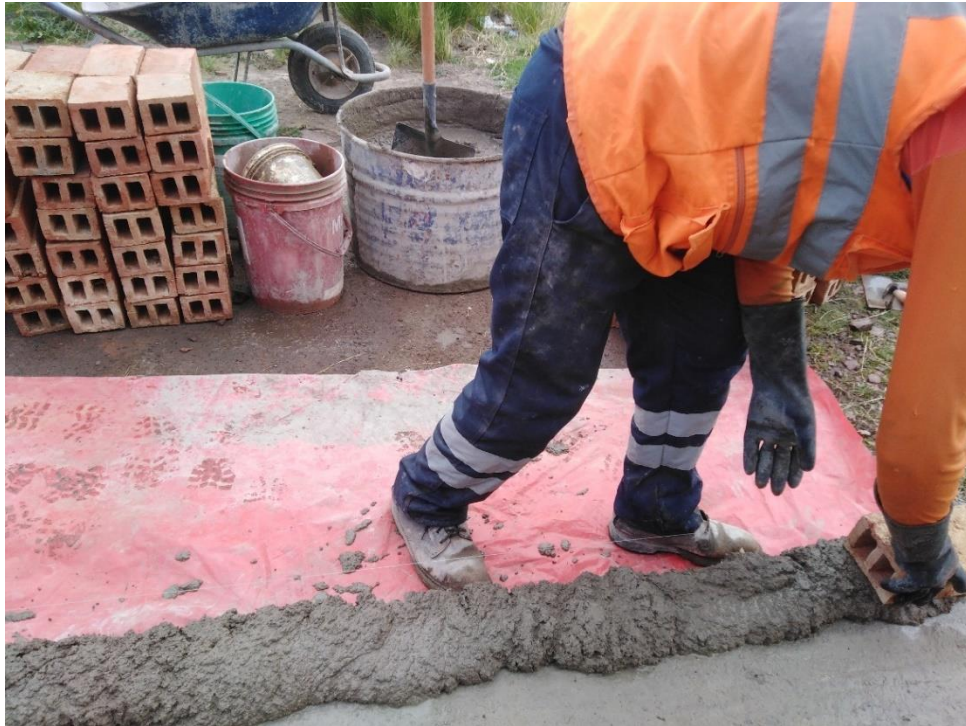
Imagen 46. Empastado de mortero en sobrecimiento.
