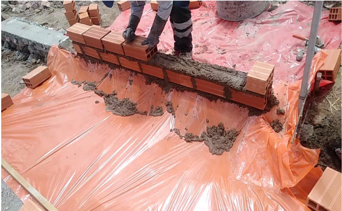
Imagen 34. Colocado de ladrillo en sentido de soga.
