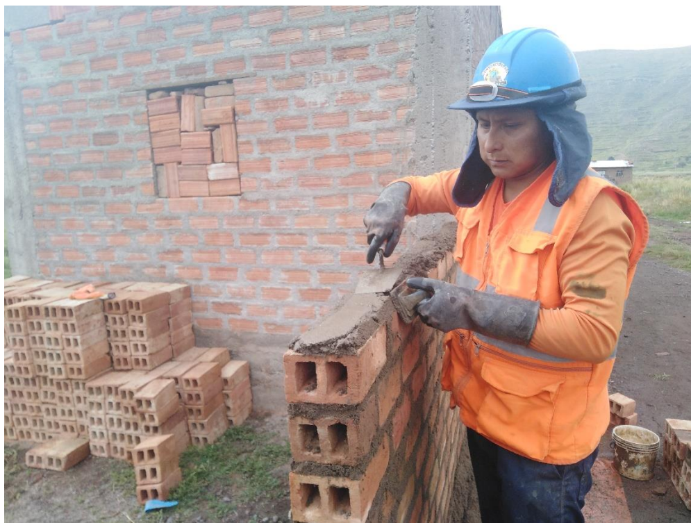
Imagen 39. Nivelado el mortero en la base de ladrillo un espesor de 1.5 cm.
