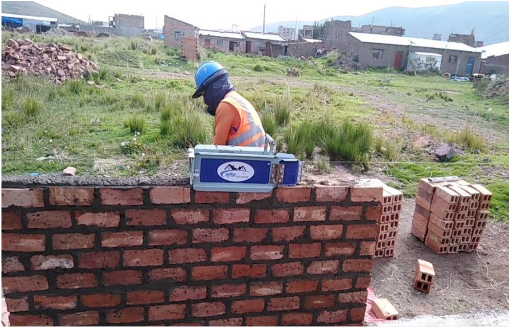
Imagen 54. Asentado y vaciado con el deslizador de mortero .
