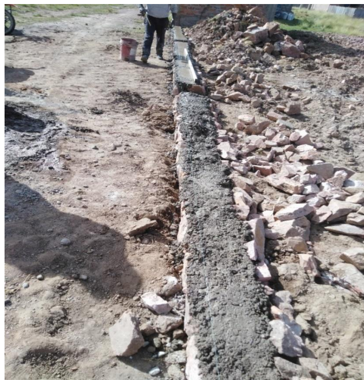
Imagen 25. Vaciado de concreto el sobrecimiento.
