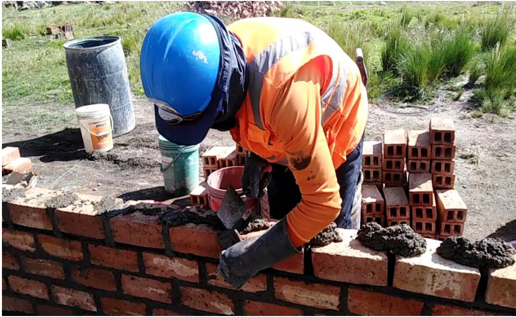
Imagen 50. Emboquillado de ladrillo pandereta o artesanal.
