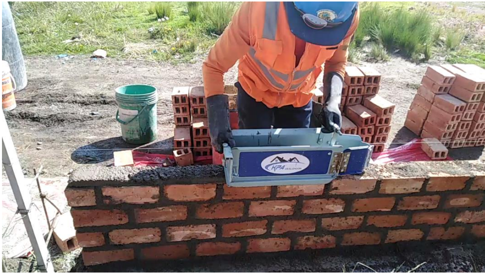
Imagen 14. Colocado de mortero con deslizador, en ladrillo artesanal.
