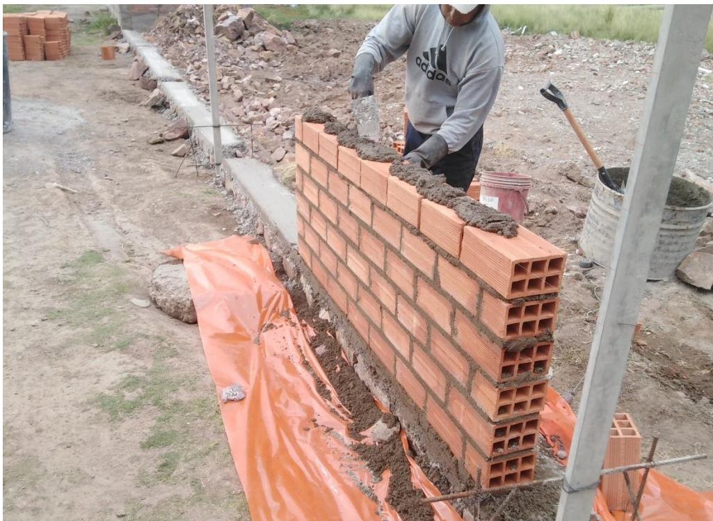
Imagen 9. Emboquillado de juntas alcanzando a 1.30 metros de altura.
