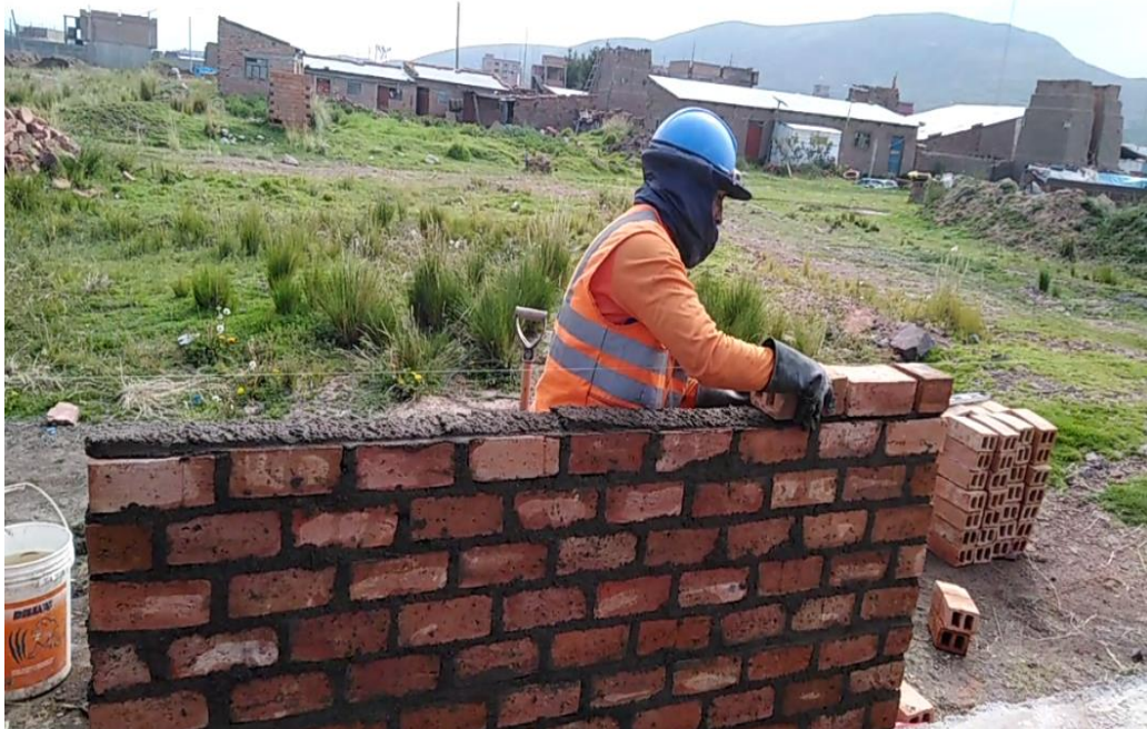
Imagen 55. Hilada de mortero y emboquillado.
