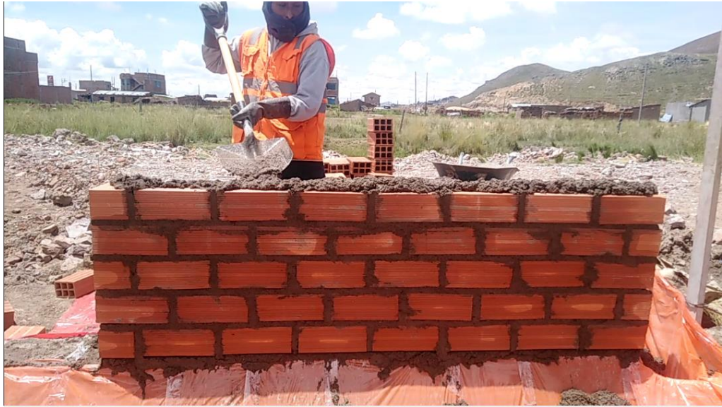
Imagen 08. Colocación de mortero longitudinalmente sobre el muro.
