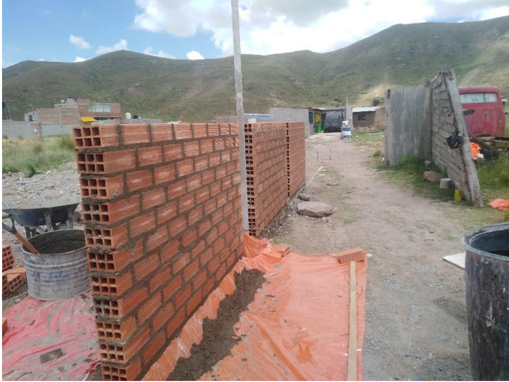
Imagen 64. Desperdicios de paños de asentamiento de ladrillo.
