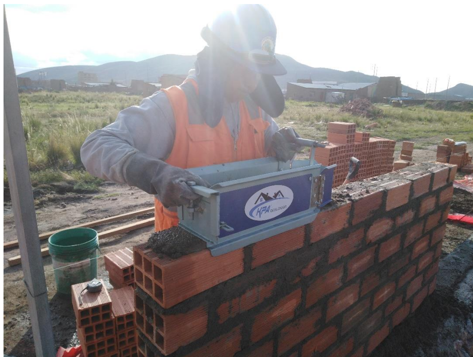
Imagen 13. Colocado de mortero con el deslizador de mortero.
