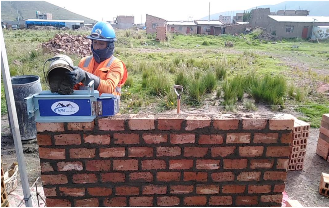
Imagen 52. Asentado con molde de deslizador de mortero
