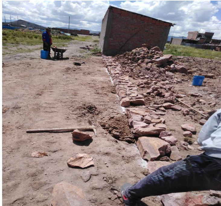
Imagen 24. Excavación manual y empedrado.
