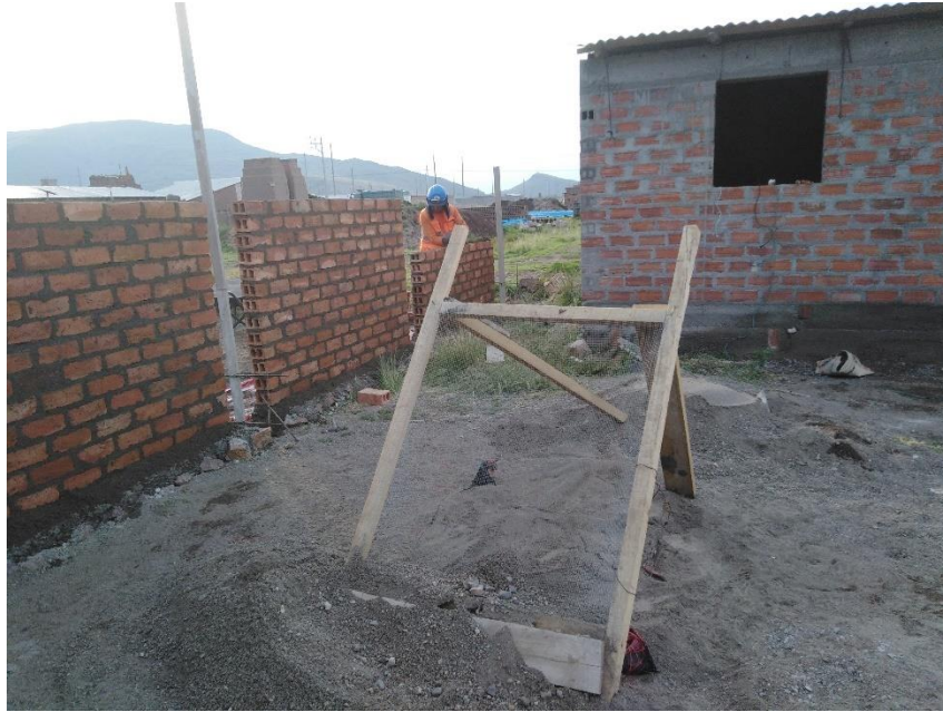
Imagen 06. Zarandeo de material para asentado de muro.
