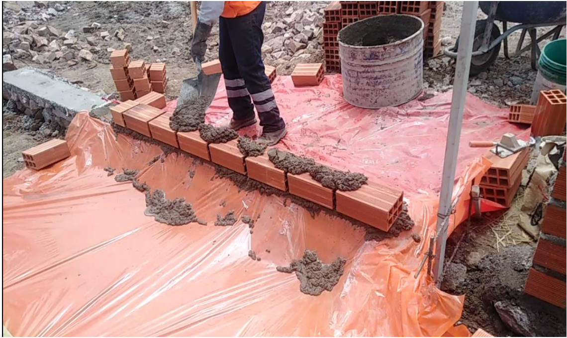
Imagen 32. Colocado de mortero en la base de ladrillo.
