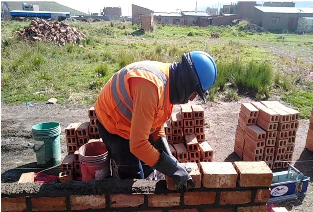
Imagen 49. Asentado de ladrillo de acuerdo al cordel.
