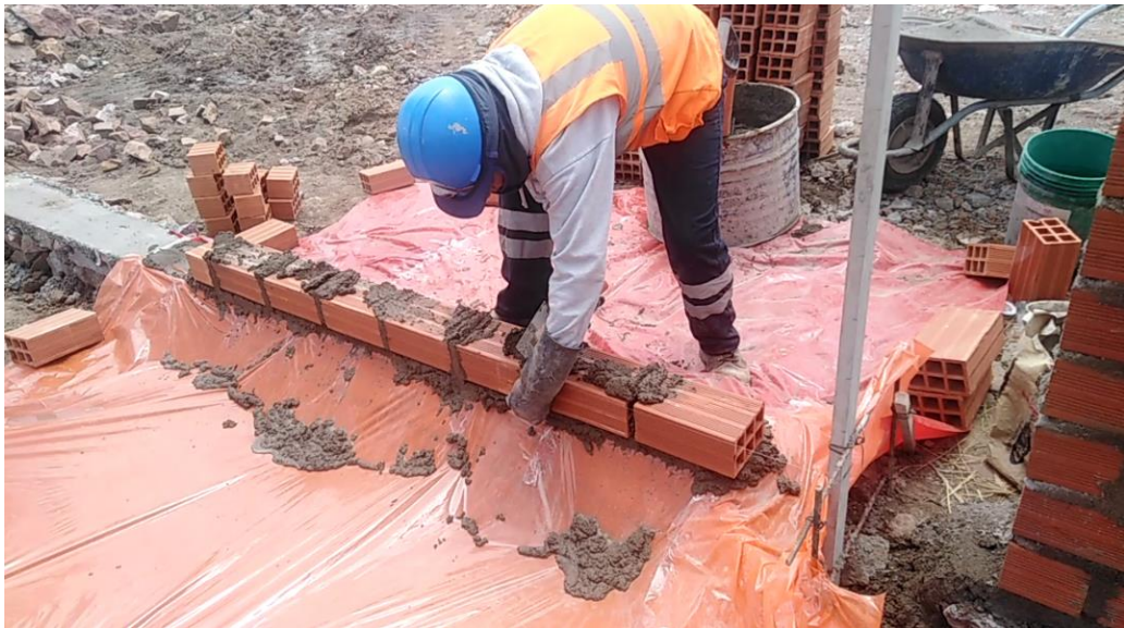
Imagen 07. Emboquillado de mortero en juntas verticales.
