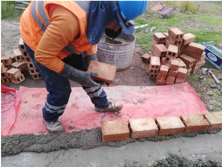
Imagen 10. Colocado de la primera hilada de ladrillo artesanal.
