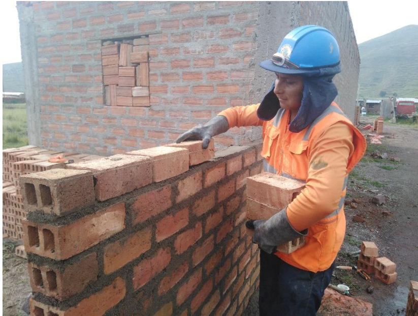
Imagen 42. Asentado de ladrillo de soga con espesor de 1.5 cm.
