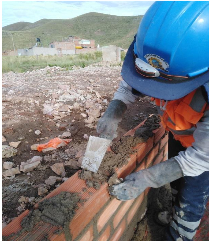
Imagen 60. Emboquillado con cuchara de mezcla y frotacho.
