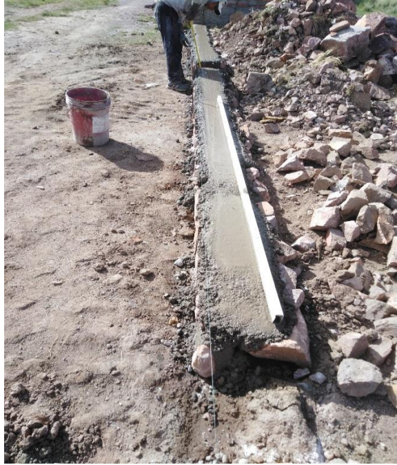
Imagen 26. Vaciado de sobrecimiento y nivelado con de aluminio.
