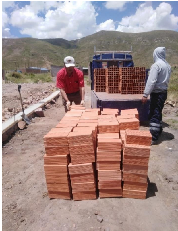
Imagen 27. Traslado de material al lugar de trabajo en moto carga
