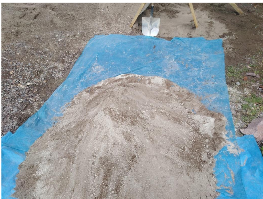
Imagen 29. Preparado de mezcla cemento y agregado fino.
