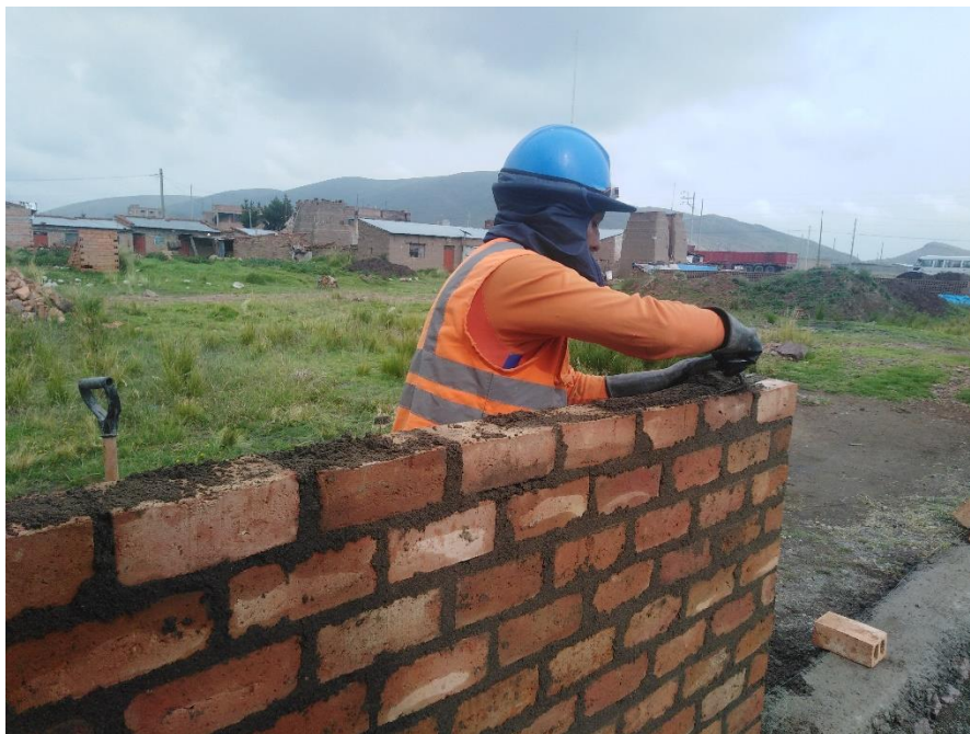
Imagen 11. Emboquillado final del muro a 1.30 metros de altura.
