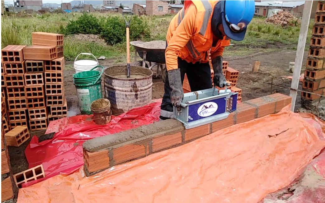
Imagen 57. Asentado de ladrillo con un concreto de 175 kg/cm 2
