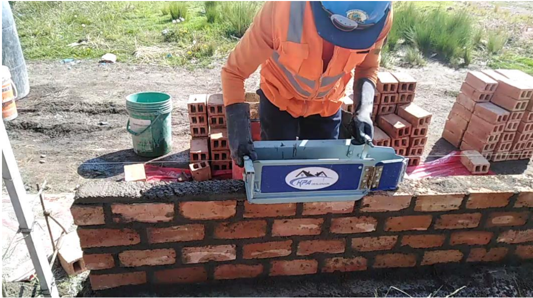
Imagen 48. Vaciado con molde de deslizador de mortero en la base de ladrillo.
