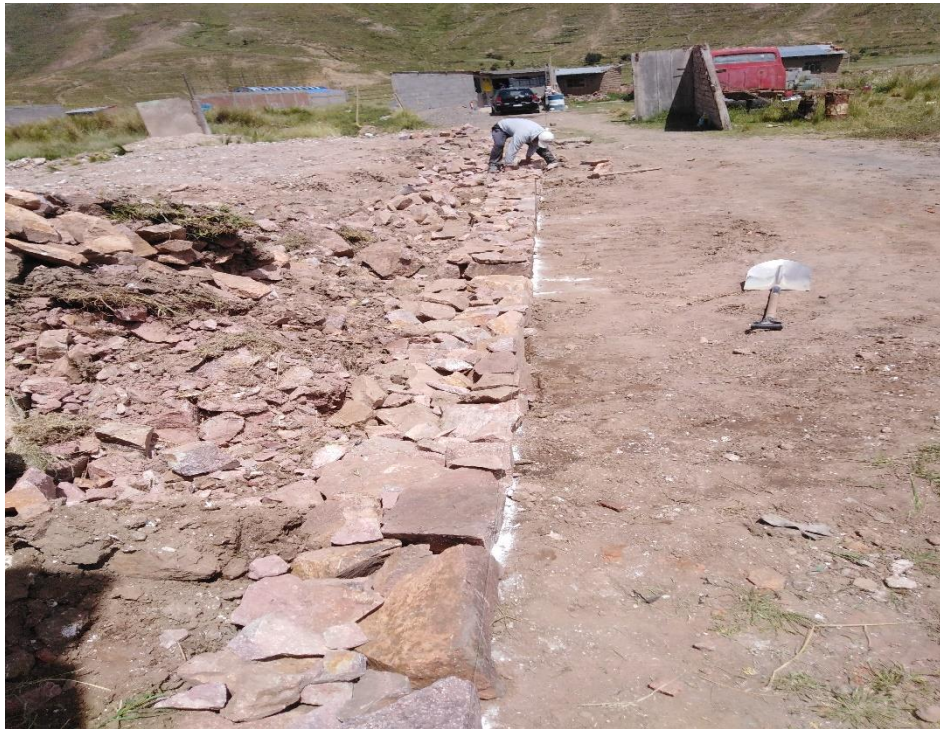
Imagen 23. Limpieza de terreno manual.
