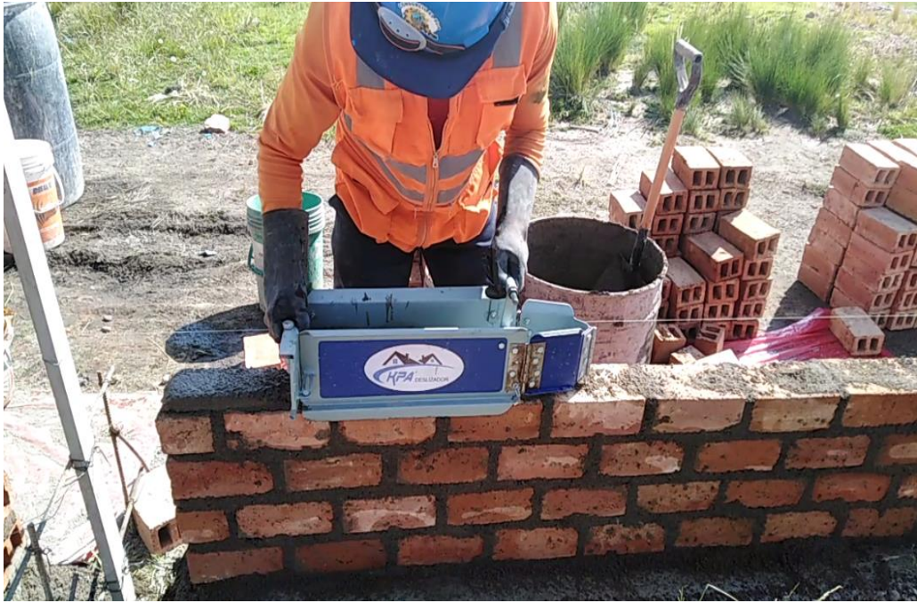
Imagen 58. Colocación de molde deslizador de mortero.
