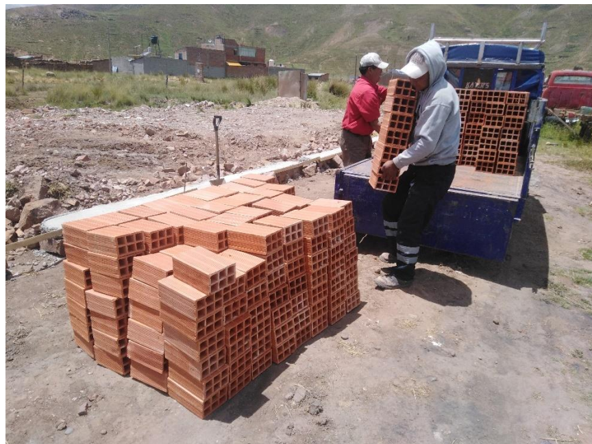
Imagen 05. Acarreo de ladrillo.
