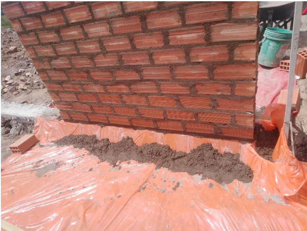
Imagen 65. Desperdicio de la parte frontal de paño de ladrillo.
