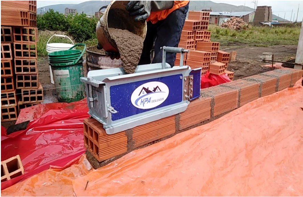
Imagen 56. Asentado y enrazado de paño de ladrillo.
