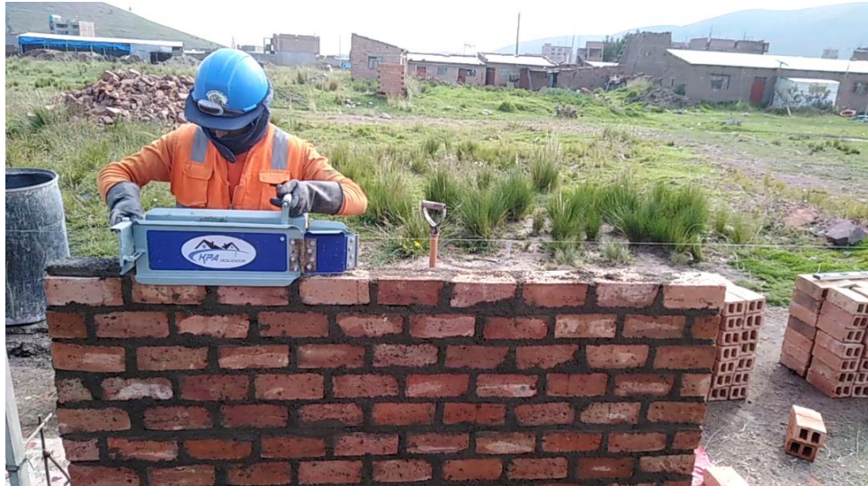
Imagen 16. Colocado de mortero con deslizador.
