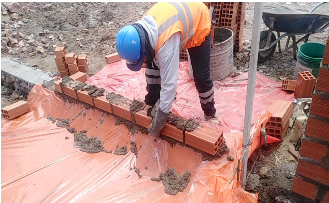
Imagen 33. Emboquillado de ladrillo con mortero.
