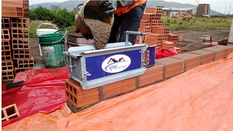
Imagen 12. Se empieza con la colocación del mortero en la primera hilada.
