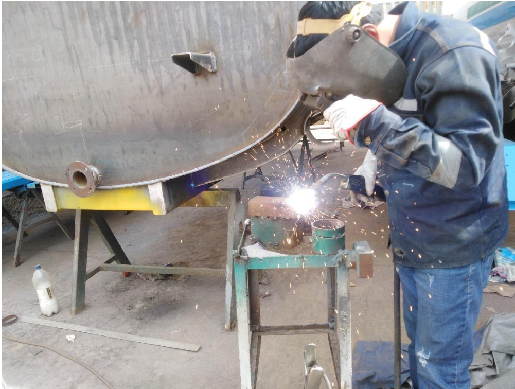
Imagen 20. Soldadura de deslizador de mortero.
