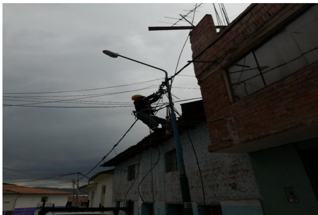
Instalación de fibra óptica FTTH
