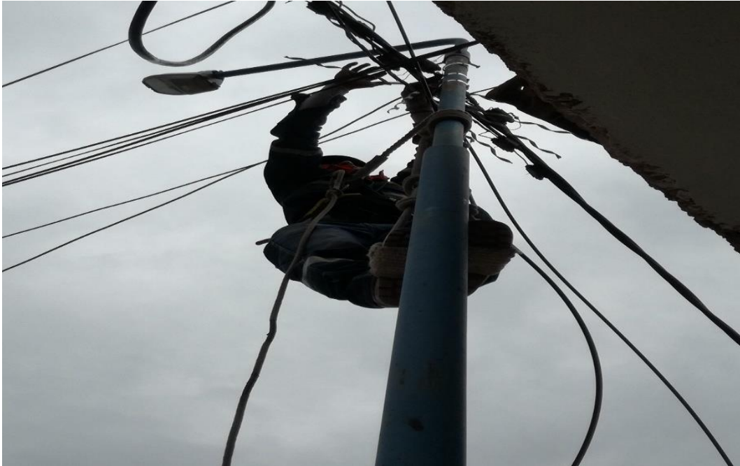
.Anclando la fibra óptica al poste de alumbrado publico
