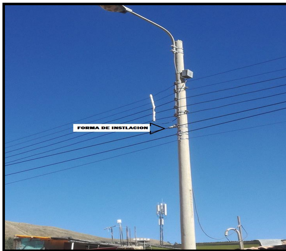
Figura 32. Instalación de postes y fibra óptica.
