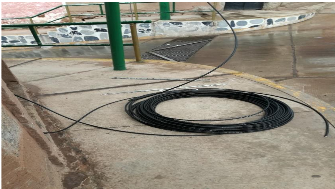
Cableando la fibra óptica a postes
