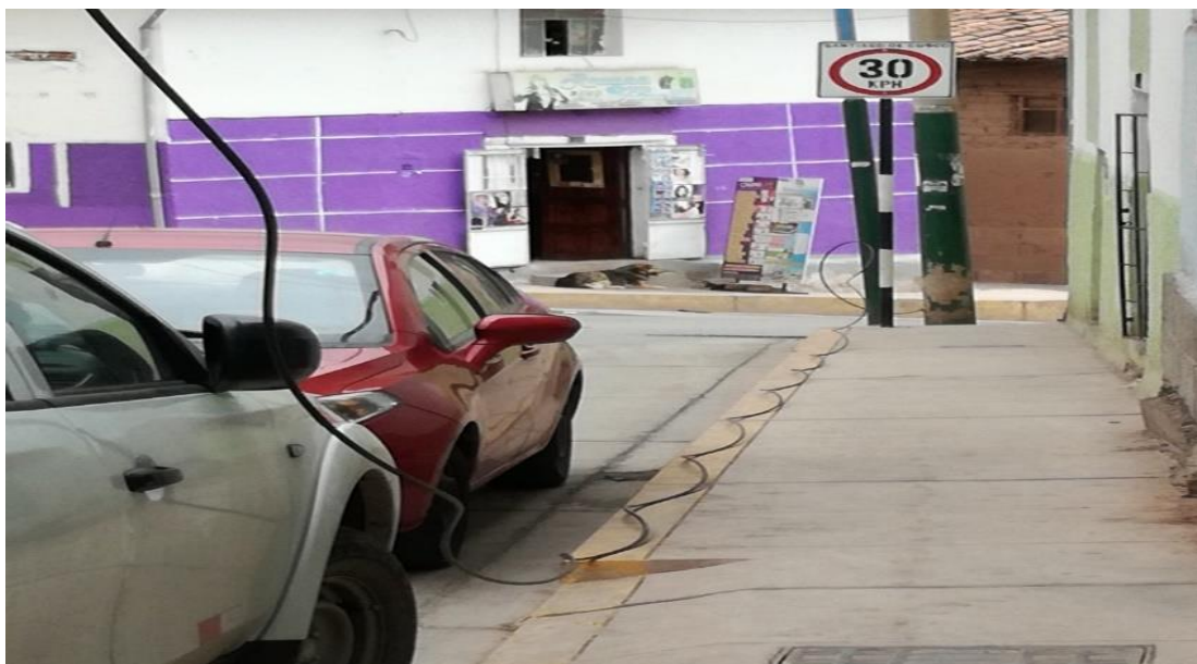
Tendido de fibra óptica para la institución educativa
