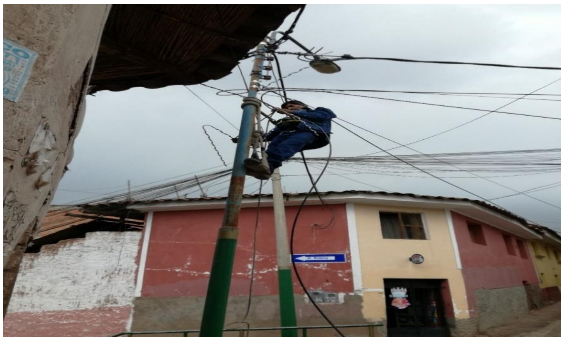
Cableando la fibra óptica a postes
