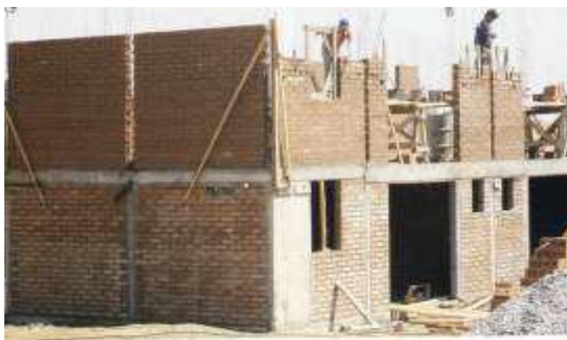
Figura 1. Construcción de albañilería confinada. Fuente: SENCICO (2005).
