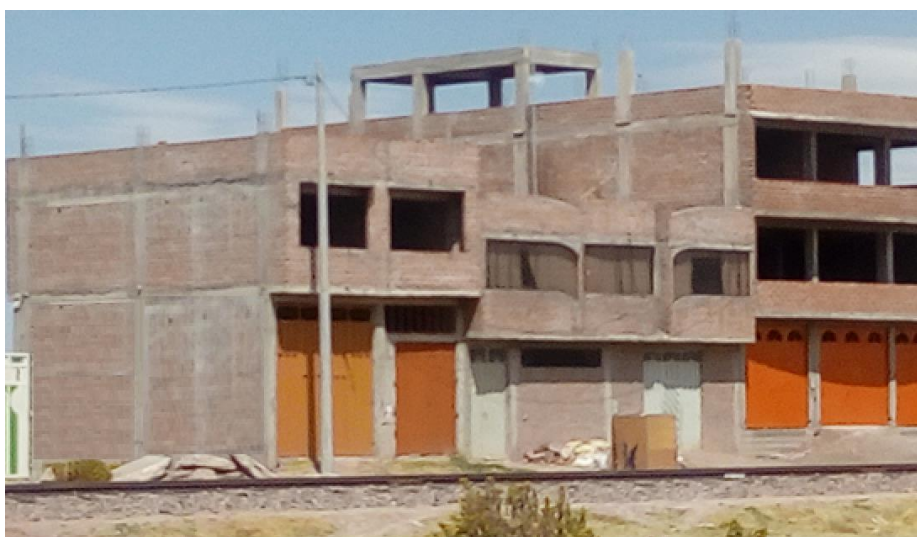
Figura 12. Edificaciones típicas de albañilería confinada de la ciudad de Juliaca.
