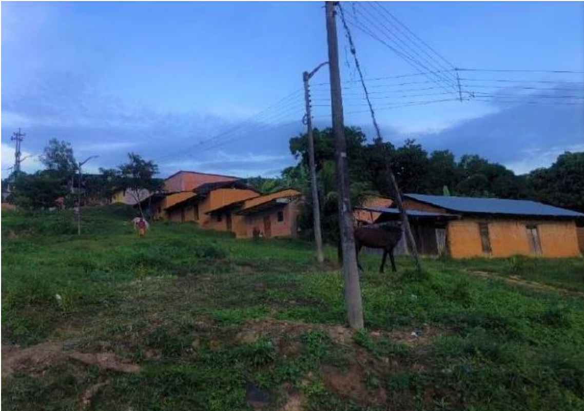
Figura 1. Fotografías correspondientes a la comunidad indígena del barrio Wayku, en el Perú, donde se puede observar su cultura de diseño vernacular, y habitar vernacular de sus viviendas actuales. (a) Módulos de espacios privados.
