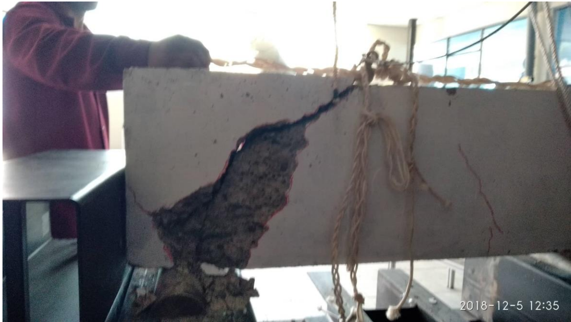
Detalle de falla de la viga de gran altura ensayada (VIGA 03)
