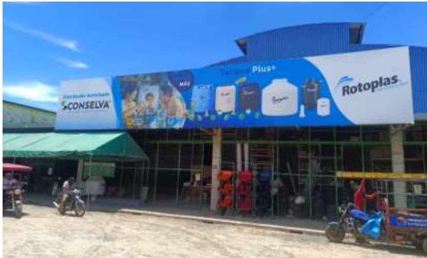
Bastidor metálico sobre techo
