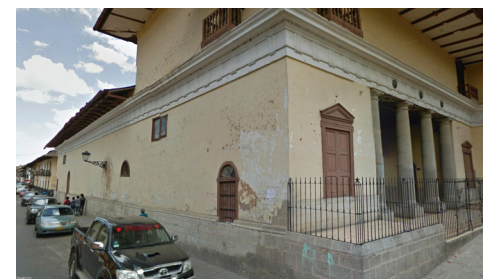
Fachada desde Jr. Junín
