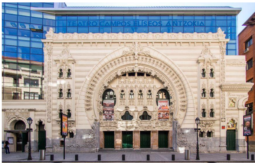
Figura 50. Fachada Principal Teatro Campos Elíseos. Fuente: https://goo.gl/NEHgcF
