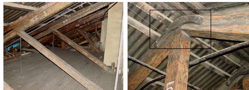
Figura 49. Refuerzo en estructuras Teatro Colón. Fuente: MPC, 2009
