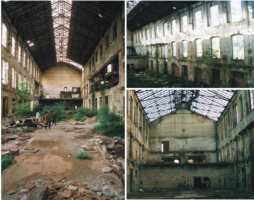
Figura 77. Estado del edificio antes de la intervención. Fuente: Fondazione Renzo Piano, 2001. https://goo.gl/L4wnna
