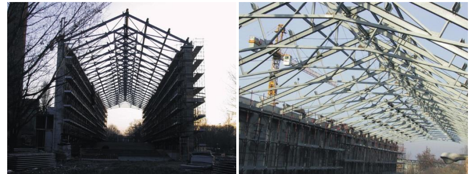
Figura 74. Proceso Constructivo Auditorio Niccolò Paganini. Fuente: Fondazione Renzo Piano, 2001. https://goo.gl/L4wnna
