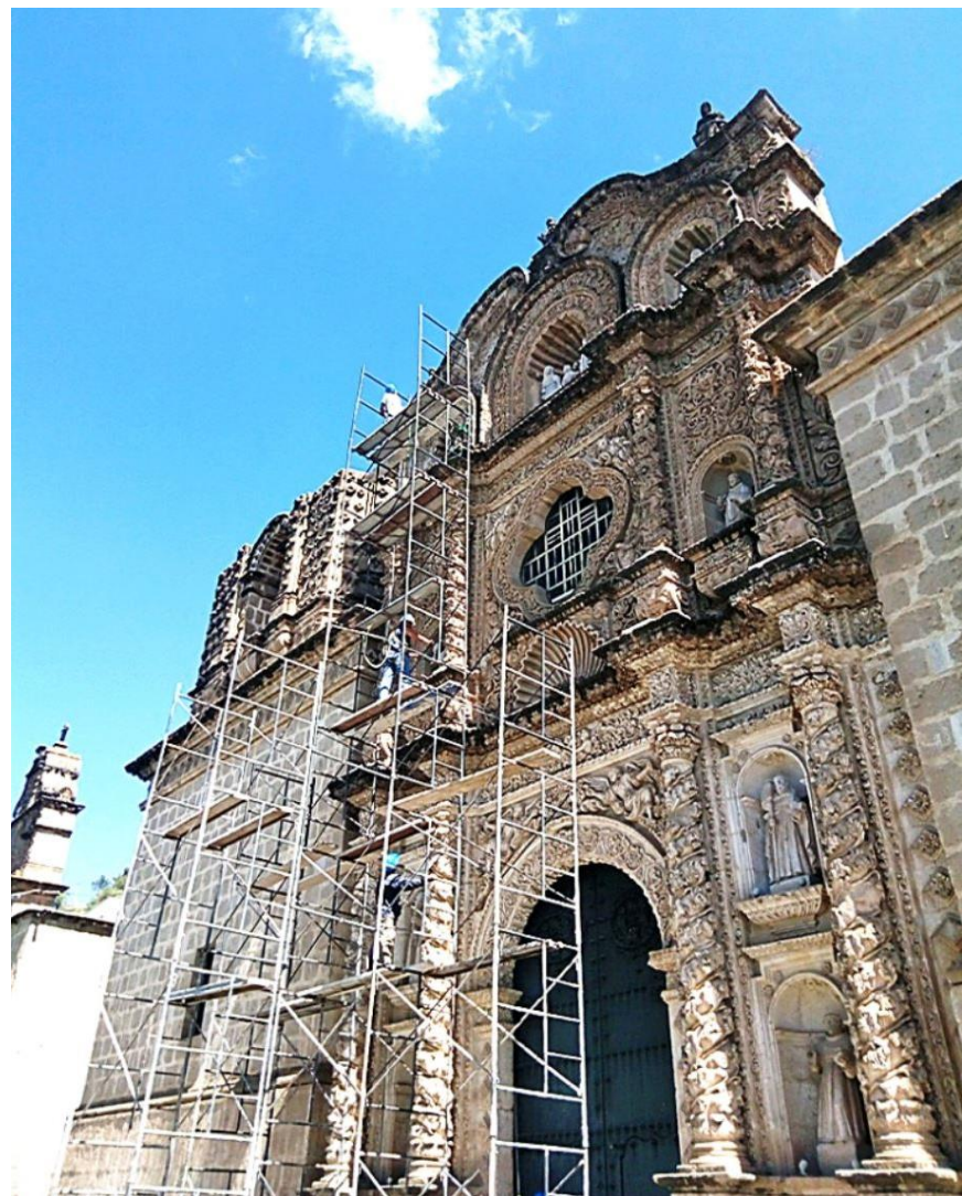
Figura 18. Intervención en fachada principal. Fuente: Andina.pe
