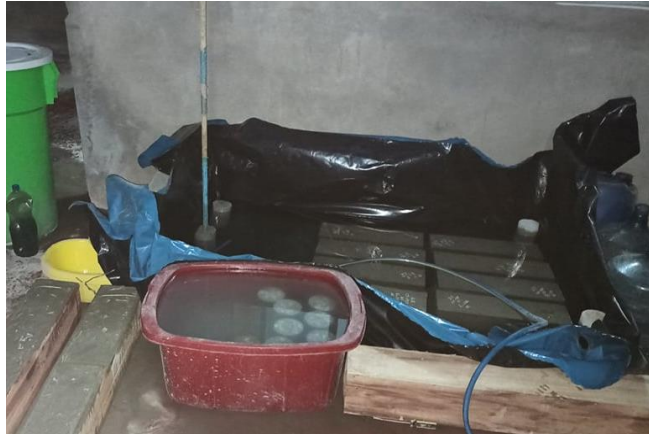
Imagen 9. Curado de vigas de concreto Fuente: Elaboración propia
