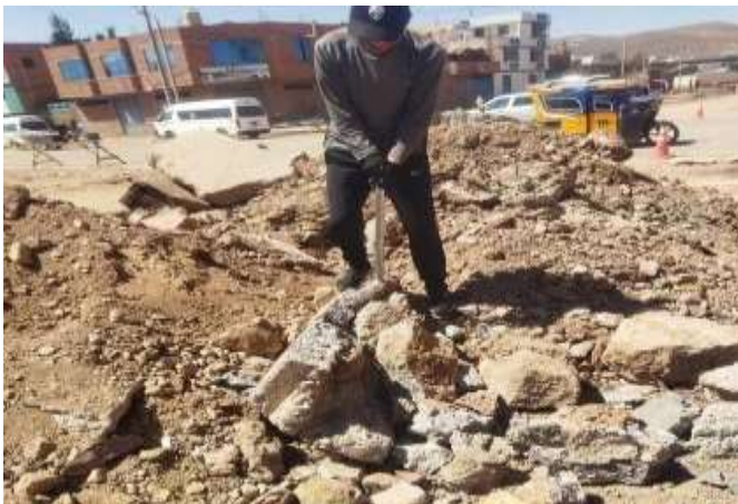
Figura 3: Obtención de materiales provenientes de residuos de concreto.
