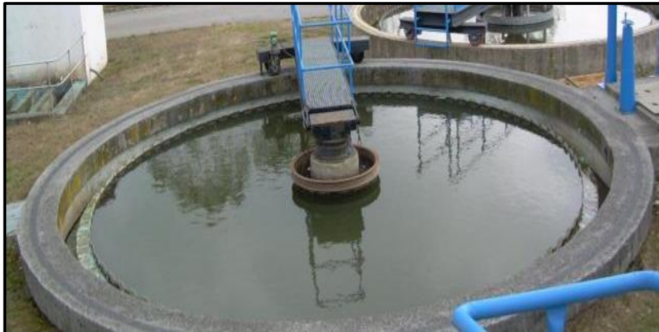
Figura 4. Tanque de sedimentación o decantación Fuente: (MINAM, 2009)
