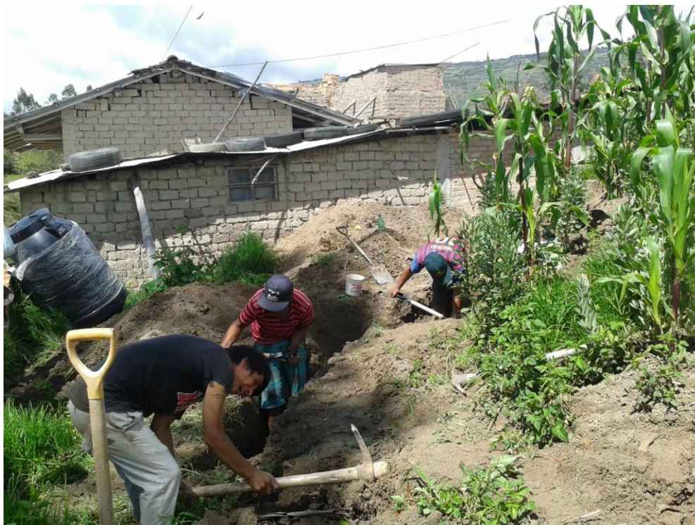
Figura 74. Excavación para las zanjas
