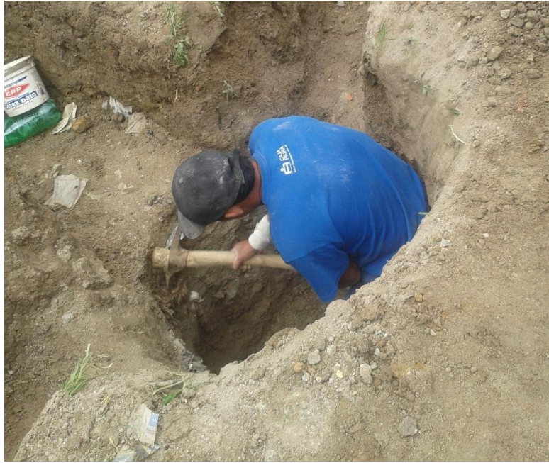
Figura 77. Excavación de la cama del biodigestor
