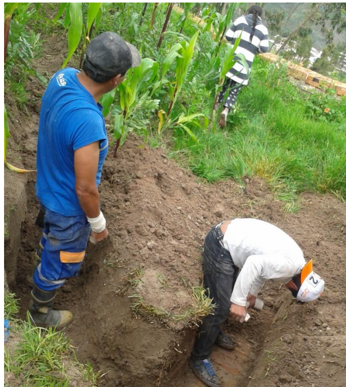
Figura 73. Limpieza del lugar para la implementación del sistema de tratamiento, mediante HAFSH
