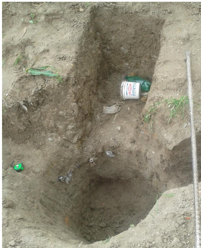
Figura 78. Excavación terminada de la Cama del biodigestor y cámara de lodos
