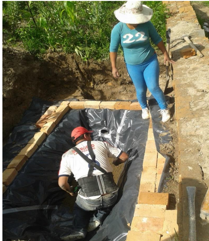
Figura 87. Cerco perimétrico de ladrillo alrededor del humedal para evitar que el lecho filtrante arrastre al plástico.
