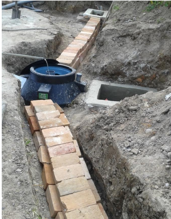
Figura 94. Llenado de agua no potable al biodigestor para realizar la prueba hidráulica
