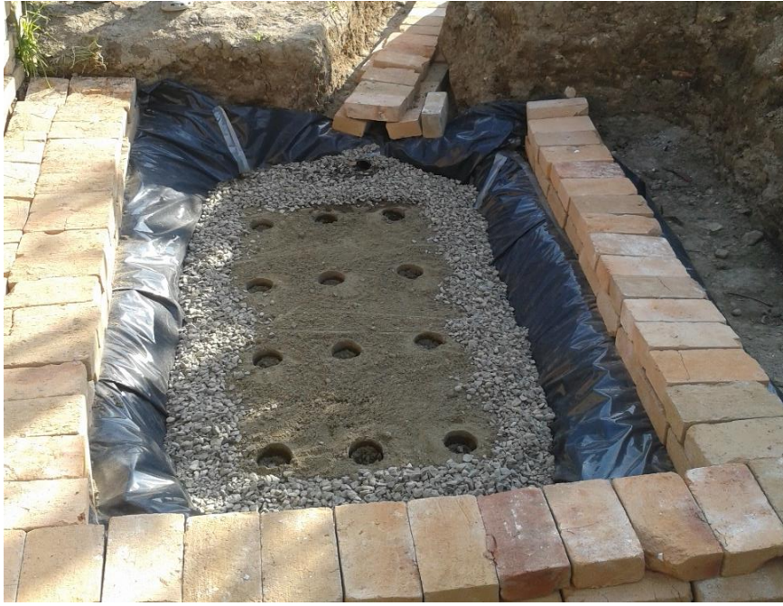
Figura 90. Excavación para la plantación de la especie Papiro
