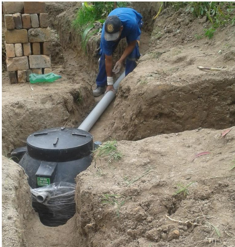
Figura 82. Biodigestor instalado
