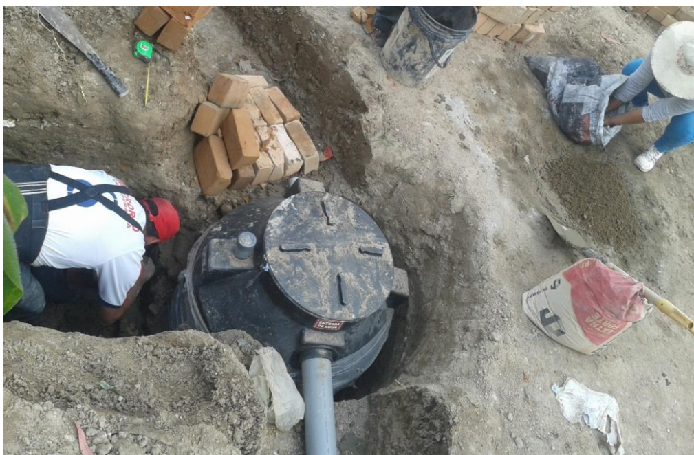
Figura 83. Construcción de la cámara de lodos
