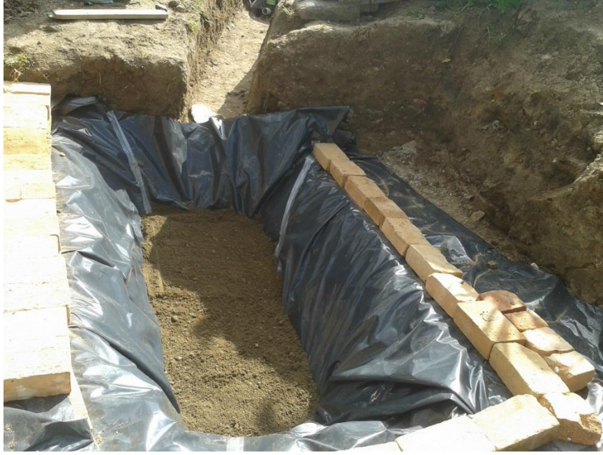
Figura 88. Llenado del lecho filtrante con arena
