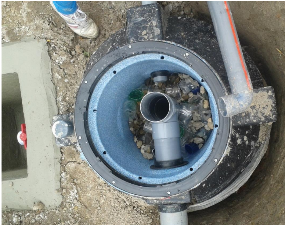
Figura 93. Colocación de capa de grava mediana al biodigestor para evitar que los aros de plástico (PETS) sean arrastrados por la tubería de salida y obstruyan el proceso
