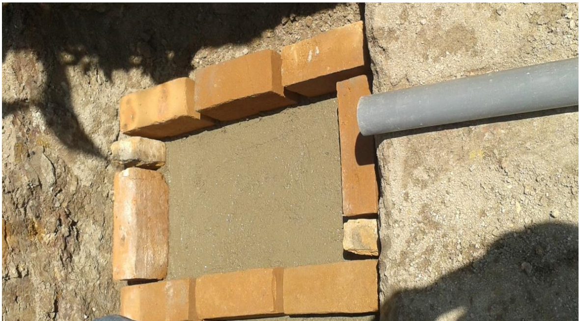
Figura 80. Construcción de la cámara de registro
