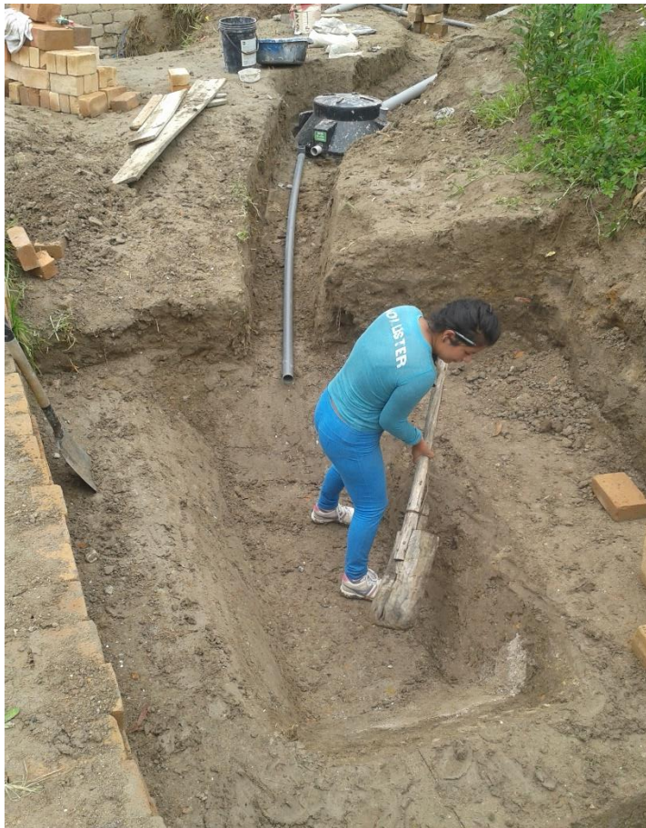
Figura 85. Excavación y compactación del HA
