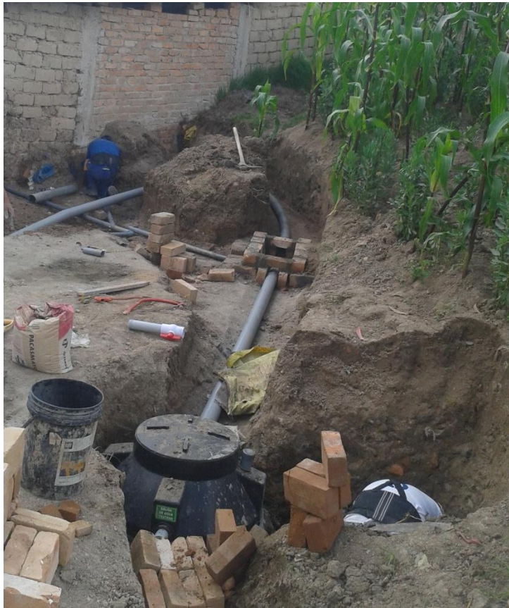
Figura 79. Instalación de tuberías
