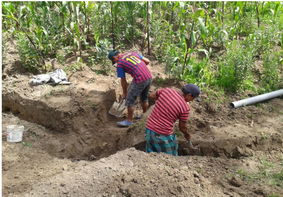
Figura 76. Excavación de la cámara de lodos
