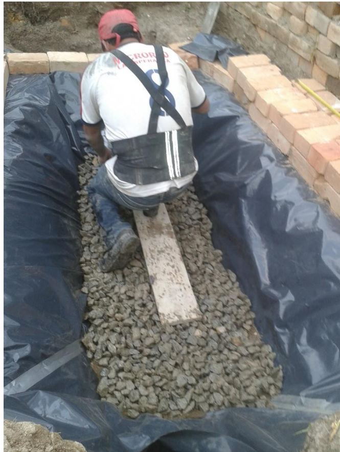
Figura 89. Llenado del lecho filtrante con grava
