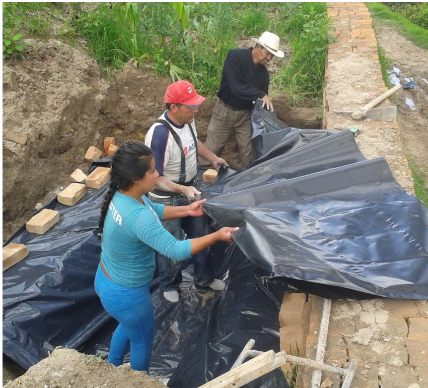
Figura 86. Revestimiento con plástico al HAFSH
