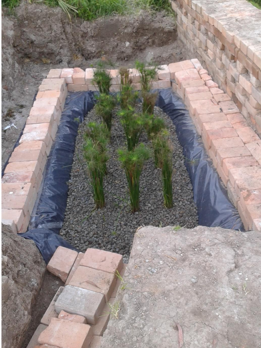
Figura 92. Implementación del HAFSH terminado
