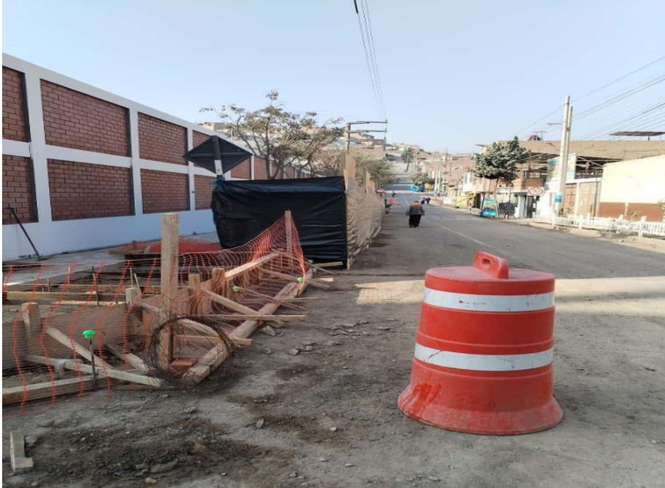
Figura 11 Protección colectiva en obra
