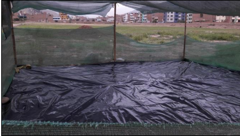
Figura 10. Instalación de Estructura.
