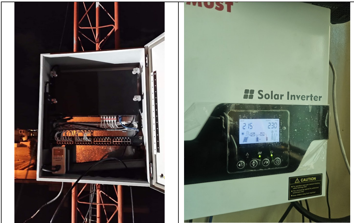
Figura 12. Instalación y mantenimiento de Respaldo de energía con Paneles Solares para los nodos
