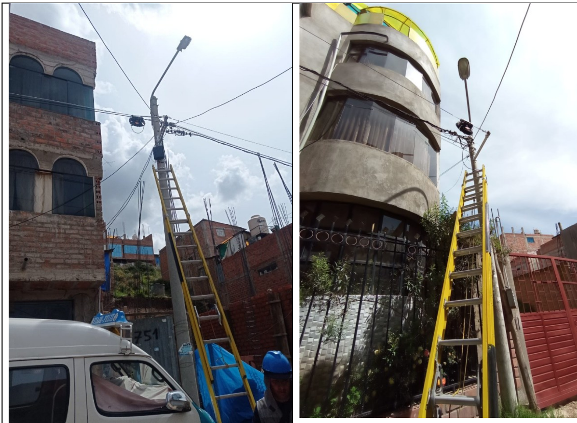
Figura 2. Trabajo de tendido aéreo de fibra óptica
