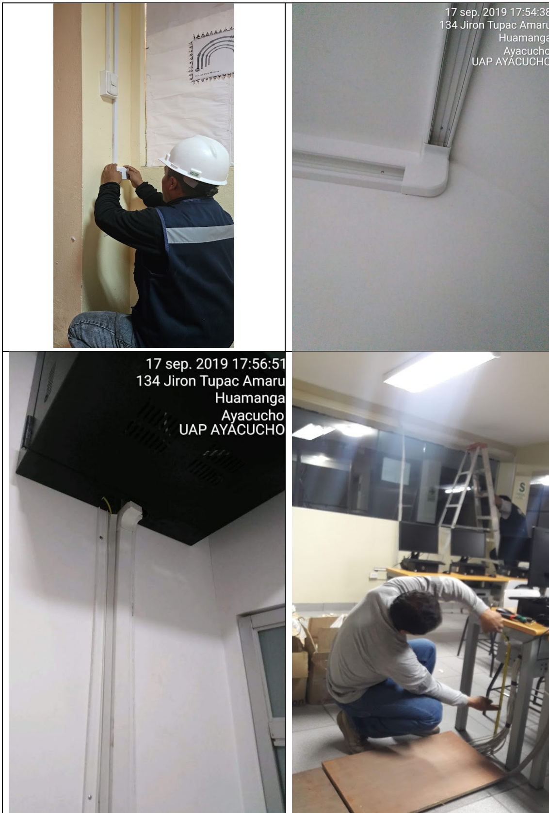
Figura 11. Implementación y certificación de cableado estructurado en oficinas de instituciones públicas y privadas.
