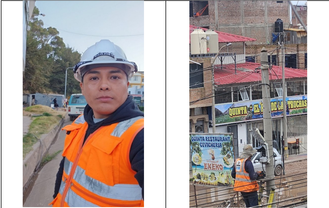
Figura 1. Instalación de cajas NAP en postes para distribución de fibra óptica.
