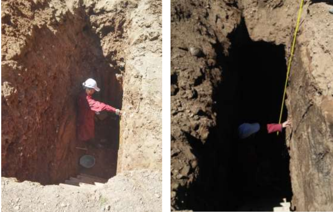
Figura 28: Excavaciones a base de pozos a cielo abierto.
