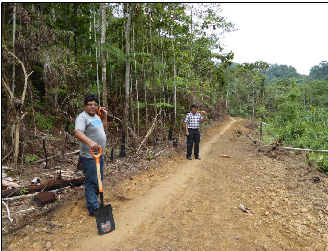
Fotografía 2. Verificación en obras de mantenimiento – Apertura de carretera.
