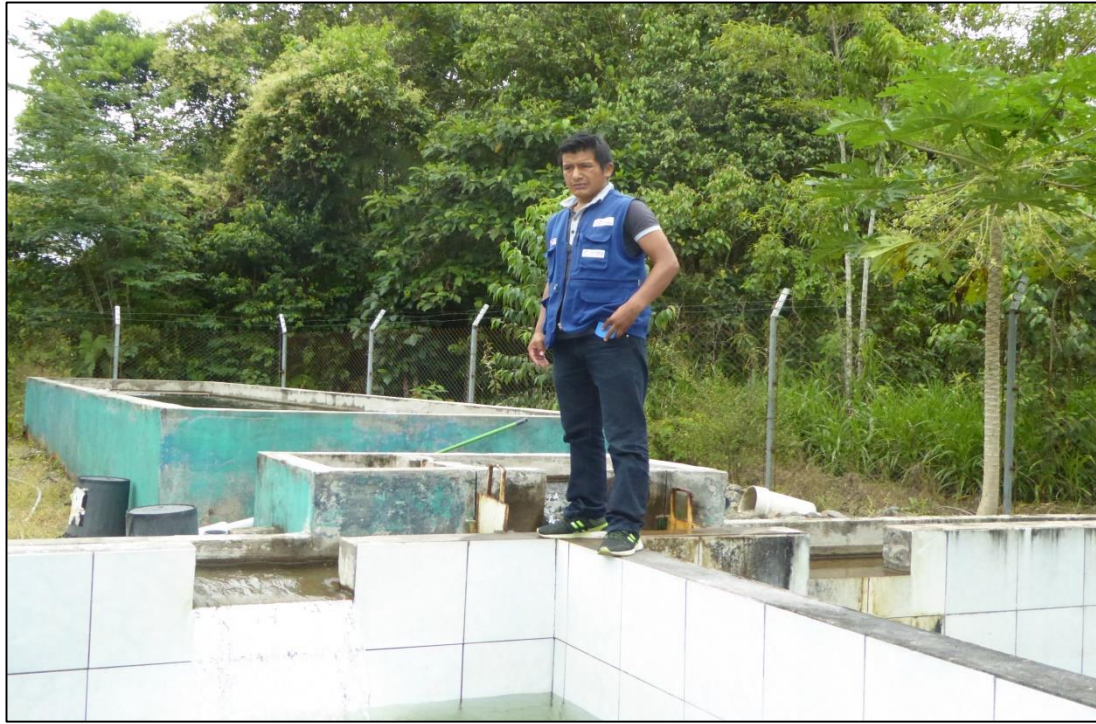
Fotografía 7. Verificación de tanques de suministro de agua.
