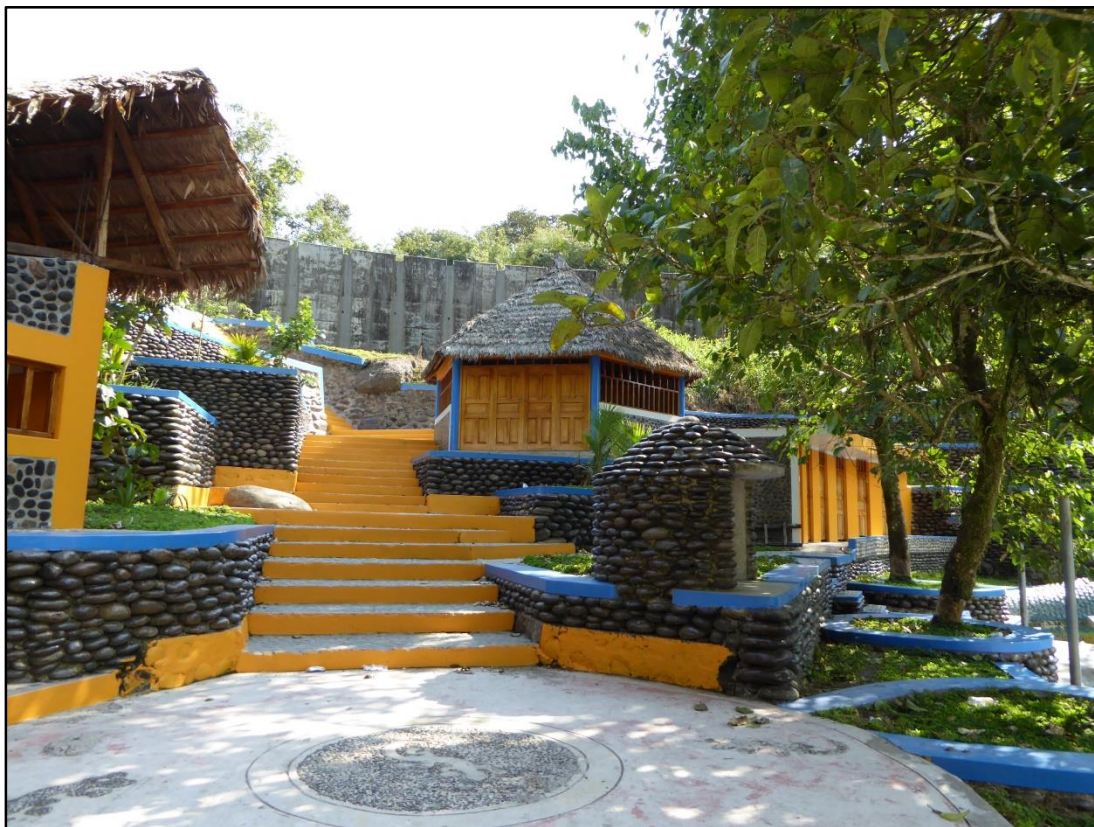
Fotografía 1. Verificación en obras de mantenimiento – Boca de Lagarto.
