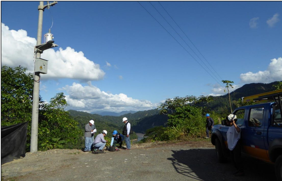
Fotografía 6. Verificación en obras por contrata – electrificación.
