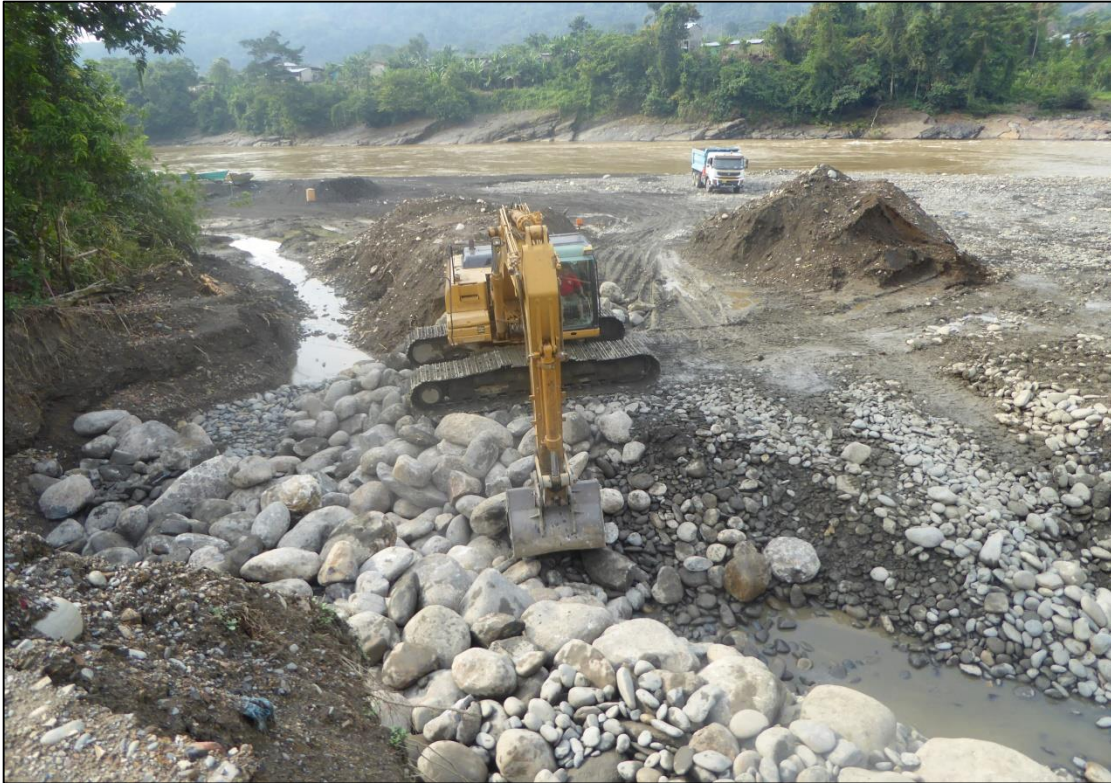
Fotografía 5. Verificación en obras de represamiento.
