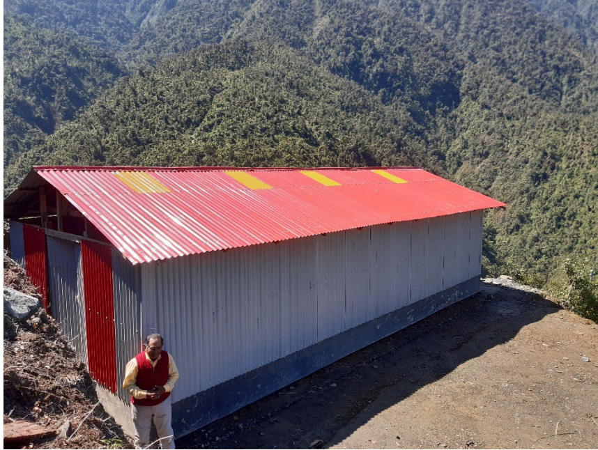
Tercera fase: templo Cumbre San Juan terminado.
