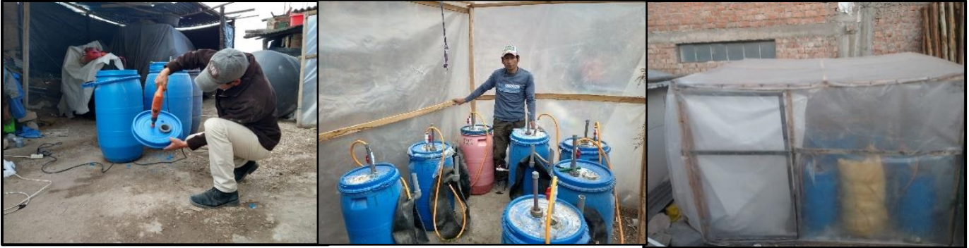
Figura 2 , Construcción e instalación de biodigestor
