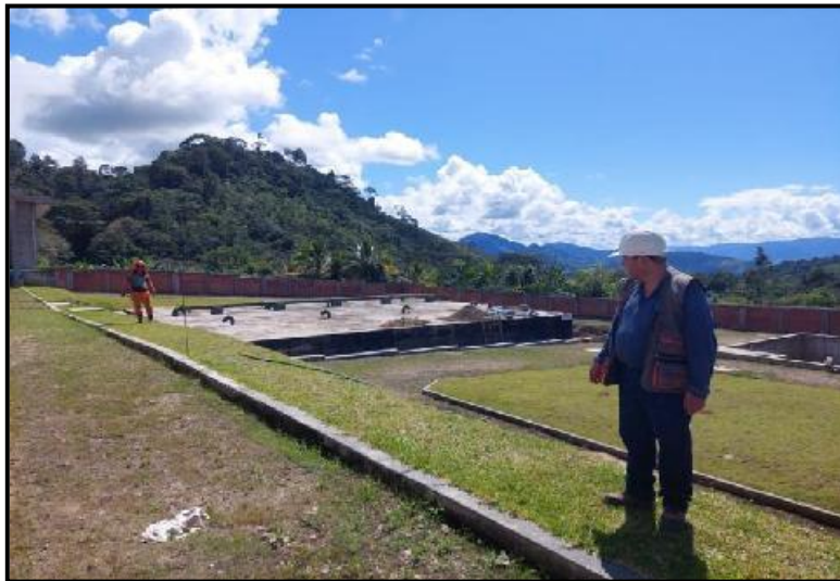
Figura N°12: Vista panorámica del Reservorio R-02 V=2400m 3 . Fuente: Elaboración Propia .
