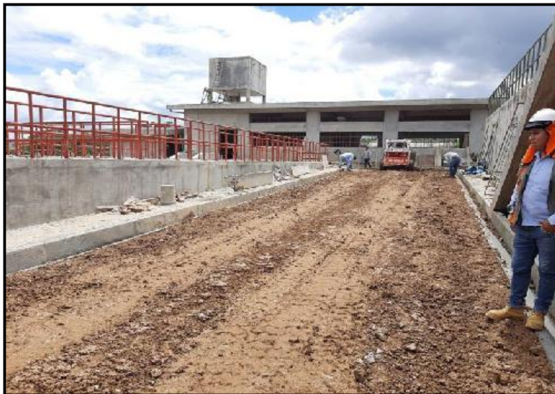
Figura N°11: Planta de tratamiento de agua potable Bolívar. Fuente: Elaboración Propia
