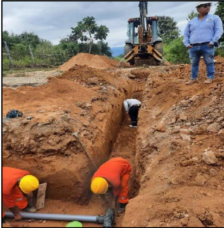
Figura N°15: Instalación de tubería PVC UF DN=90MM, TEE 90x90. En el sector 01 Fuente: Elaboración Propia
