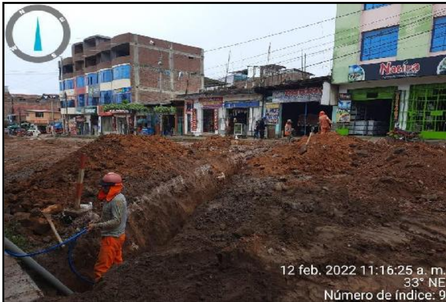
Figura N°16: Instalación de tubería HDPE ½" para conexión domiciliar de agua. Fuente Elaboración Propia.
