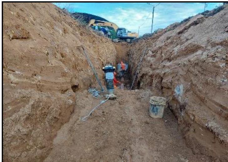
Figura N°18: Instalación de tubería PVC UF DN=250MM Serie 20. Para tramos profundos mayor a 3m. Fuente: Elaboración Propia.
