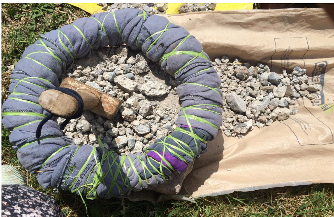
Fotografía 6. Demolición manual de la columna a reciclar
