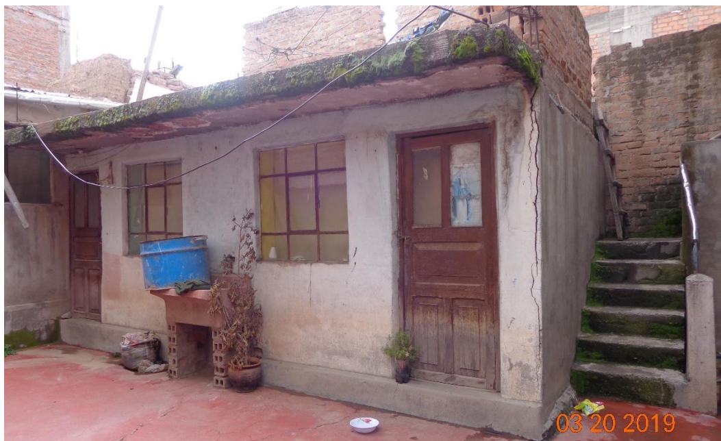
Fotografía 56. Muestra de viga para el ensayo de esclerómetro.
