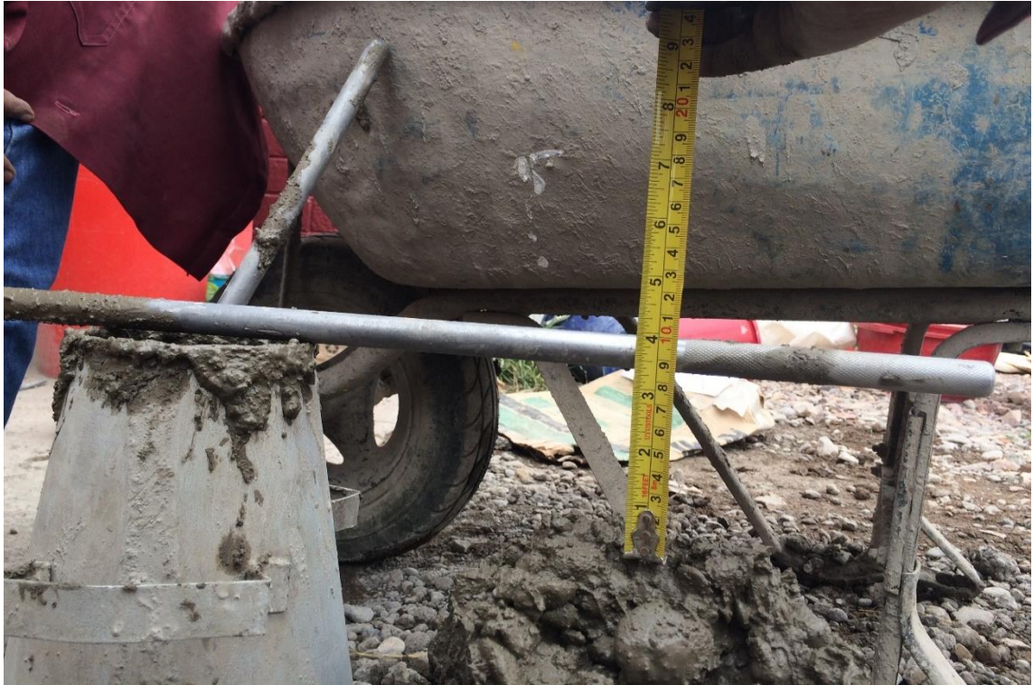
Fotografía 39. Medida del slam del concreto
