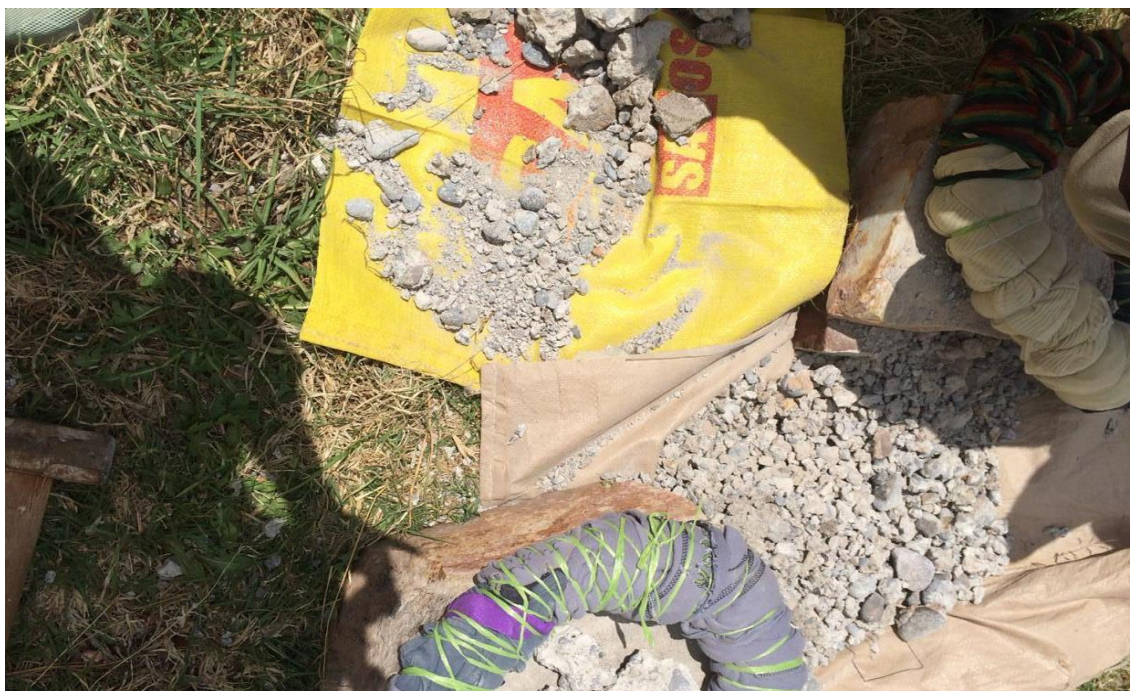
Fotografía 5. Rondana para el proceso de demolición manual
