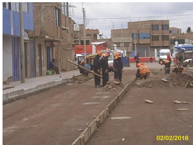
FOTOGRAFÍA N°08. Encofrado de pavimento rígido en el Jr. 4 de abril. Febrero del 2016.
