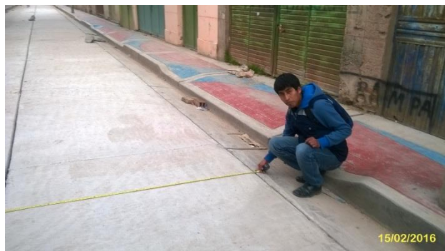
FOTOGRAFÍA N° 12. Medición del pavimento rígido del Jr. La merced. Febrero 2016.
