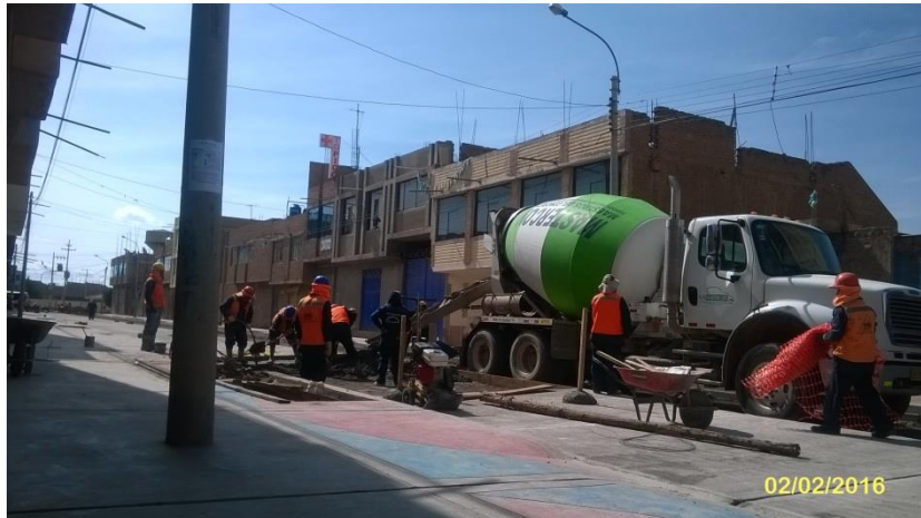
FOTOGRAFÍA N° 05. Colocado del concreto premezclado en el Jr. 4 de abril. Febrero del 2016.
