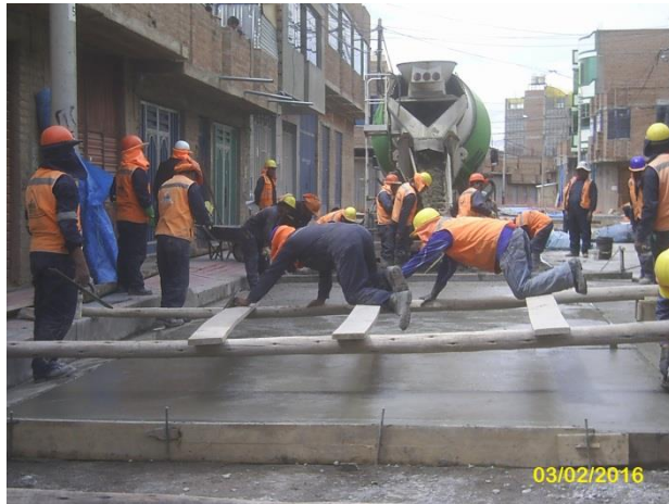
FOTOGRAFÍA N°10. Colocado del concreto premezclado en el Jr. 6 de agosto. Febrero del 2016.
