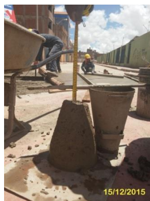
FOTOGRAFÍA N° 03. Haciendo la prueba del slump con el cono Abrams. Diciembre del 2015.
