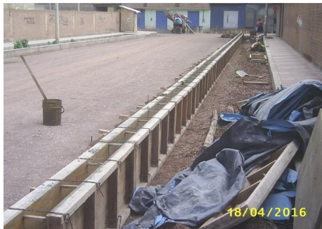
FOTOGRAFÍA N° 14. Encofrado para Sardinell, Jr. Brasil C-4. Abril del 2016.
