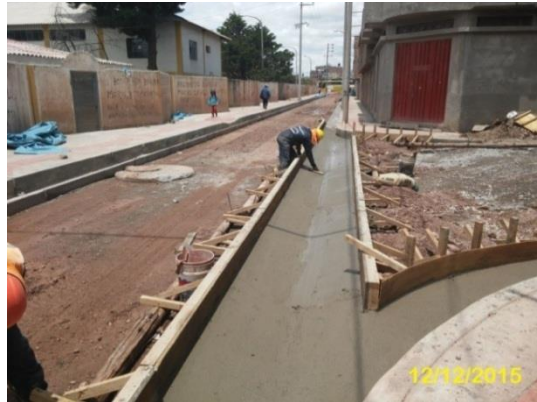
FOTOGRAFÍA N° 01. Colocado del concreto en cunetas del Jr. Vilquechico (AV. Huancané-AV. Santa Rosa). Diciembre 2015.
