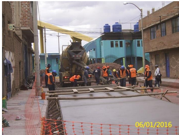
FOTOGRAFÍA N° 31. Colocado del concreto premezclado en el Jr. Pachacutec C-1. Enero del 2016.
