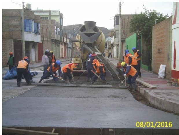
FOTOGRAFÍA N° 36. Colocado del concreto premezclado en el Jr. Pachacutec C-2. Enero del 2016.
