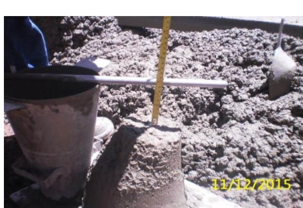
FOTOGRAFÍA N° 23. Haciendo la prueba del slump con el cono Abrams. Diciembre del 2015.
