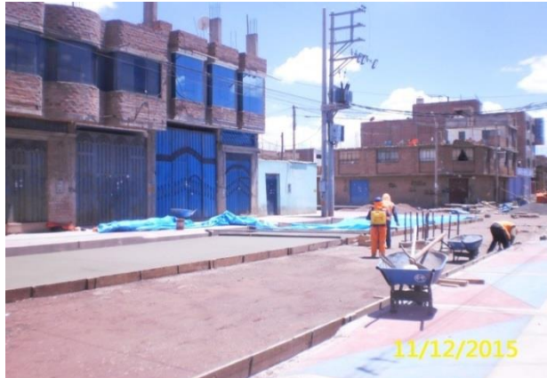
FOTOGRAFÍA N° 25. Encofrado para el colocado del concreto premezclado del siguiente carril Jr. Victor Humareda. Diciembre del 2015.
