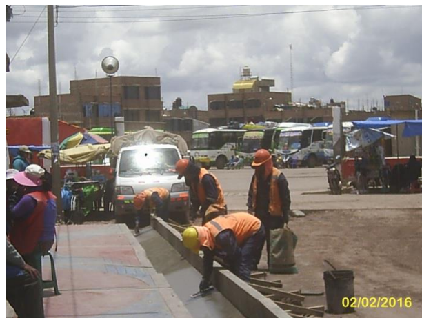
FOTOGRAFÍA N°09. Colocado del concreto en cunetas del Jr. 4 de abril. Febrero del 2016.
