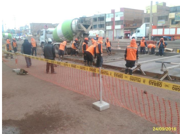
FOTOGRAFÍA N° 40. Colocado de concreto Premezclado fibro-reforzado F'C=300Kg/cm 2 . Septiembre 2016.
