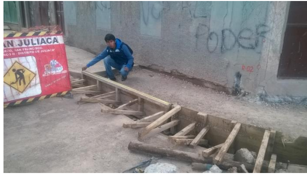
FOTOGRAFÍA N°07. Medición del encofrado para colocación de concreto en veredas. Enero del 2016
