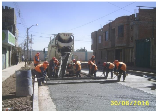
FOTOGRAFÍA N° 21. Colocado del concreto premezclado en el Jr. Brasilia. Junio del 2016.
