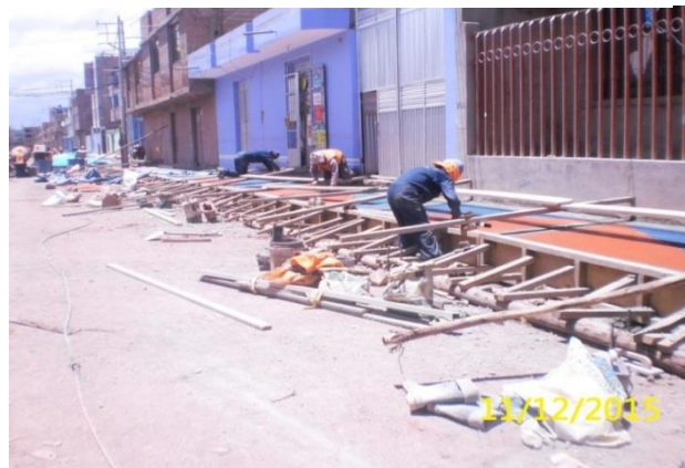
FOTOGRAFÍA N° 24. Colocación de concreto en veredas Jr. Victor Humareda C-3. Diciembre del 2015.
