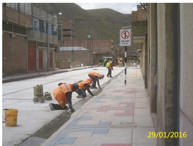
FOTOGRAFÍA N° 39. Acabado en cunetas en el Jr. Pachacutec C-4. Enero del 2016.
