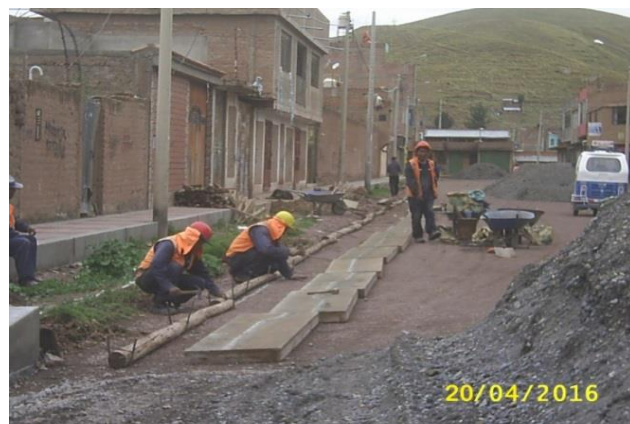
FOTOGRAFÍA N° 15. Encofrado para Sardinell, Jr. Quito. Abril del 2016.
