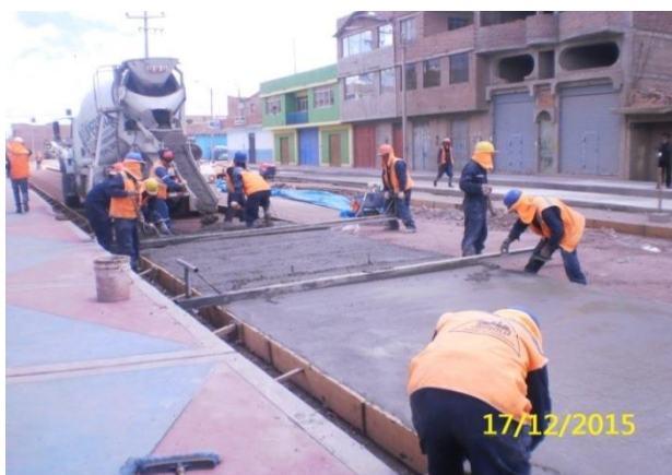
FOTOGRAFÍA N° 27. Colocado del concreto premezclado en el Jr. Torre Tagle. Diciembre del 2015.
