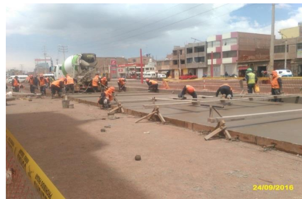
FOTOGRAFÍA N° 42. Colocado de concreto Premezclado fibro-reforzado F'C=300Kg/cm 2 , donde se aprecia a toda la cuadrilla. Septiembre 2016.
