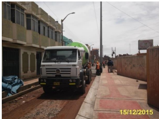
FOTOGRAFÍA N° 02. Camión mezclador de concreto en el Jr. Vilquechico (AV. Huancané-AV. Santa Rosa). Diciembre 2015.
