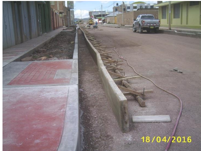
FOTOGRAFÍA N° 13. Encofrado para cunetas Tipo I, Jr. Brasil C-2 y C-3. Abril del 2016.
