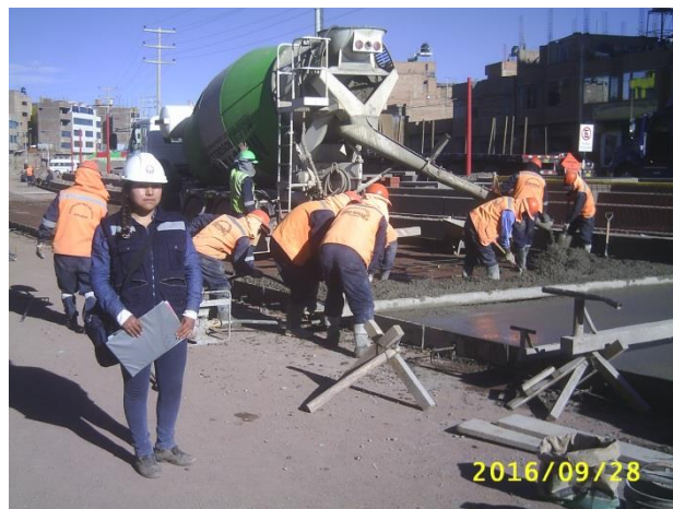
FOTOGRAFIA N° 45. Colocado de concreto Premezclado fibro-reforzado F'C=300\text{Kg/cm}^2 . Septiembre 2016.
