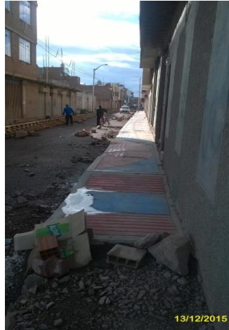
FOTOGRAFÍA N° 04. Encofrado para vereda del Jr. La Merced. Diciembre del 2015.
