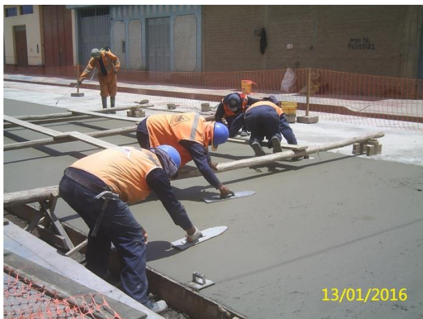
FOTOGRAFÍA N° 37. Acabado del pavimento rígido. Enero del 2016.
