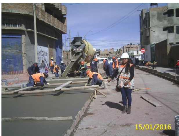
FOTOGRAFÍA N° 38. Colocado del concreto premezclado en el Jr. Huayna Roque C-1. Enero del 2016.
