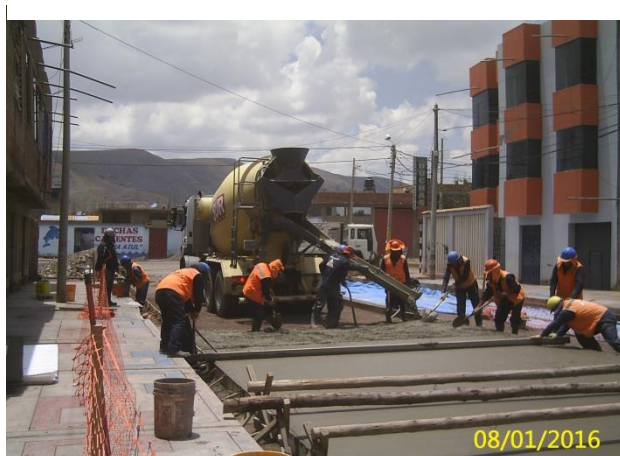
FOTOGRAFÍA N° 33. Colocado del concreto premezclado en el Jr. Australia. Enero del 2016.
