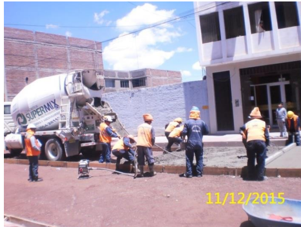
FOTOGRAFÍA N° 22. Colocado de concreto premezclado en el Jr. Victor Humareda. Diciembre del 2015.
