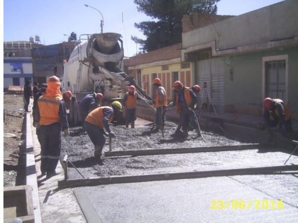
FOTOGRAFÍA N° 19. Colocado del concreto premezclado en el Jr. Paraguay. Junio del 2016.
