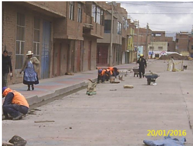
FOTOGRAFÍA N° 29. Colocado de concreto en cunetas Jr. Miguel Iglesias. Enero del 2016.
