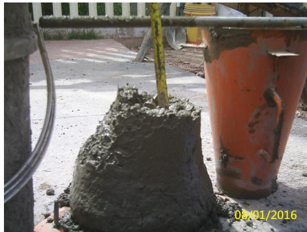
FOTOGRAFÍA N° 35. Haciendo la prueba del slump con el cono Abrams. Enero del 2016.
