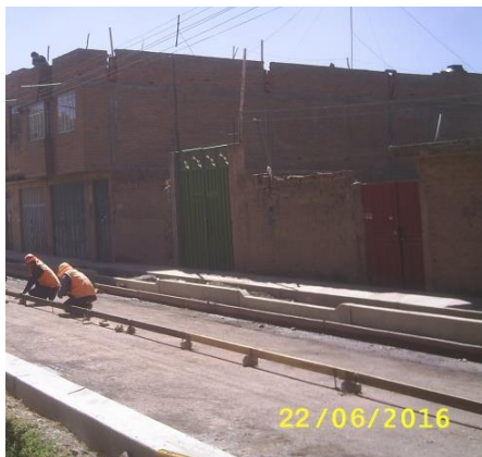
FOTOGRAFÍA N° 18. Encofrado para el colocado del concreto premezclado del Jr. Paraguay. Junio del 2016.
