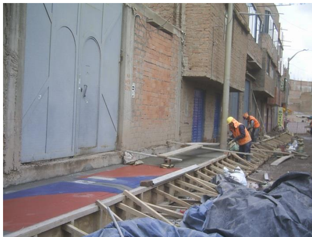
FOTOGRAFÍA N° 06. Colocado del concreto y acabado en veredas del Jr. La merced. Enero del 2016
