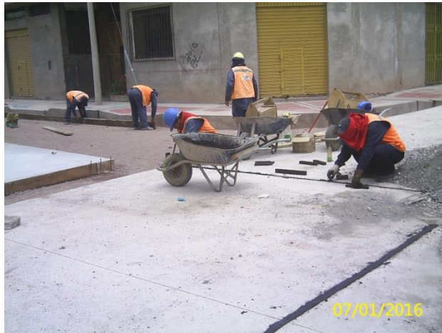
FOTOGRAFÍA N° 32. Encofrado de pavimento rígido en el Jr. Mayta Capac C-3. Enero del 2016.
