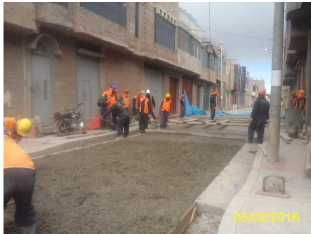
FOTOGRAFÍA N° 11. Colocado del concreto premezclado en el Jr. La merced. Febrero del 2016.
