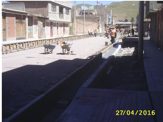
FOTOGRAFÍA N° 17. Colocado del concreto en cunetas Jr. Quito, ambos lados. Abril del 2016.
