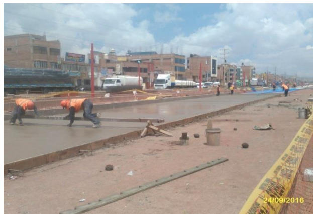
FOTOGRAFÍA N° 41. Colocación de antisol al pavimento rígido. Septiembre del 2016.
