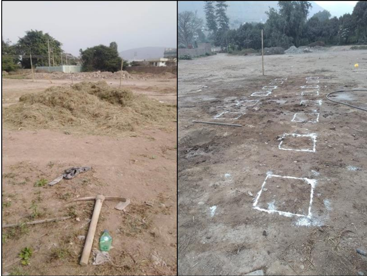
Figura 20: Construcción de sistema de cielo abierto
