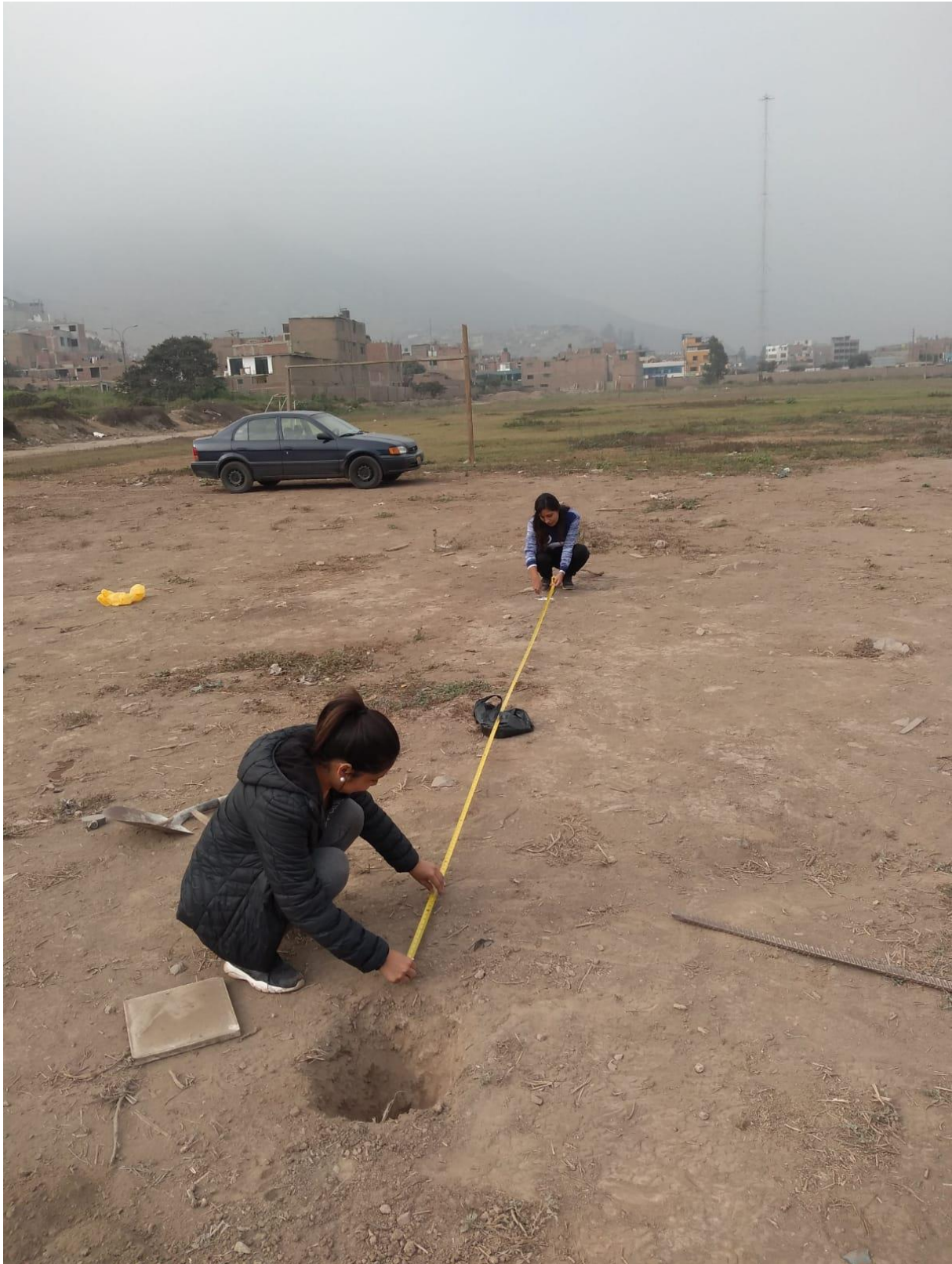
Preparación del para ejecutar el proyecto terreno
