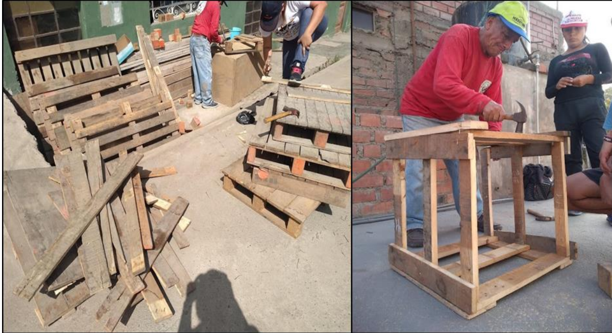
Figura 19: Construcción de sistema de ventilación forzada
