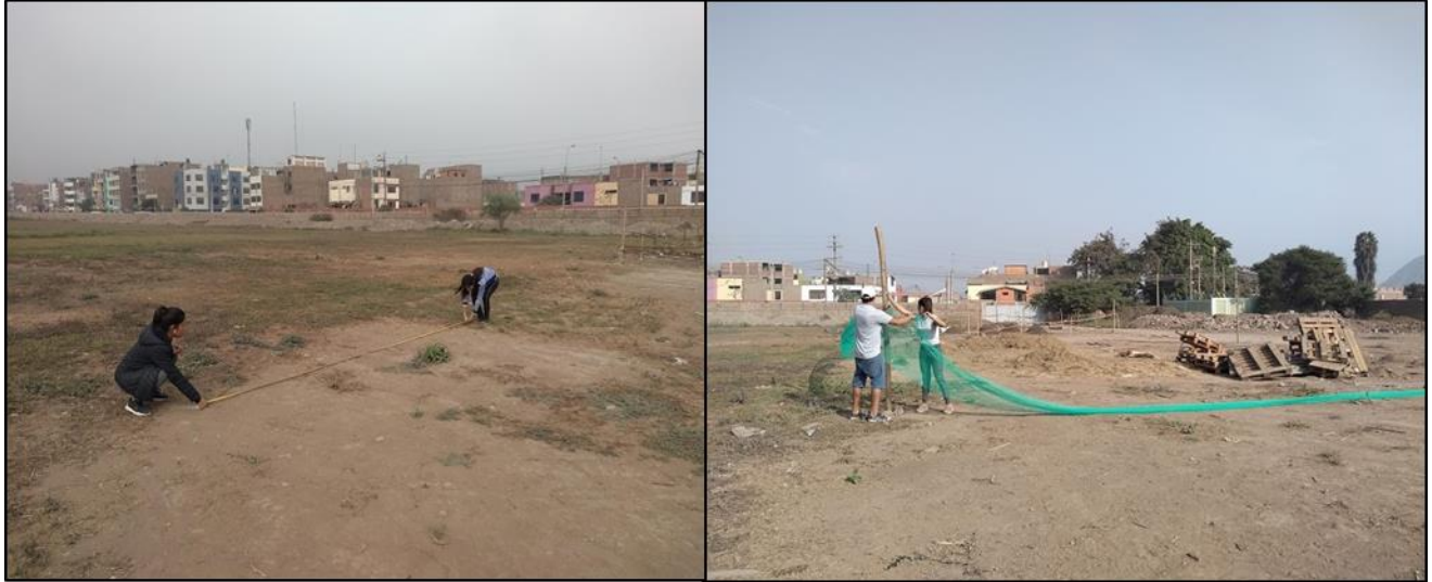
Figura 17: Preparación y cercado del terreno de la mansión de la UPeU
