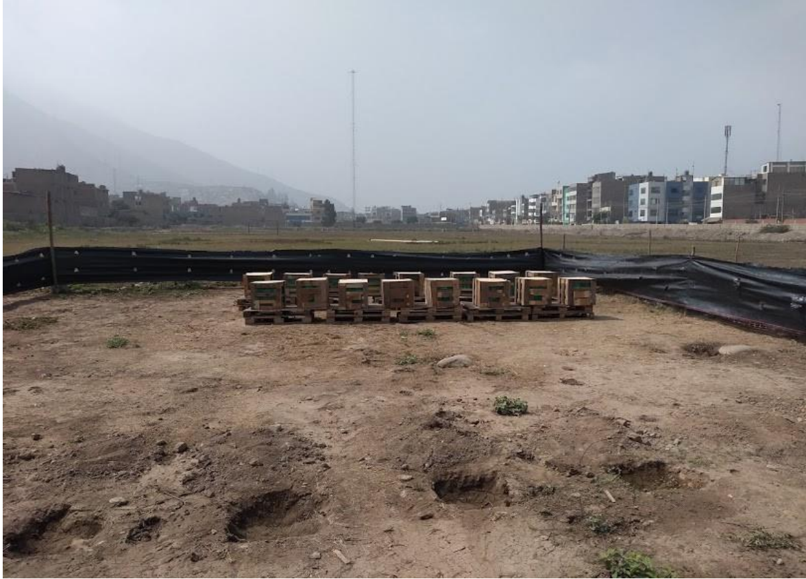
Figura 18: Instalación de estructura
