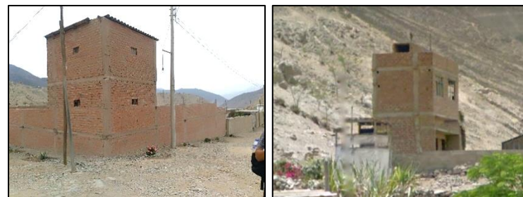
Figura 38: Fotografías, identificando alturas en la Quebrada el Retamal. Fuente: Archivo propio.
