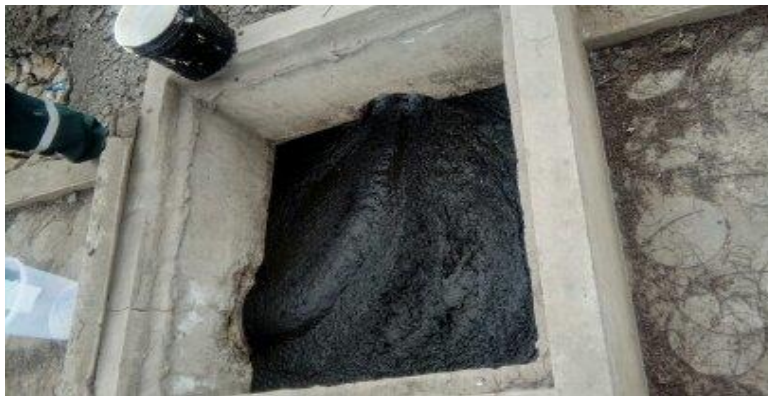
Figura 35. Descarte del lodo almacenado en la válvula del Reactor UASB
