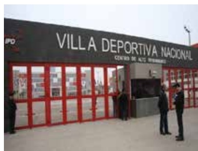
figura 253 Pintura de blanco, rojo y gris en las edificaciones fuente: José Bentin Arquitectos, 2019
