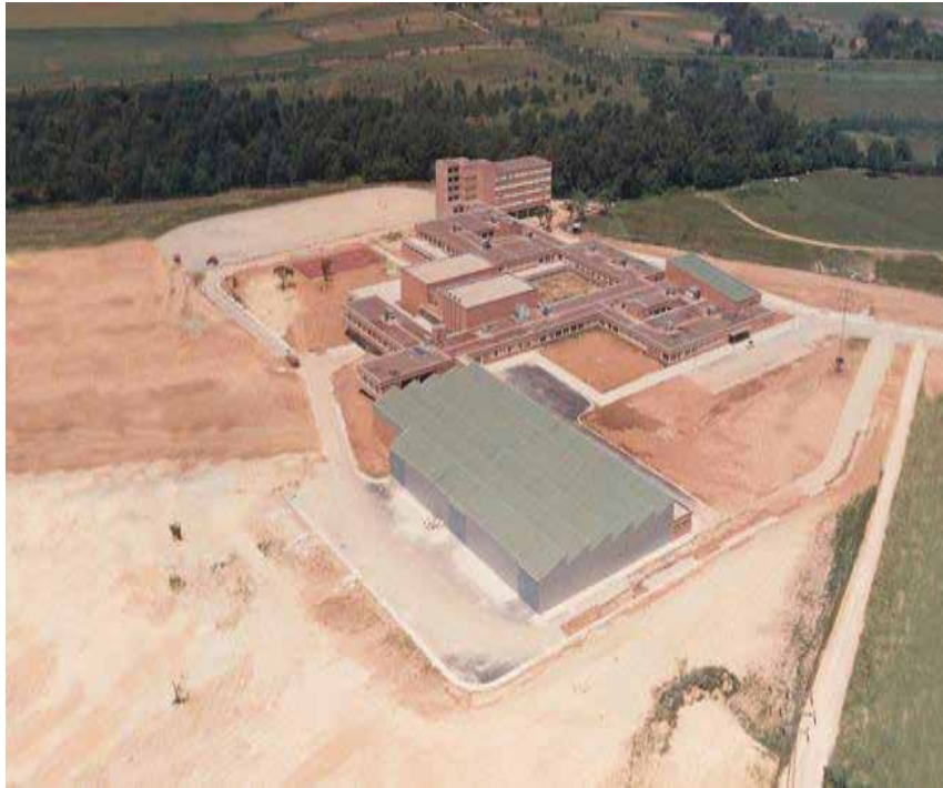
Figura 303 Vista panorámica de la construcción del CAR de Sant Cugat Fuente: La vanguardia, 2017
