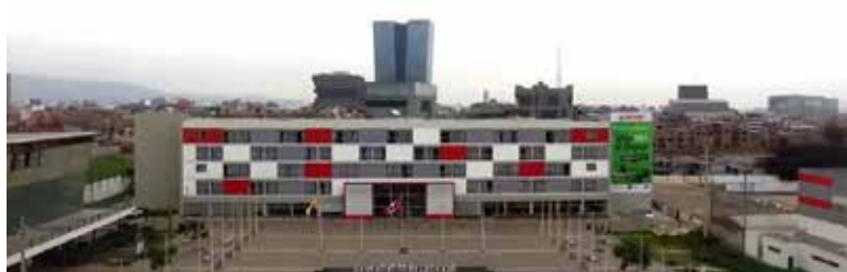
Figura 247 Acabados exterior en residencia, polideportivo 1 y clínica deportiva Fuente: ovación corporación deportiva, 2019
