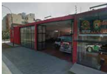
Estación de bomberos
