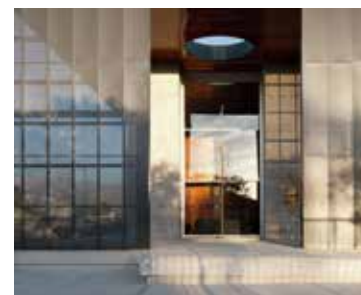
Figura 276 Muro cortina Fuente: Archdaily Perú, 2011
