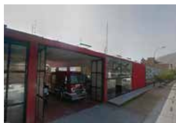
Estacion de Bombero
