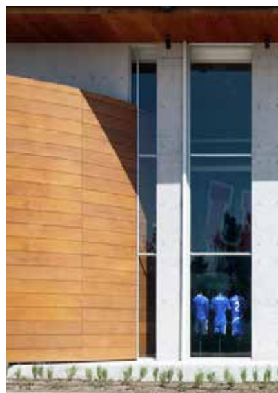
Figura 282 La madera y el concreto expuestos trabajos en exterior del complejo Fuente: Archdaily Perú, 2011
