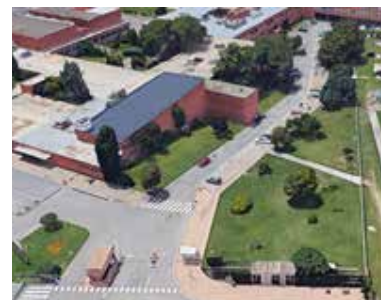
Figura 300 Vista del acceso principal del CAR Fuente: Google Earth, 2019
