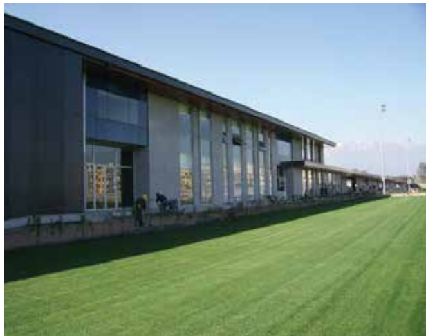
Figura 259 Edificio longitudinal de carácter deportivo Fuente: Pitágora, 2006
