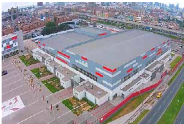
figura 235 Acceso a estacionamiento fuente: diaringenieros,2019
