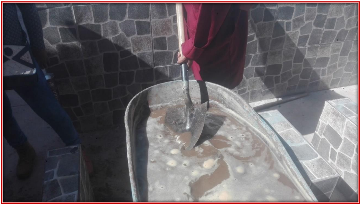
Fotografía N°08: Lavado de los Agregados
