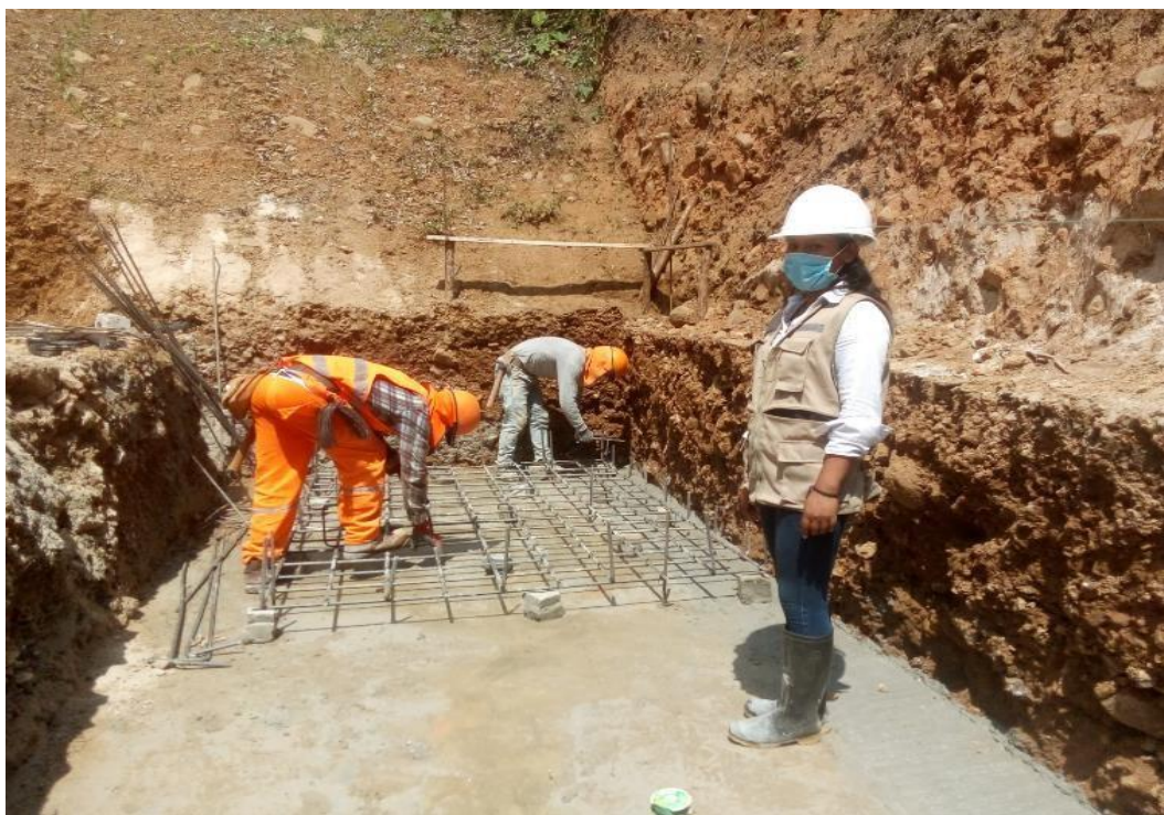
IMAGEN 04. Verificación de los trabajos con EPPs en el trabajo en habilitación de acero.
