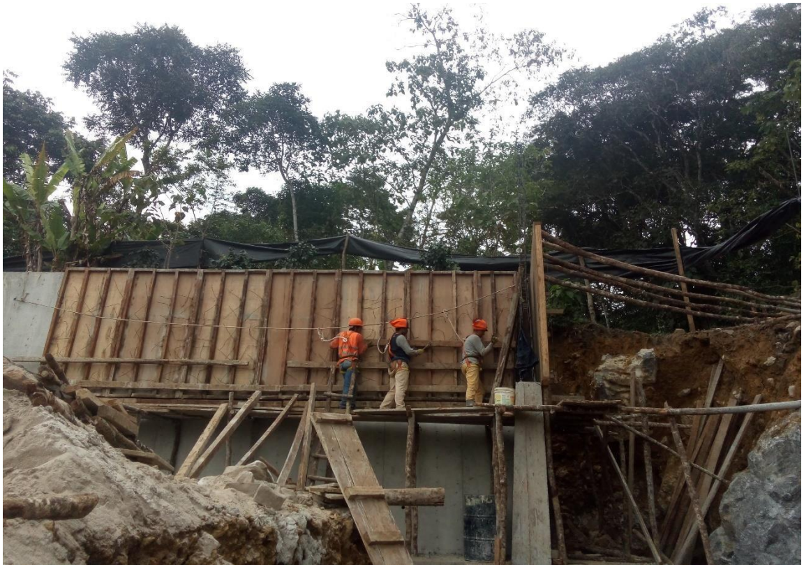
IMAGEN 07. Verificación de trabajos en altura.
