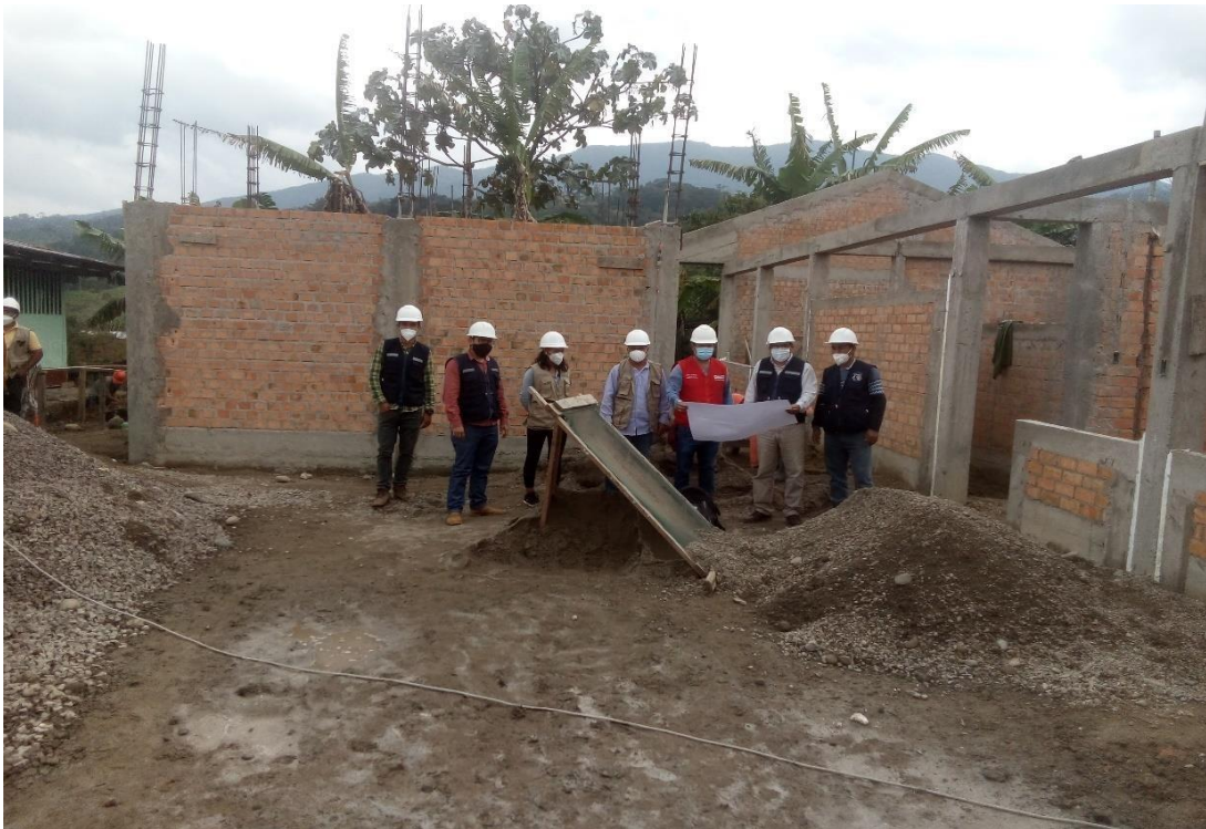
IMAGEN 06. Verificación de los trabajos con supervisión y PRONIED.
