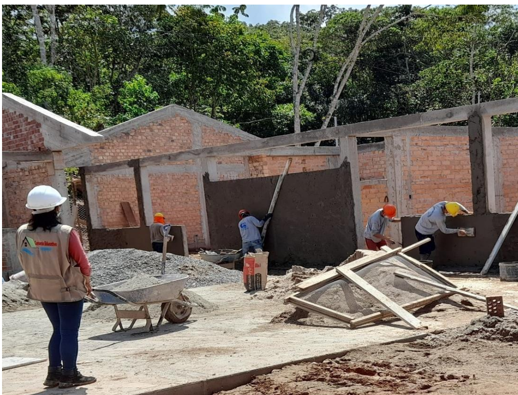
IMAGEN 03. Verificación de los trabajos con EPPs en el trabajo.
