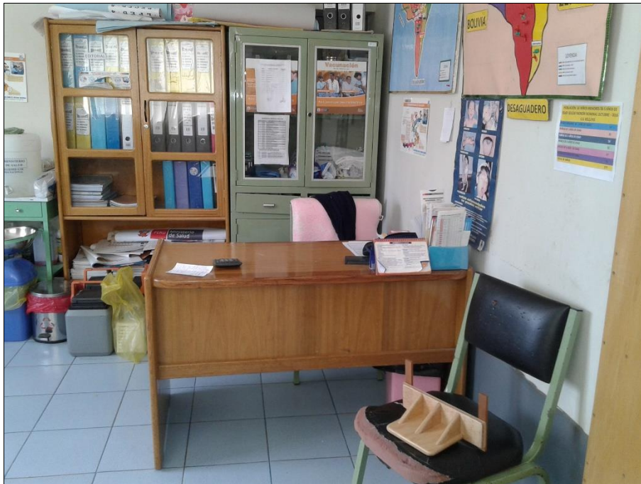
Figura 45. Estantes y armarios sin fijación - Enfermería. (Elaboración propia).
