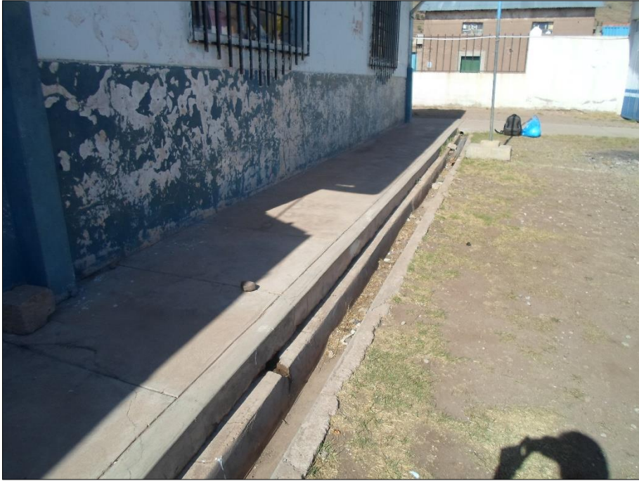
Figura 43. Canal revestido de concreto. (Elaboración propia).
