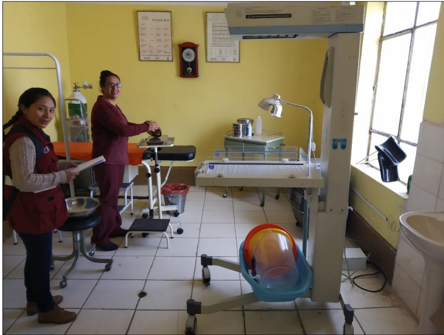
Figura 49. Equipos médicos sin medios de sujeción - Sala de parto. (Elaboración propia).
