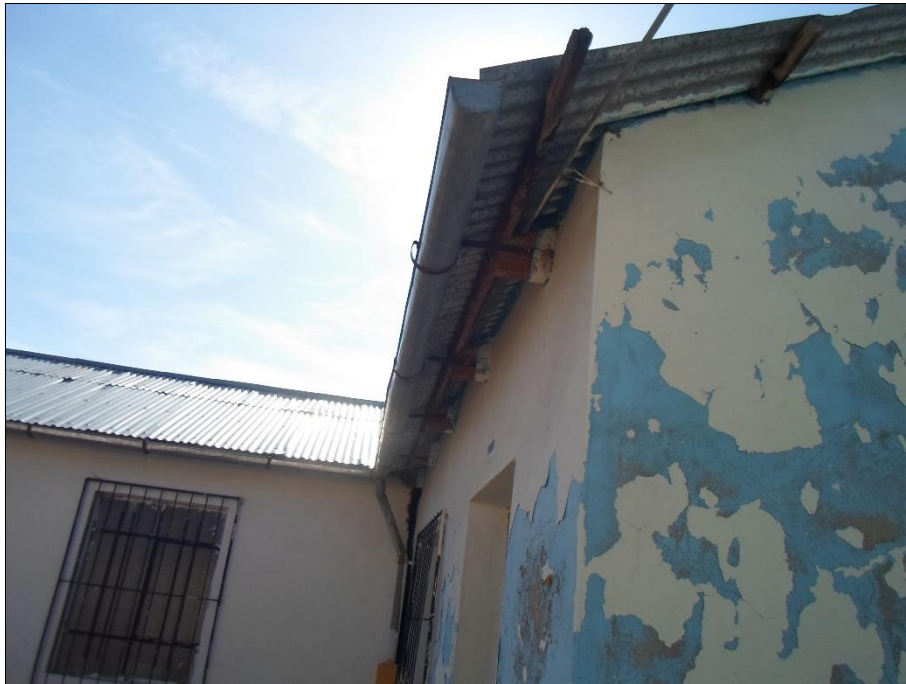
Figura 54. Cobertura de calamina. (Elaboración propia).
