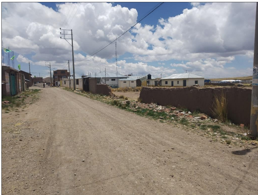
Figura 53. Muro perimetral inseguro. (Elaboración propia).
