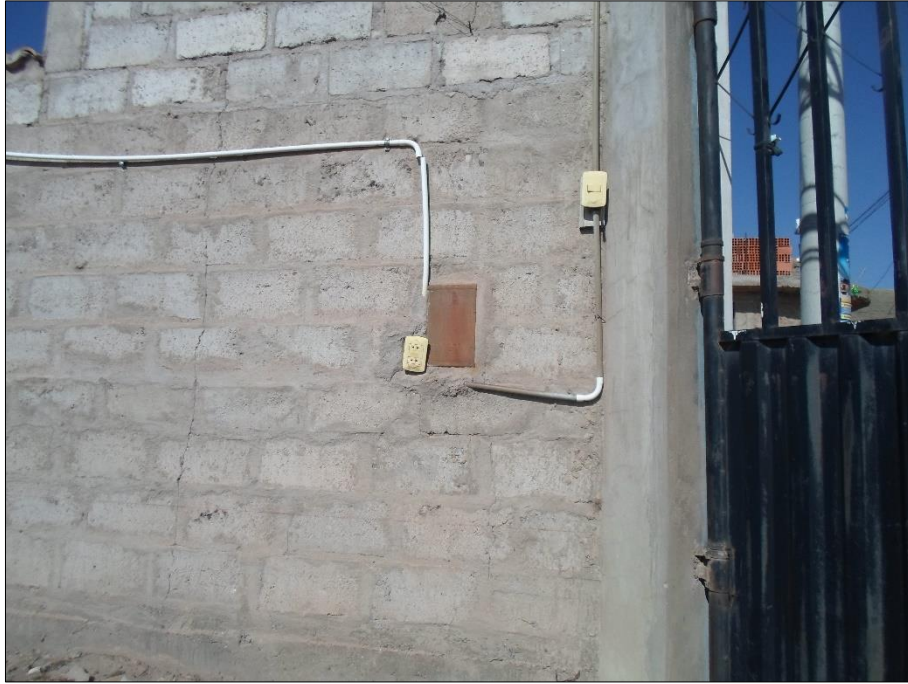
Figura 33. Tablero general. (Elaboración propia).
