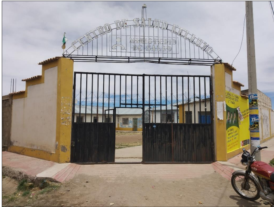
Figura 55. Entrada principal Centro de Salud Kelluyo. (Elaboración propia).
