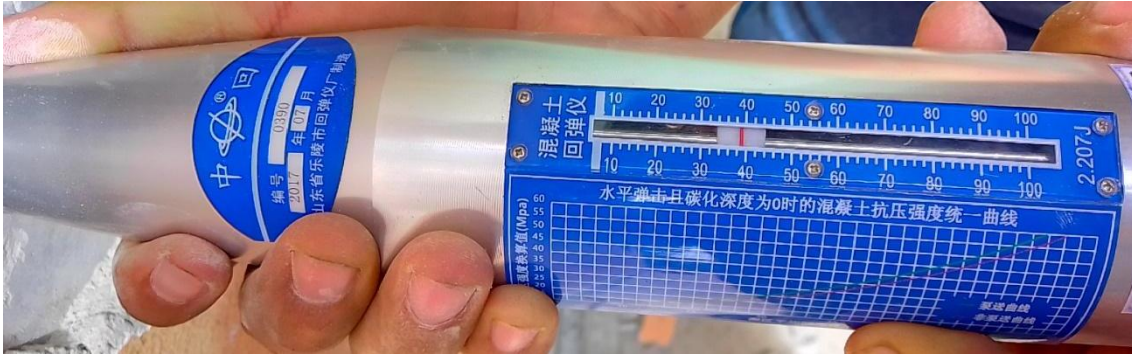
Figura 39. Cuarta medición efectuada dando una resistencia a la compresión de 38 MPa. Fuente: Elaboración Propia.
