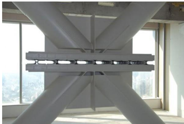
Figura 19. Colocación de disipador metálico. Fuente:(Nuzzo et al., 2018).
