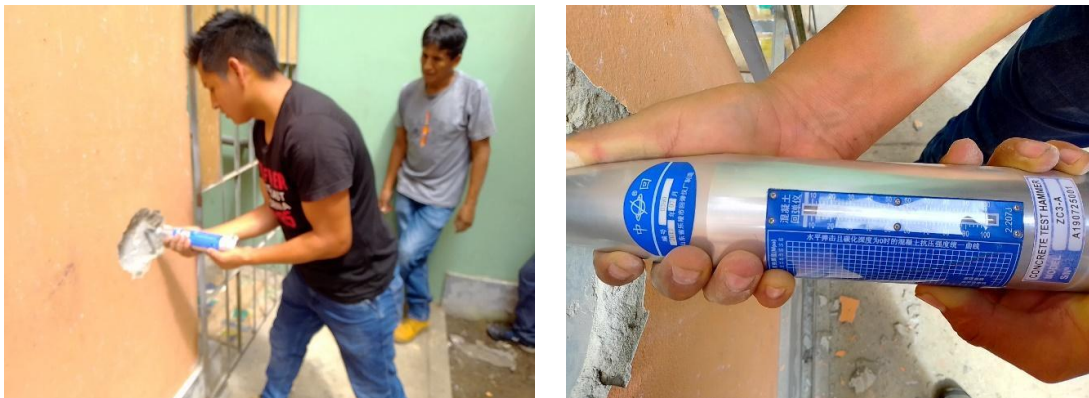
Figura 35. Auscultaciones y mediciones realizadas en elementos verticales. Fuente: Elaboración Propia.
