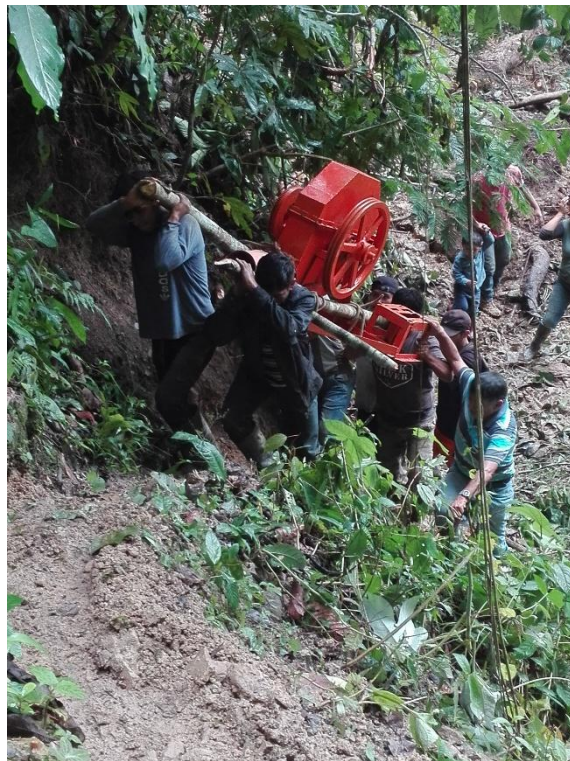
Figura 59. Transporte de los equipos electromecánicos
