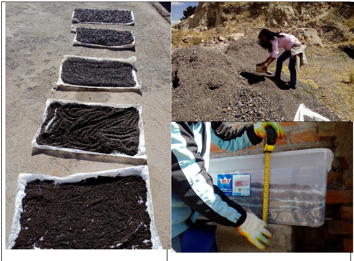
Figura 9. Cribado, lavado e instalación de filtro de arena para sistema de recirculación de agua gris construido.
