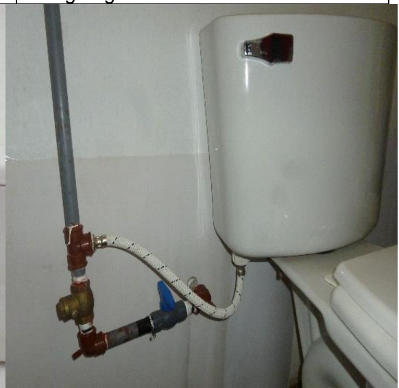
Instalación terminada de los componentes que abastecen al inodoro de agua gris y potable
