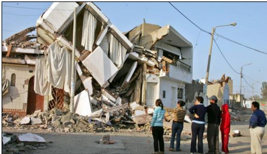
Figura 11: Desastres naturales (terremotos)
