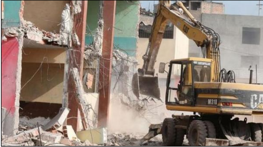
Figura 10: Demoliciones de colegios
