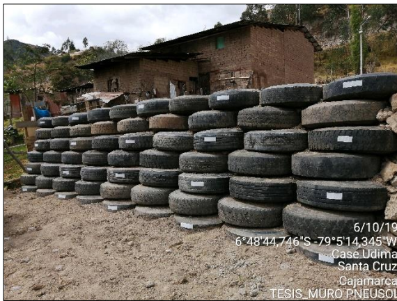
Foto 8. Instalación de los puntos de control
