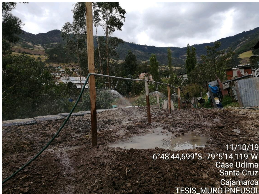
Figura 33. Saturación del Relleno durante 5 horas.
