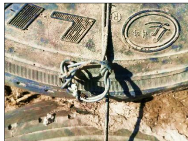
Figura 29. Amarre entre neumáticos con alambre galvanizado #12.
