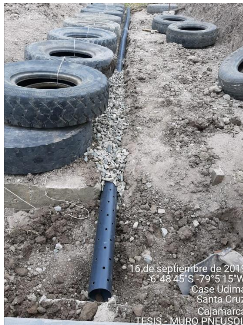
Foto 6. Instalación del drenaje
