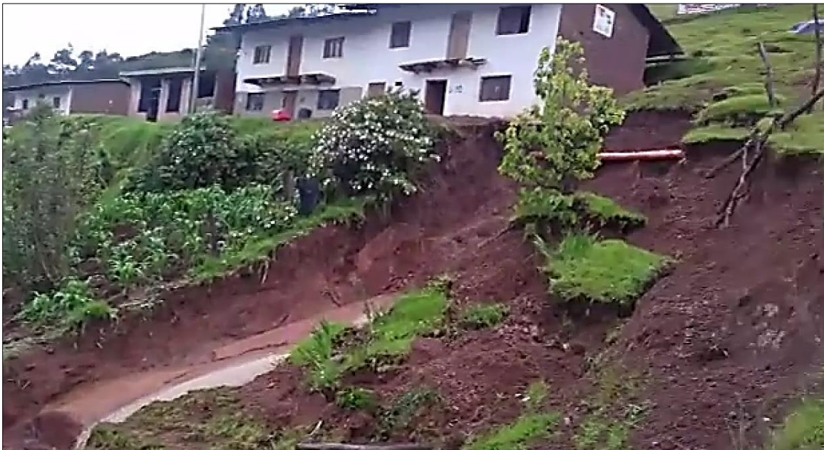
Foto 3. Ocurrencia de deslizamiento CP Udimá – Diciembre 2018
