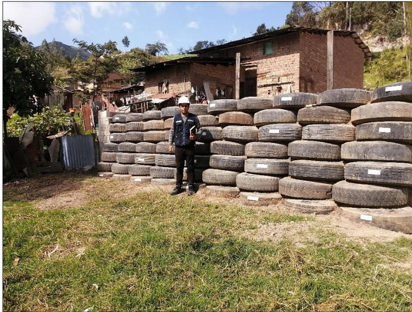
Foto 7. Muro Pneusol Tipo Lighweigt construido.
