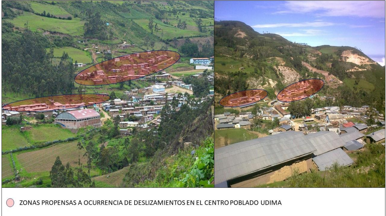
Figura 24. Zonas más propensas a ocurrencia de deslizamientos – CP Udima.
