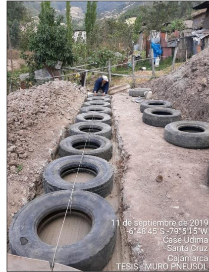
Foto 5. Colocación de la primera hilada
