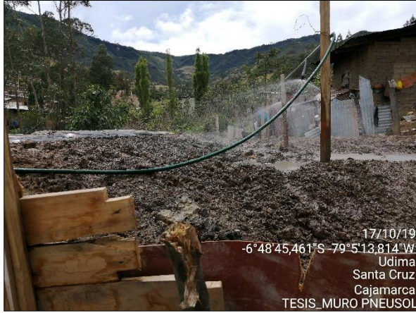
Foto 13. Saturación del relleno
