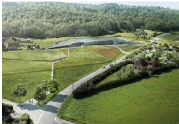
Figura 5.48: Vista General del Edificio. Fuente: Archdaily
