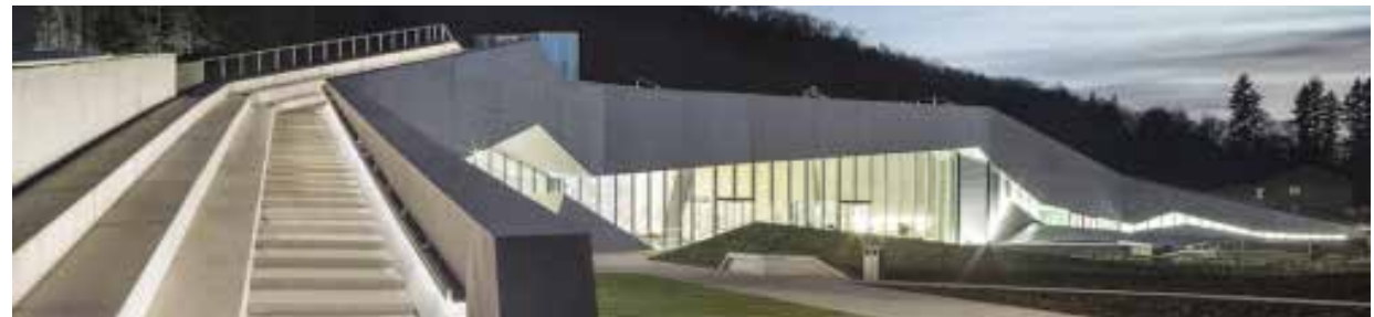
Figura 5.45: Rampas y Escalera que llevan al segundo nivel. Fuente: METALOCUS - Revista Internacional de Arquitectura, Artye Ciencia
