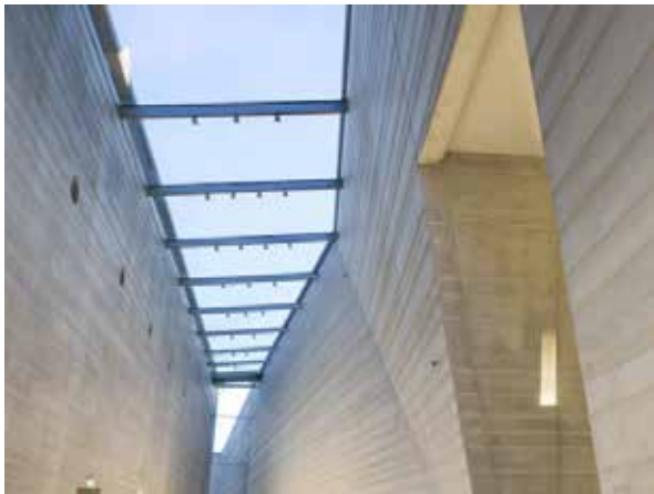
Figura 5.54: Aberturas en el Techo Fuente: Archdaily
