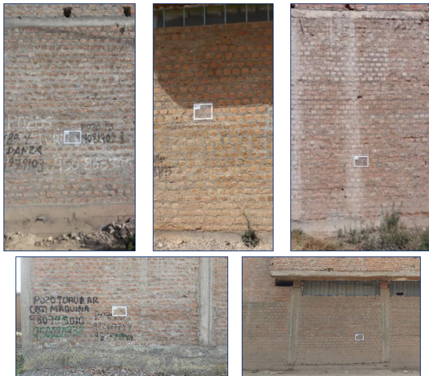
Figura 51. Formas de confinamiento de muros en las viviendas evaluadas.
