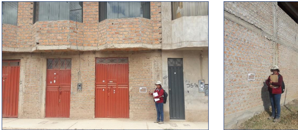
Fotografía 1. Evaluación de viviendas en el Distrito de San Miguel.
