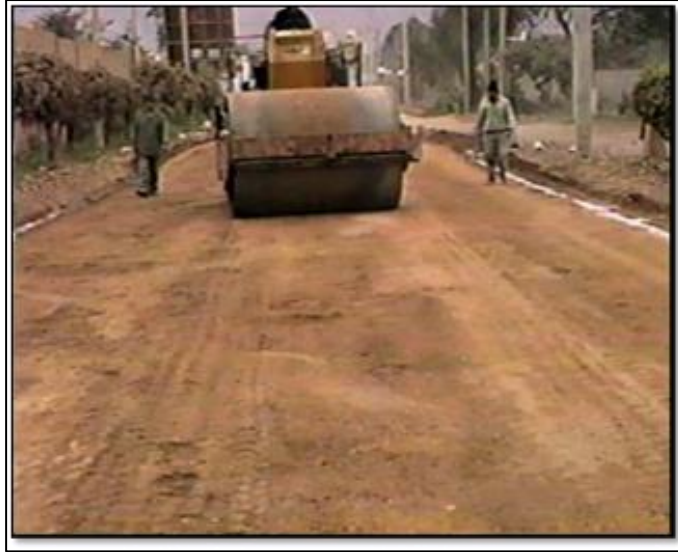
Figura III-3. Compactación de la superficie de rodadura estabilizada
