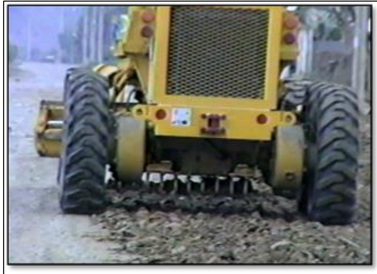
Figura III-1. Escarificado del suelo a ser tratado
