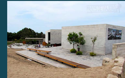
Vista Exterior hacia la cafetería:
