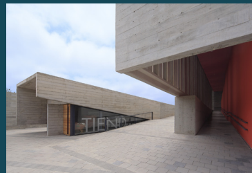
Vista Exterior de la Tienda:
