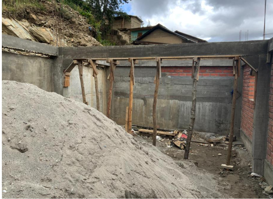
Figura 27: Construcción de vigetas en Carhuapata
