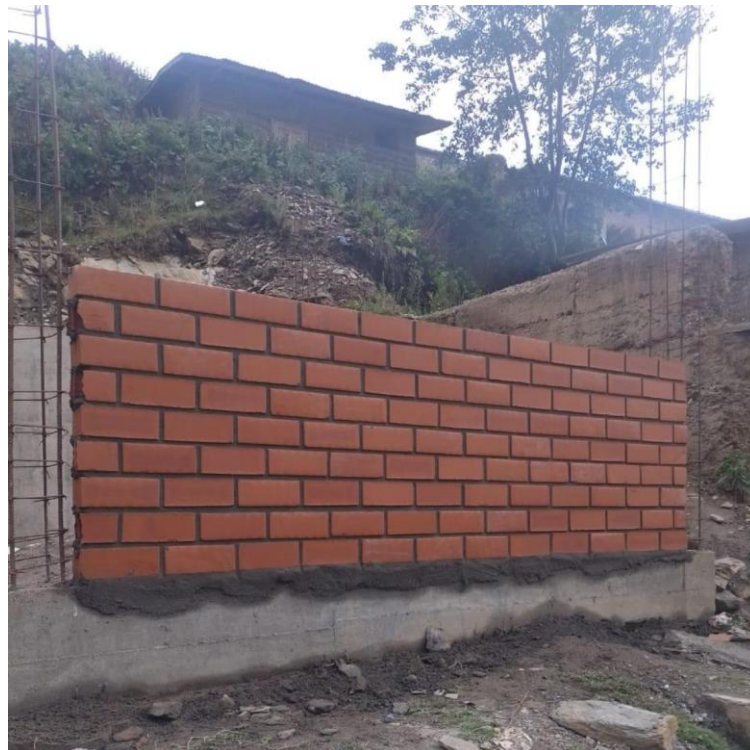
Figura 24 Levantamiento de muros en Carhuapata
