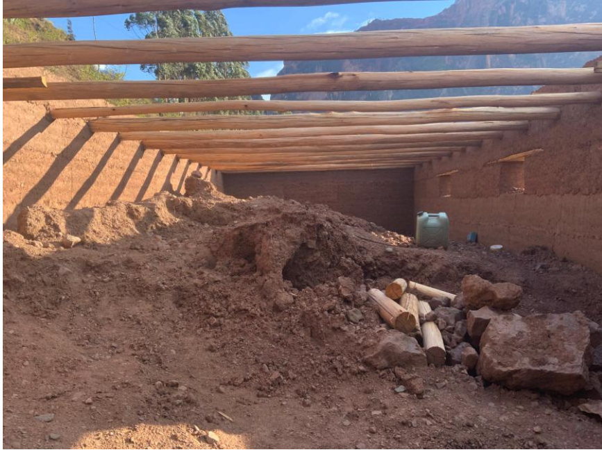
Figura 35 Formación de vigetas de mandera con los muros de Adobe en León Pampa
