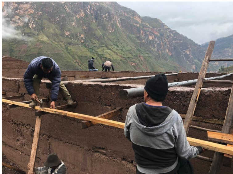
Figura 34 Formación de vigetas de mandera con los muros de Adobe en León Pampa
