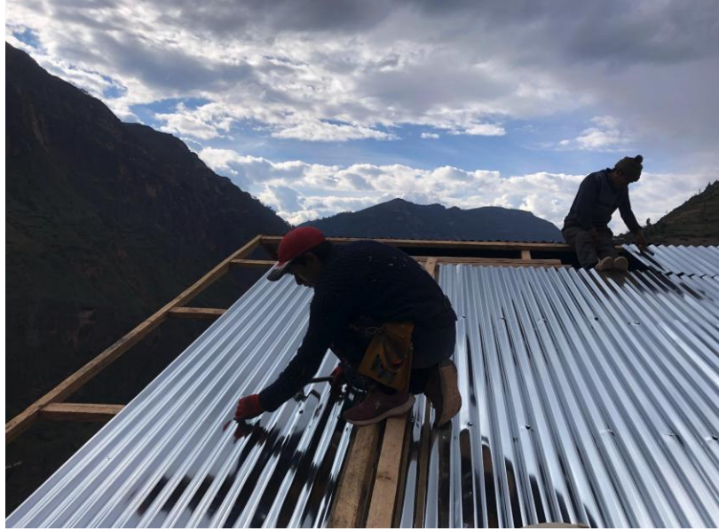
Figura 41 Armado de techo con madera con calaminas en León Pampa
