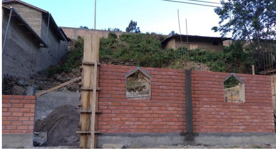
Figura 25 Levantamiento de muros y ventanas en Carhuapata
