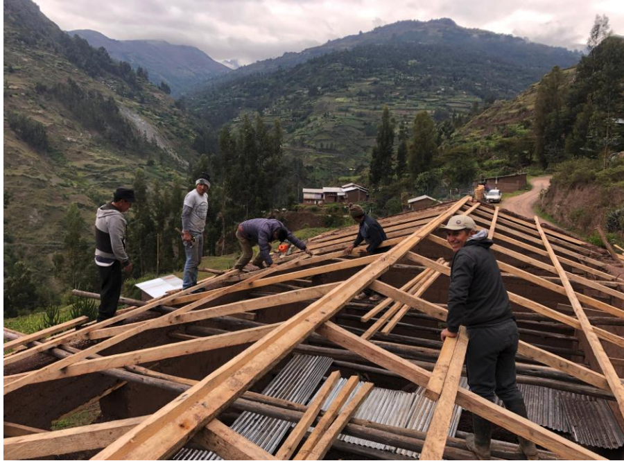
Figura 39 Armado de techo con madera en León Pampa
