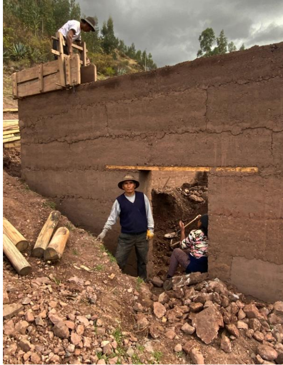
Figura 33 Formación de muros de Adobe en León Pampa
