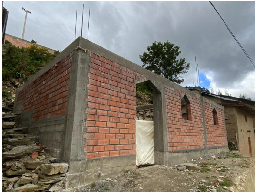
Figura 26 Levantamiento de muros en Carhuapata
