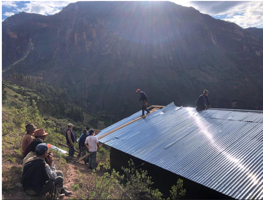
Figura 42 Armado de techo con madera con calaminas en León Pampa
