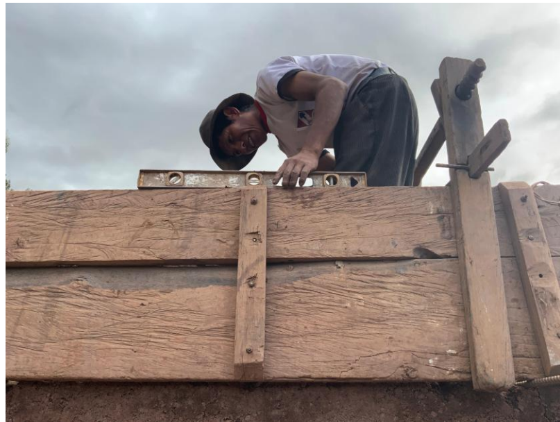
Figura 32 Formación de muros de Adobe en León Pampa
