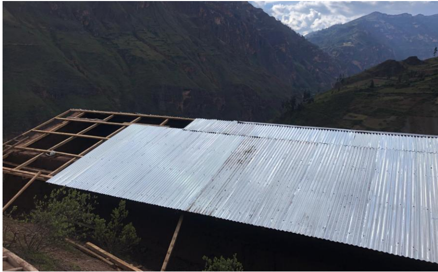
Figura 40 Armado de techo con madera con calaminas en León Pampa
