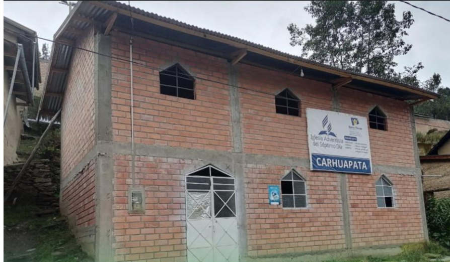
Figura 29 Templo terminado Carhuapata
