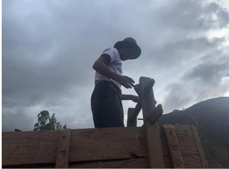
Figura 31 Formación de muros de Adobe en León Pampa
