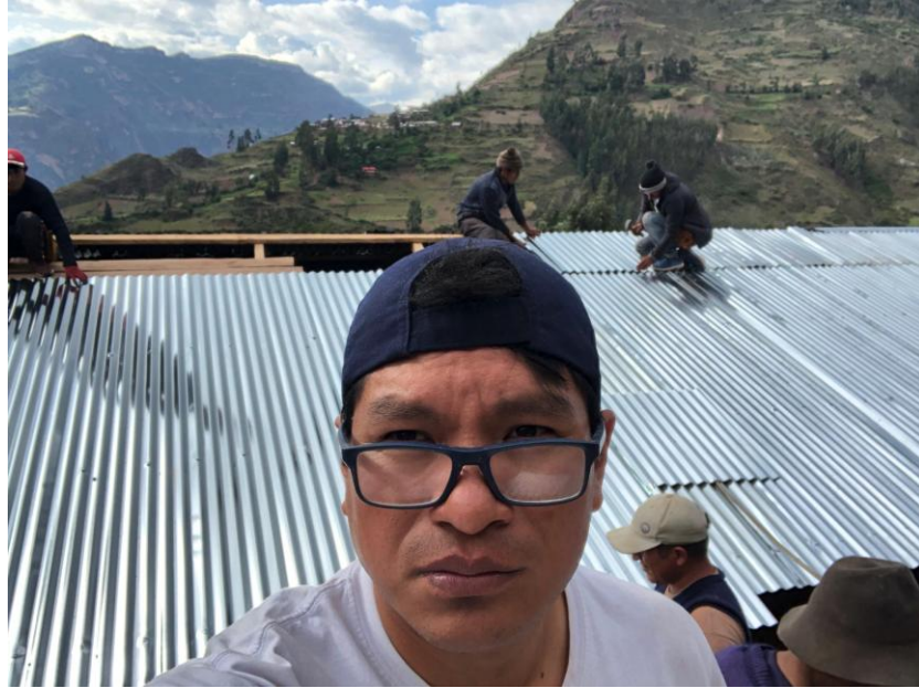
Figura 43 Armado de techo con madera con calaminas en León Pampa
