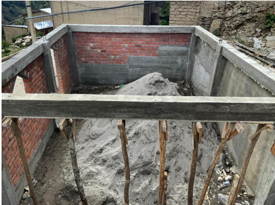
Figura 27: Construcción de vigetas en Carhuapata
