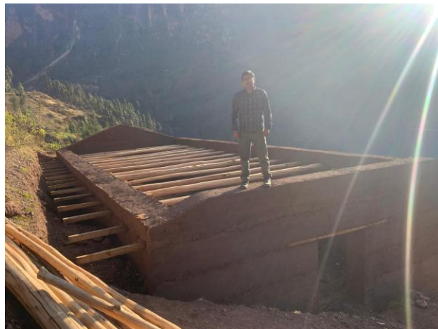
Figura 38 Vigetas de madera en León Pampa
