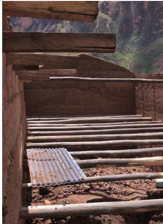
Figura 35 Formación de vigetas de mandera con los muros de Adobe en León Pampa
