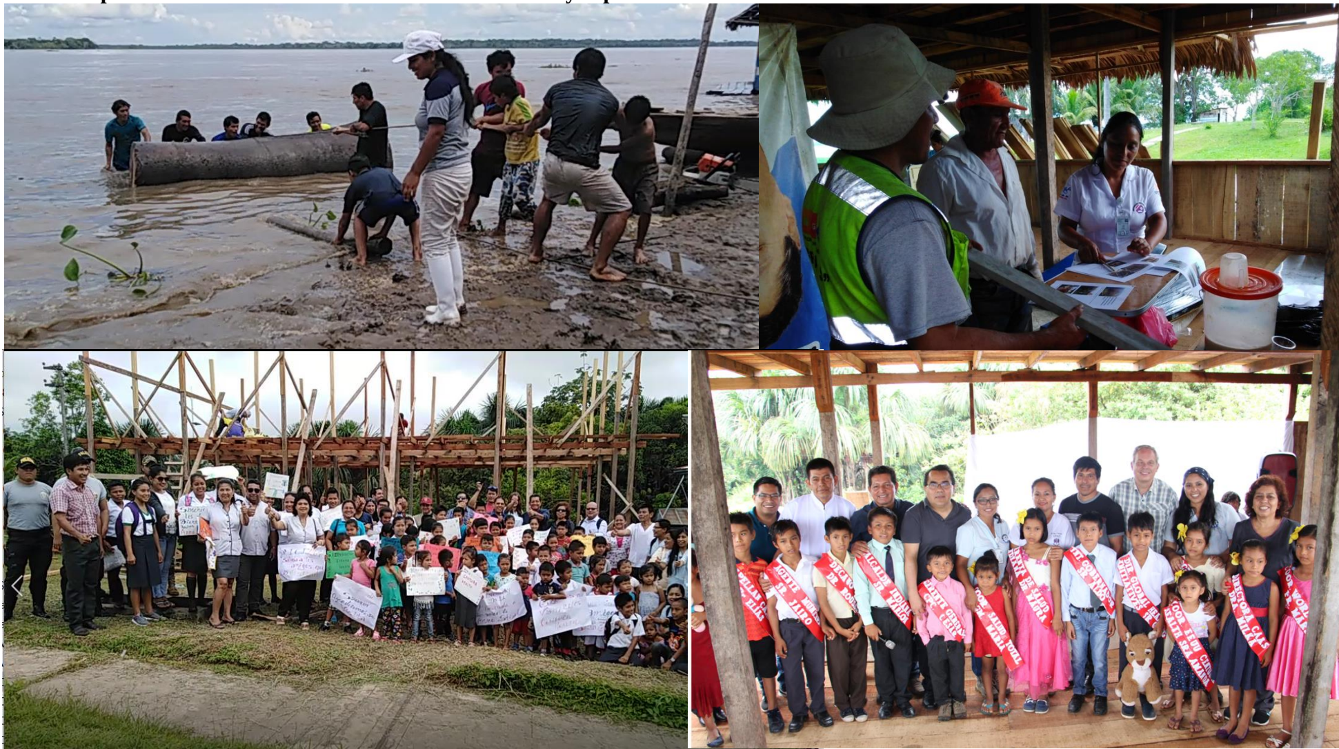
Fotos del proceso de construcción del Centro de Influencia y capacitación
