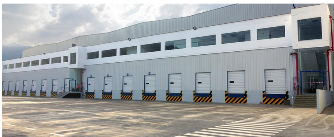
Figura 14: Almacenes industriales (Fuente: Web almacenes central huachipa sac)
