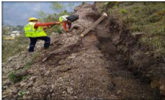
Figura N°12: Colocado de la cama de relleno.
