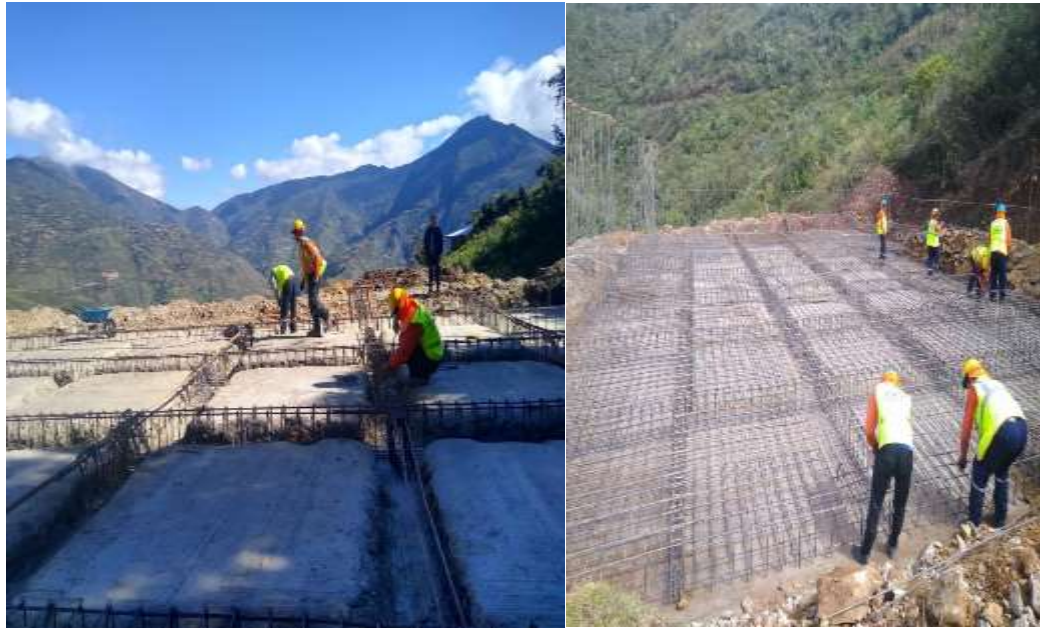
Figura N°43: Armado de malla de la losa del reservorio.
