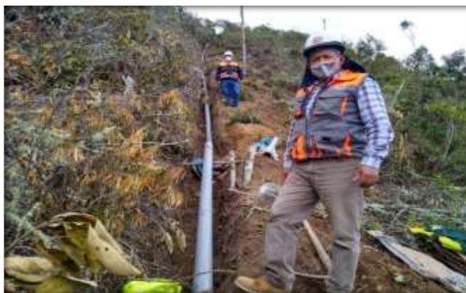
Figura N°13: Instalación de tuberías.
