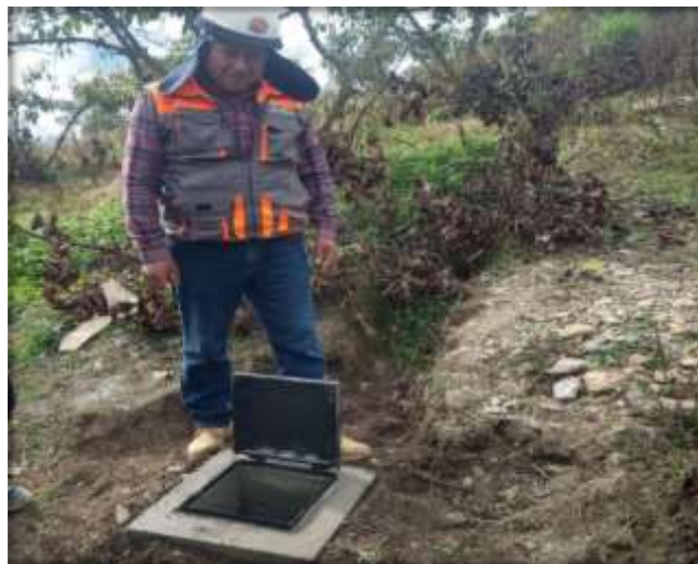
Figura N°34:Caja hidrante.
