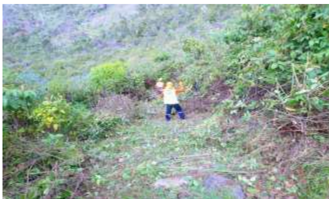
Figura N°21:Limpieza manual del área de trabajo.
