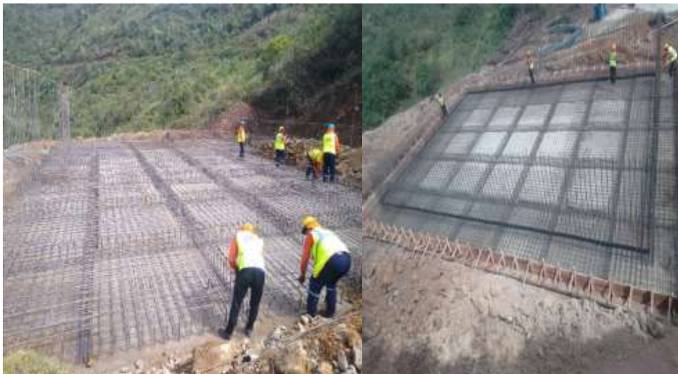
Figura N°14: Armado de malla de la loza del reservorio San Juan de Miraflores I y II.
