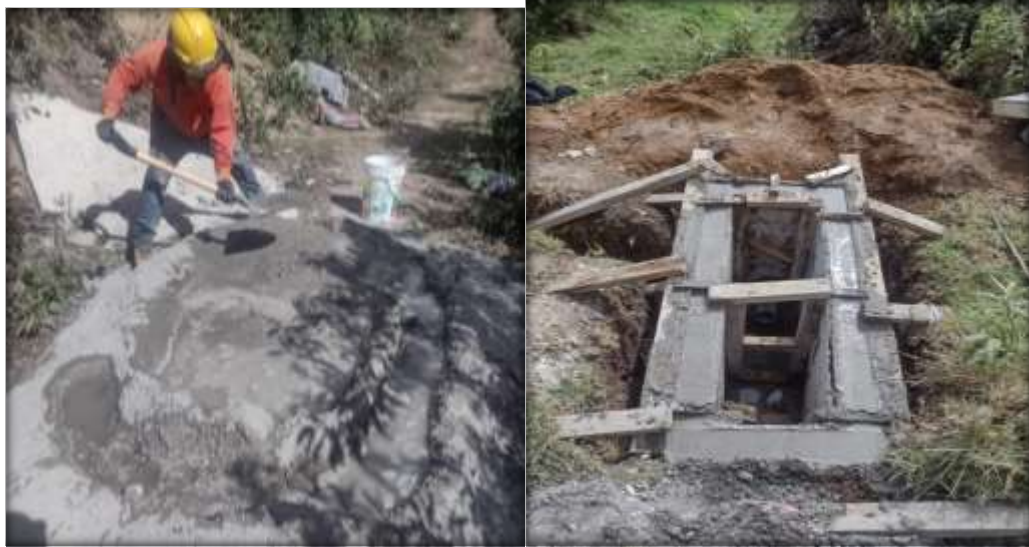
Figura N°31: Vaciado de concreto de la caja de válvula reductora de presión
