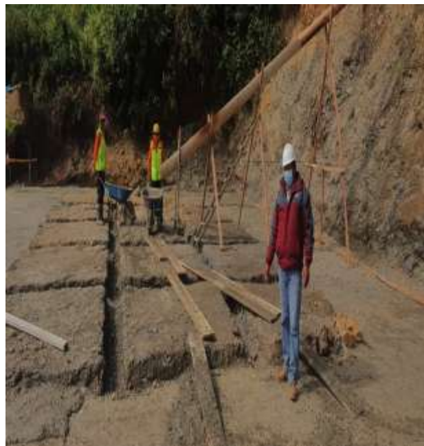
Figura N°42: Vaciado del solado F_c=140\text{kg/cm}^2
