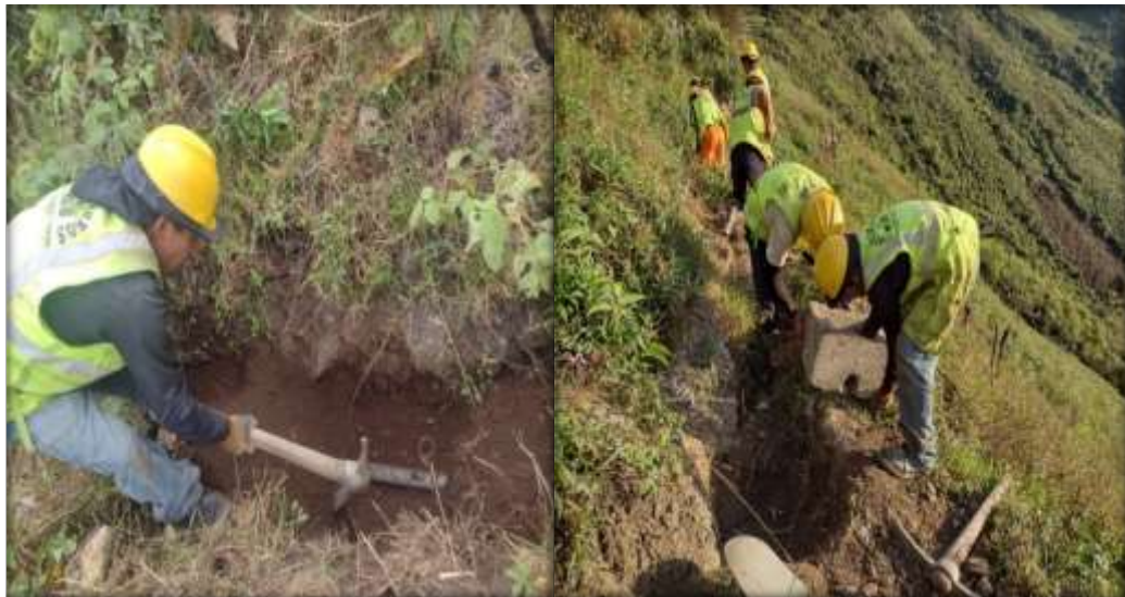
Figura N°33:Excavación y colocación de la caja hidrante.
