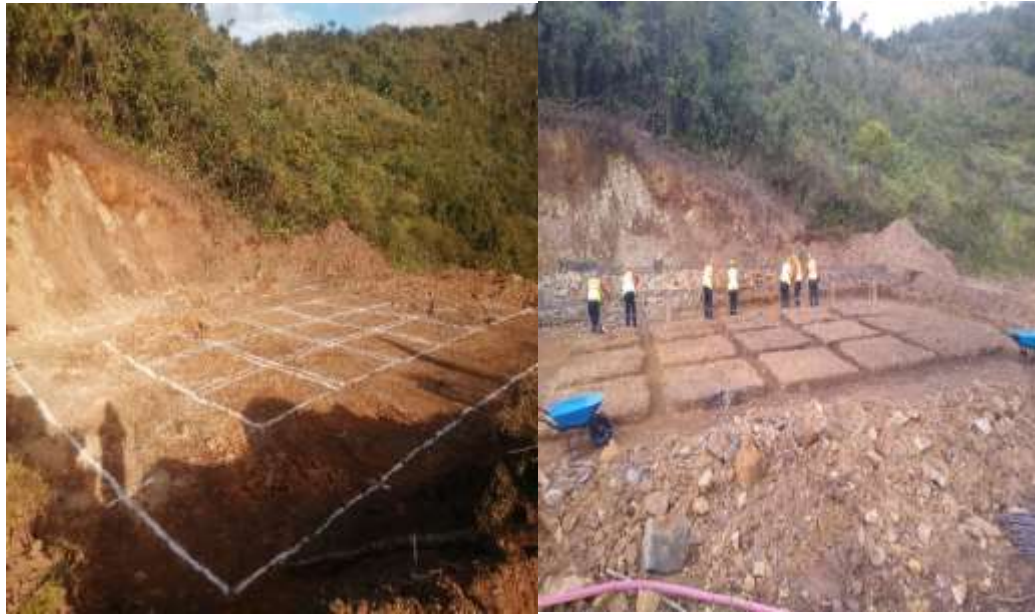
Figura N°41: Trazo, excavación y perfilado.
