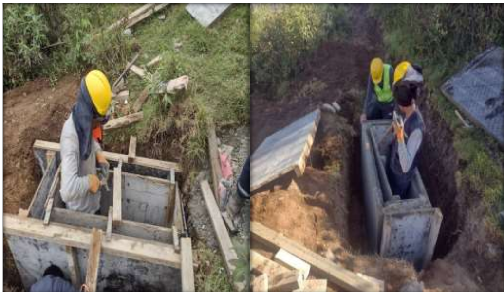
Figura N°30: Encofrado y desencofrado de la caja de válvula reductora de presión.
