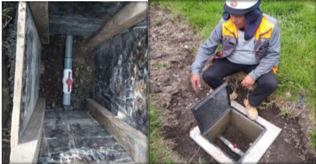
Figura N°36: Caja de Purga.
