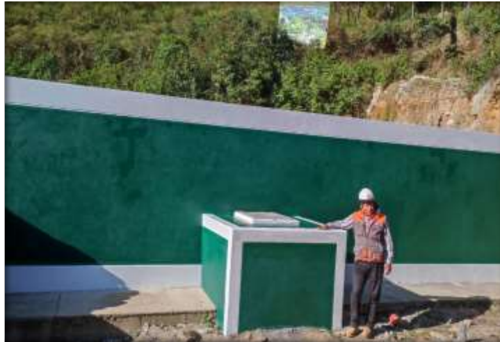
Figura N° 47: Pintado del reservorio.
