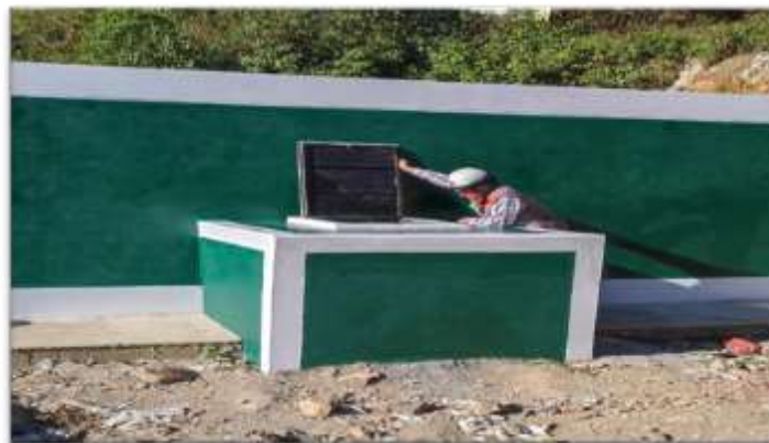
Figura N°18: Pintado del reservorio de Palmapampa.
