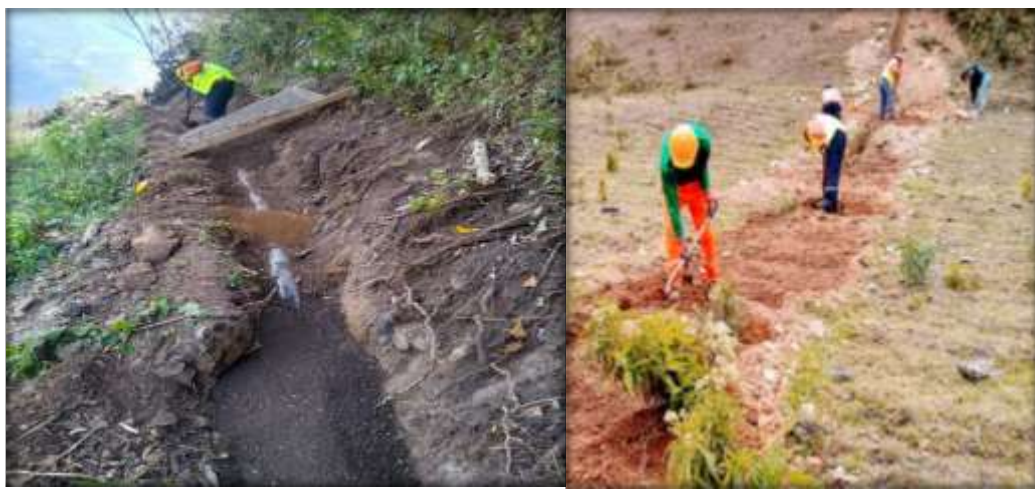
Figura N°26: Relleno del material con material propio.
