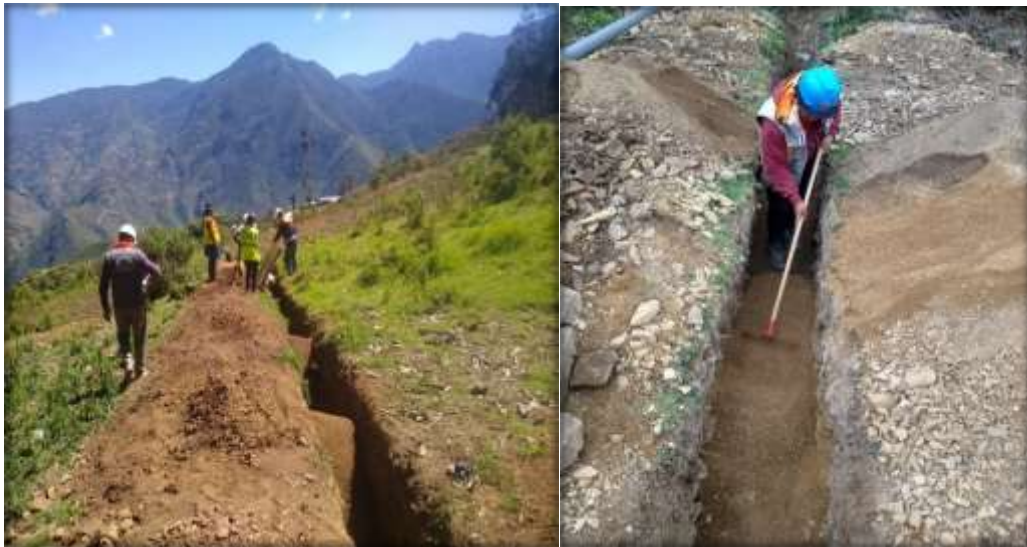
Figura N°24: Colocación de la cama de apoyo.
