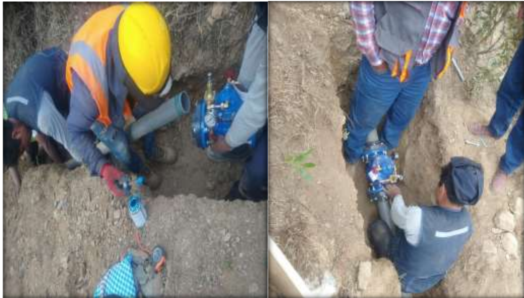
Figura N°29: Instalación de la válvula reductoras.
