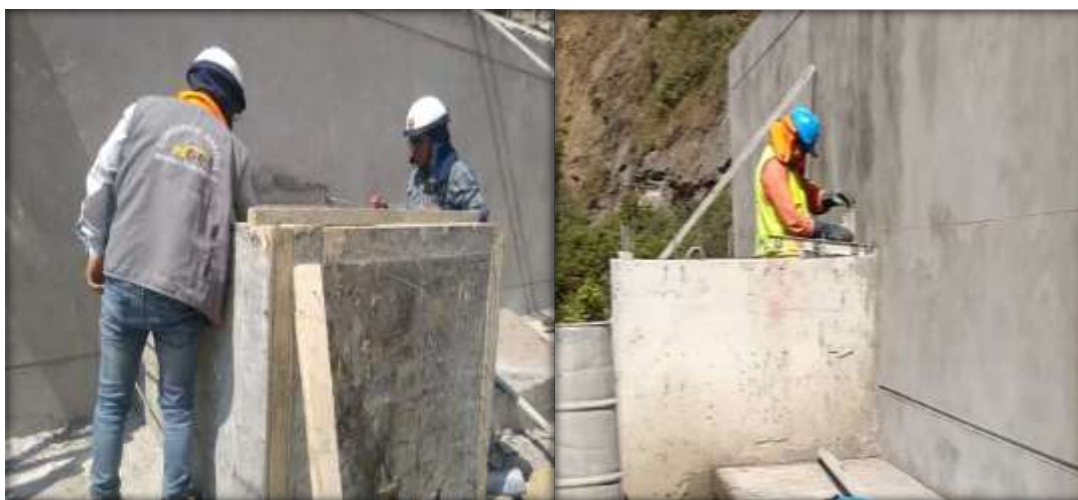
Figura N°48: encofrado y desencofrado de la caseta del reservorio.
