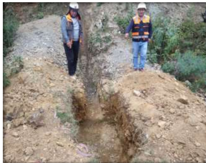
Figura N°28: Excavación de caja de válvula reductora.
