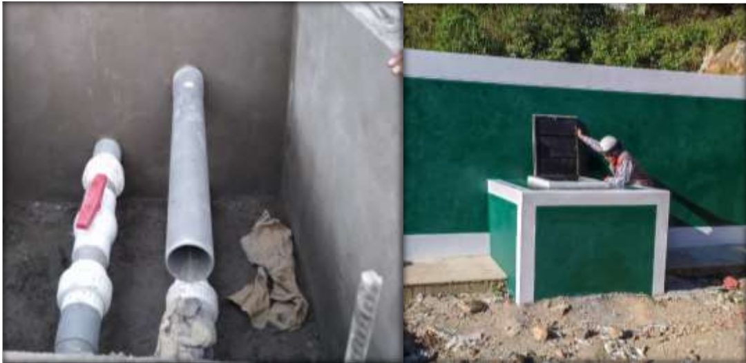
Figura N°49: Instalación de accesorio para la caseta del reservorio y pintado.
