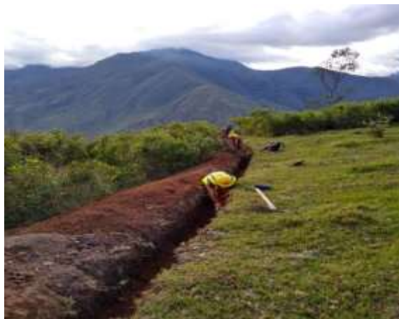
Figura N°11: Excavación de la zanja en sección rectangular.
