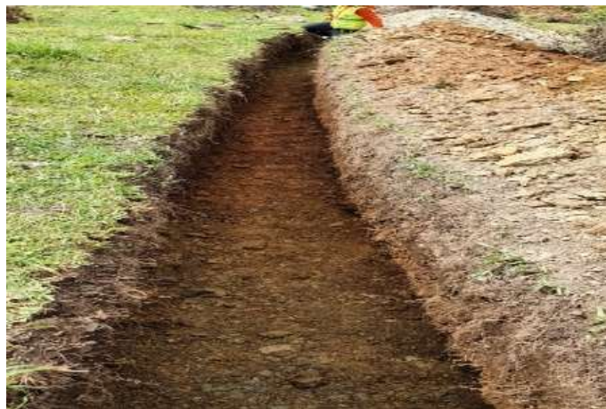
Figura N°07:Excavación de zanja para la línea de conducción.
