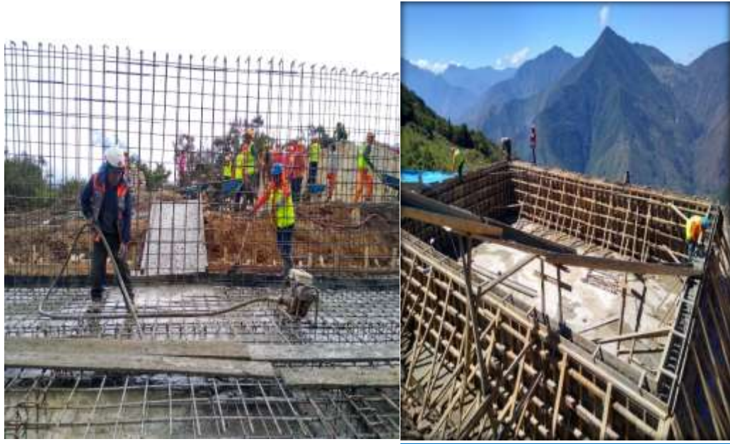
Figura N°45: Vaciado de la losa y muro del reservorio.
