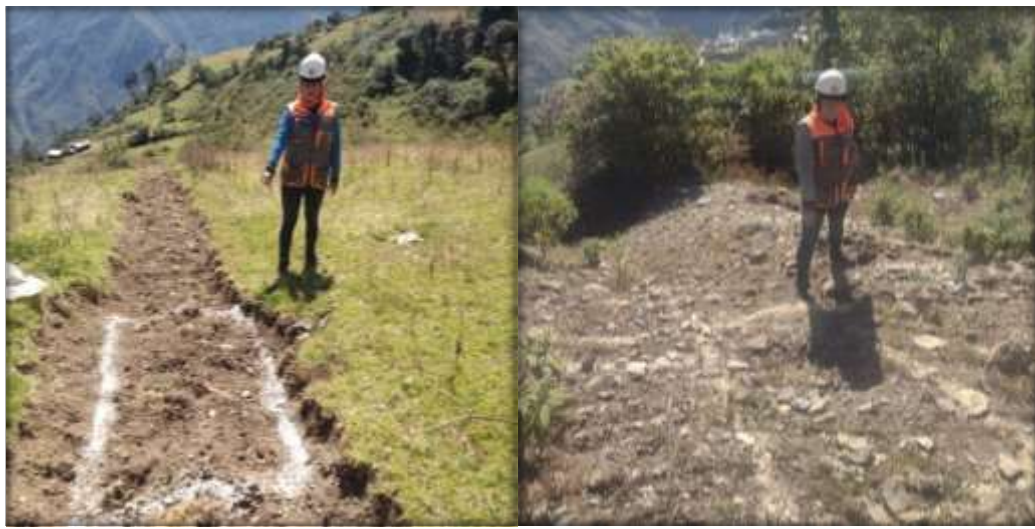
Figura N°27: Limpieza y Trazo de caja de válvula reductora.
