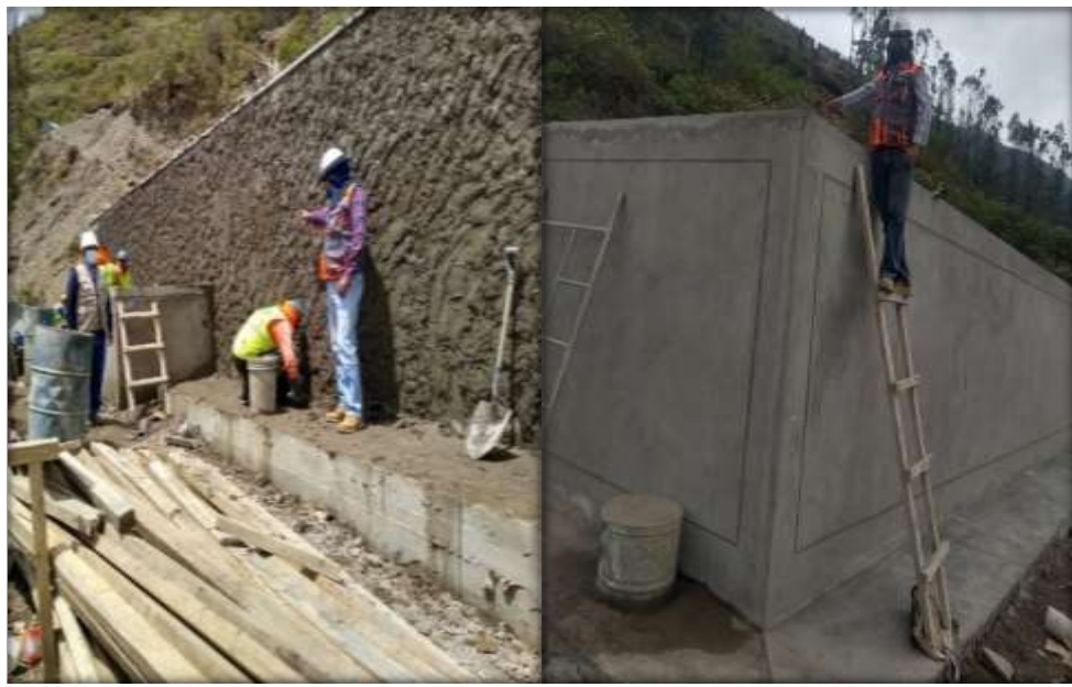
Figura N°46: Tarrajeo exterior del reservorio
