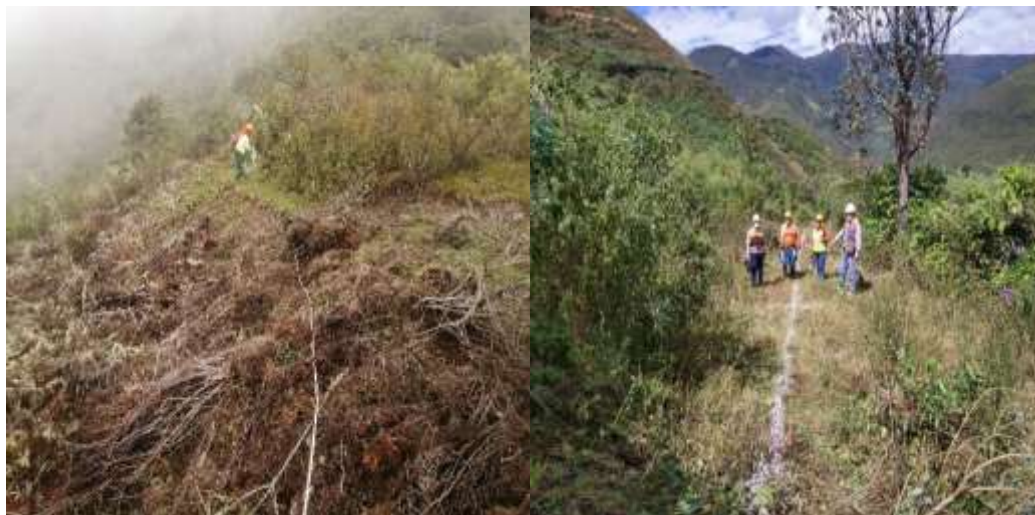
Figura N°22: Trazo para la excavación de línea de conducción y laterales.
