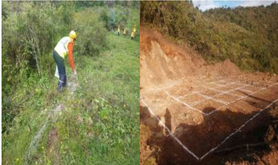
Figura N°10: Trazos para la excavación de zanja y Excavación de Reservorio.
