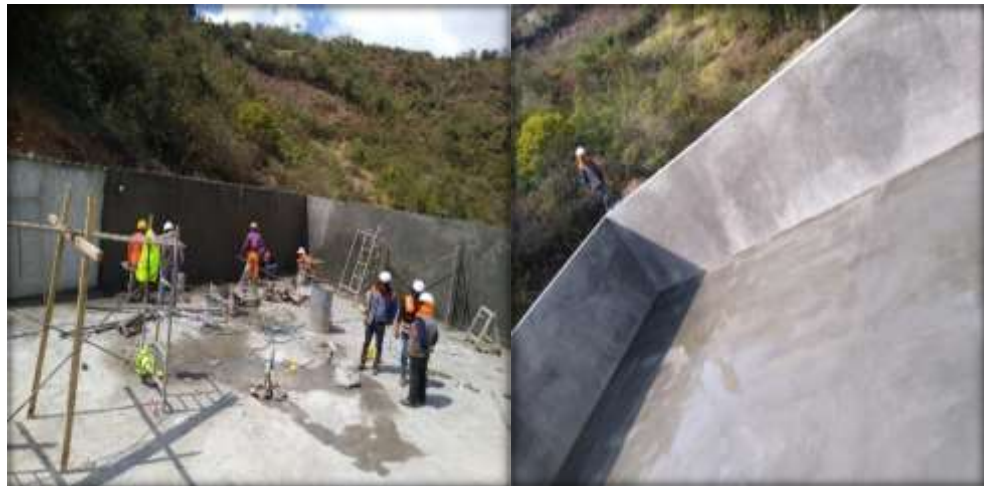
Figura N°17: Tarrajeo de Muro del reservorio Vento Pata – Tintay.
