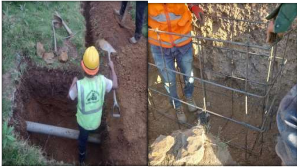
Figura 38: Excavación y armado de acero
