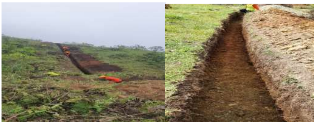
Figura N°23: Excavación de zanjas y perfilado.
