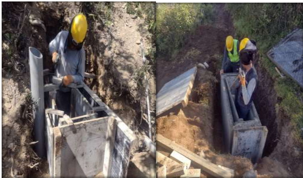
Figura N°39: Encofrado y desencofrado de la caja de rompe presión.
