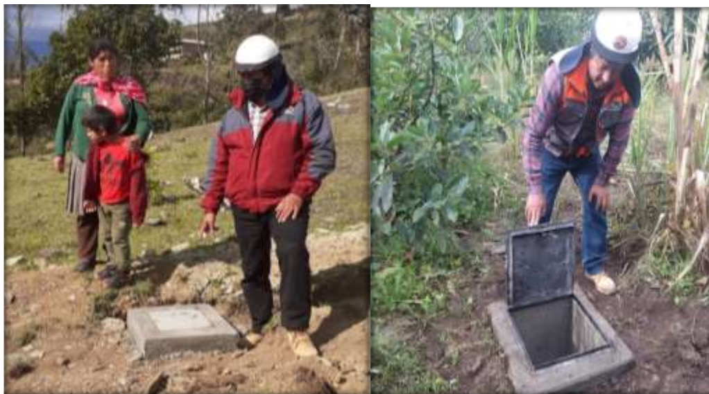
Figura N°35: Caja de aire.
