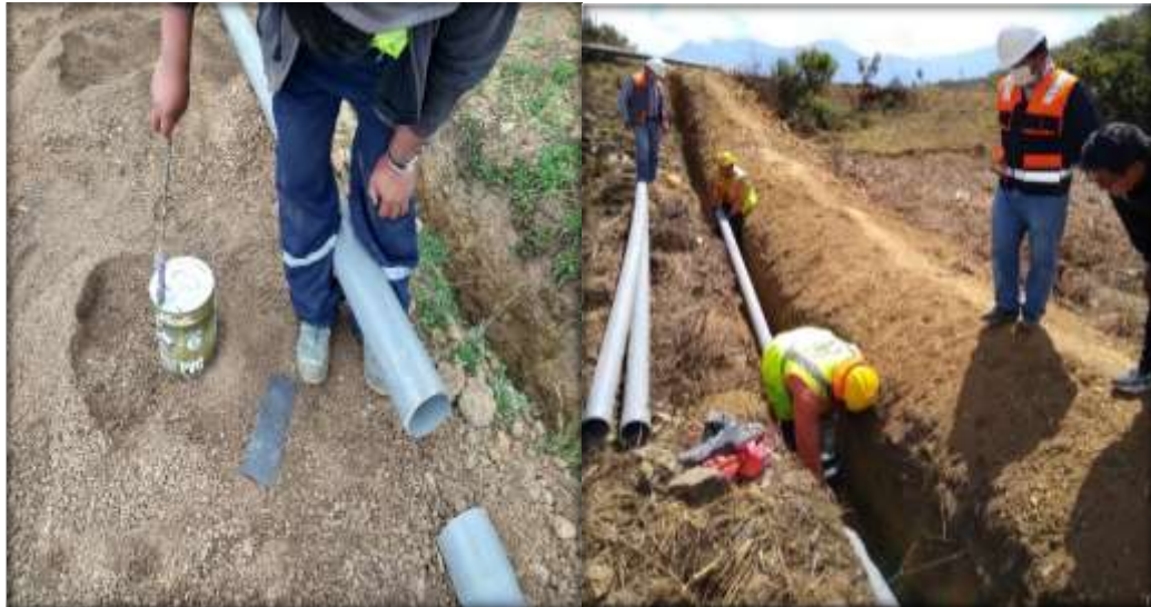
Figura N°25: Instalación de las tuberías
