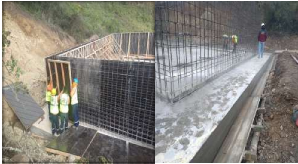
Figura N°15: Encofrado y Desencofrado del reservorio Vento Pata - Tintay.
