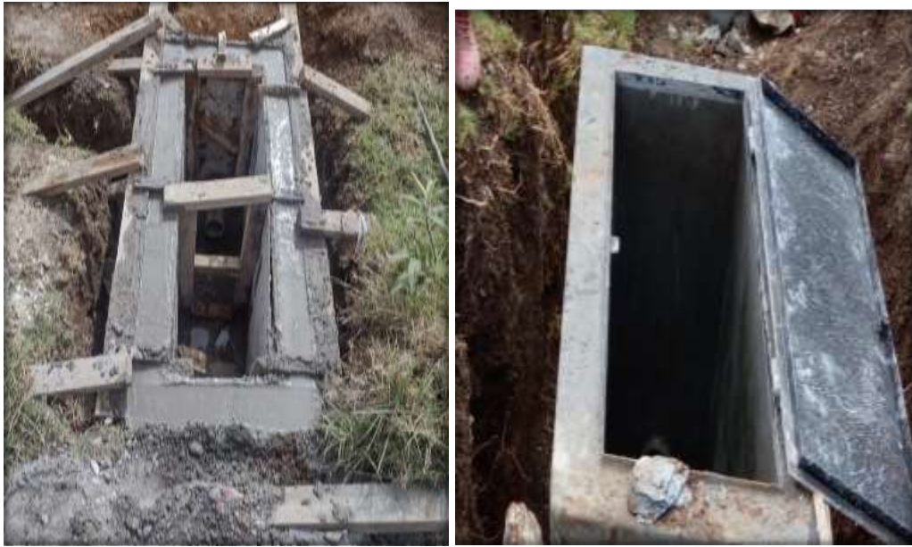
Figura N°40: Vaciado de cámara de rompe presión y colocado de la tapa.
