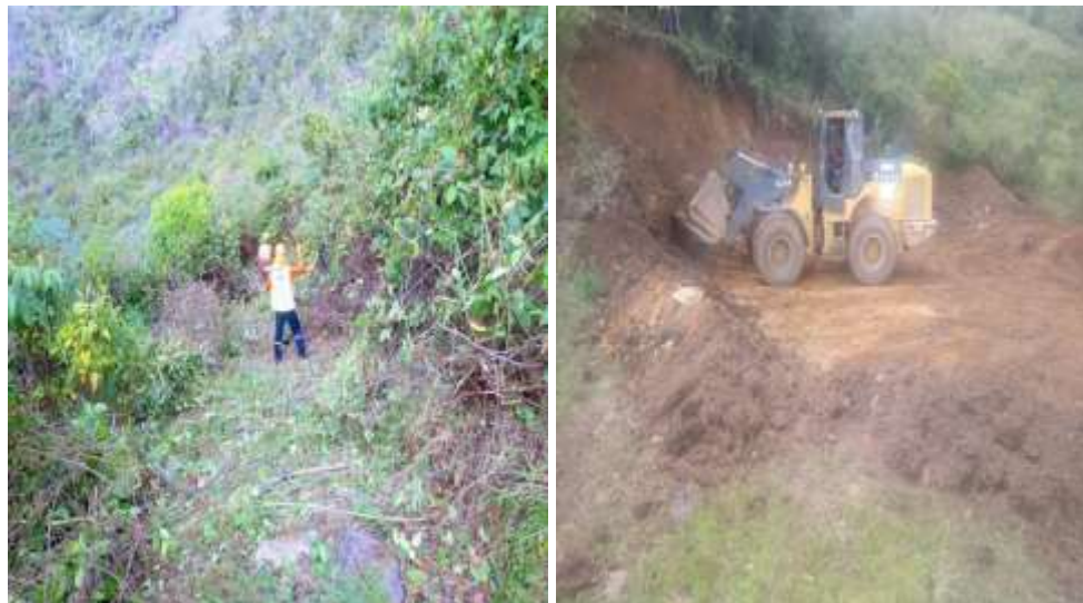
Figura N°09: Limpieza para el trazo de la excavación de zanja y explanación para el reservorio.
