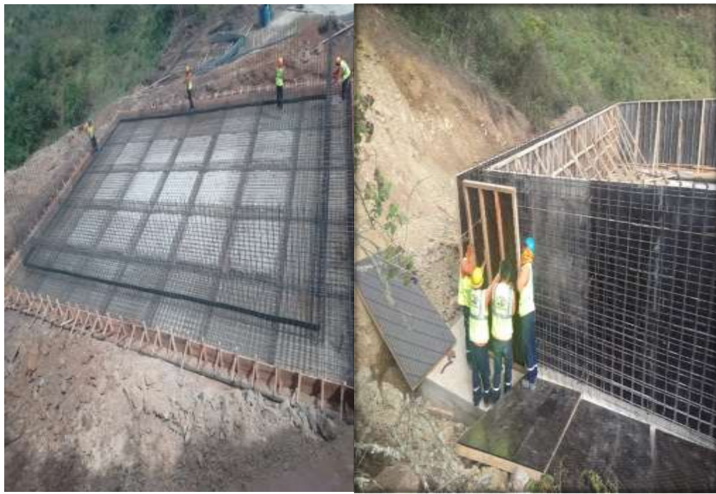
Figura N° 44: El encofrado de la losa y muro del reservorio.
