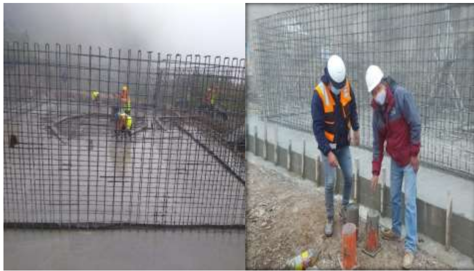
Figura N°16: Vaciado de la loza del reservorio con f'c=210 \text{ kg/cm}^2 (Era Pata – Tintay).
