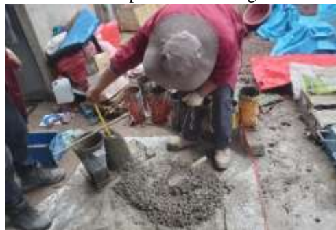
Fig. 10. Ensayo de consistencia
