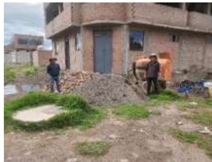
Fig. 5. Agregados para la preparación del concreto y trompo.
