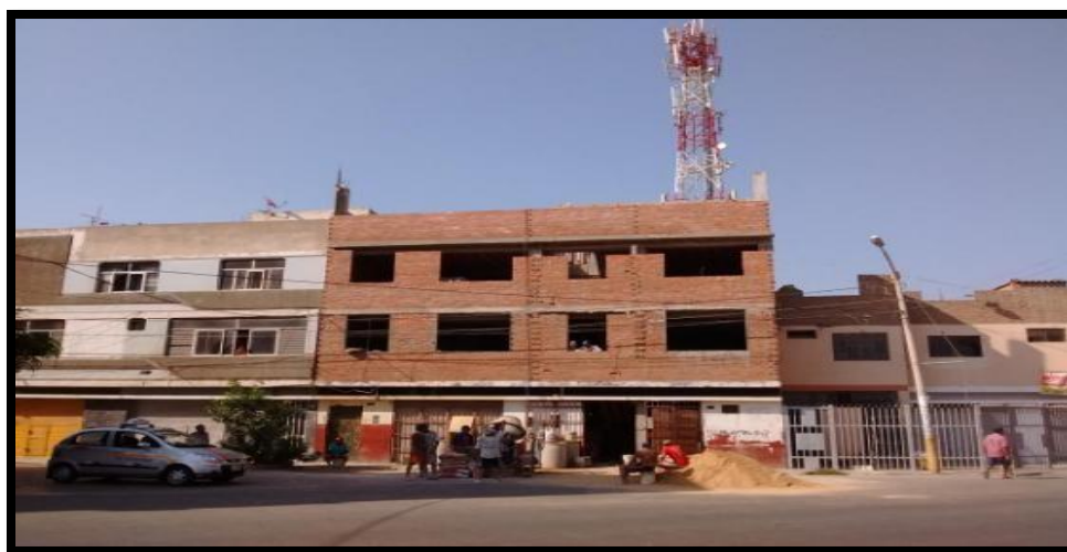
Figura 6: Vivienda sísmicamente vulnerable. Fuente: (Bazán, 2007). Tesis: Vulnerabilidad sísmica.
