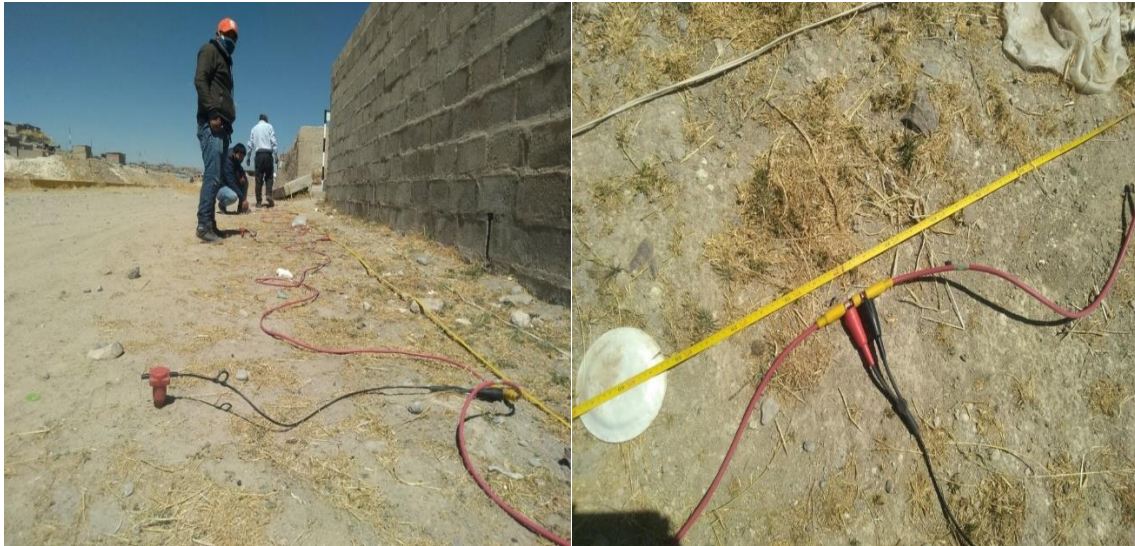
Figura 49: Colocación de geófono (izquierdo) conexión de geófono al cable de los geófonos (cable sísmico), el cual que transmite las señales al sismógrafo (derecha).
