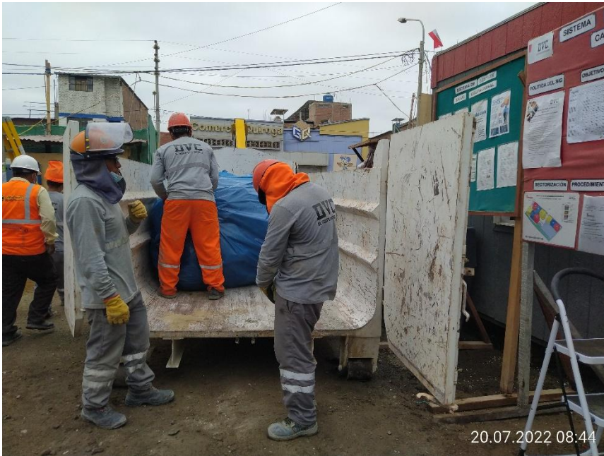
Figura 7 Eliminación de residuos sólidos
