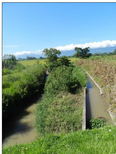
Fotografía 77. Desviación del cauce para riego.
