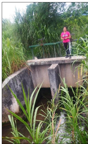
Fotografía 44. Canalización del cauce
