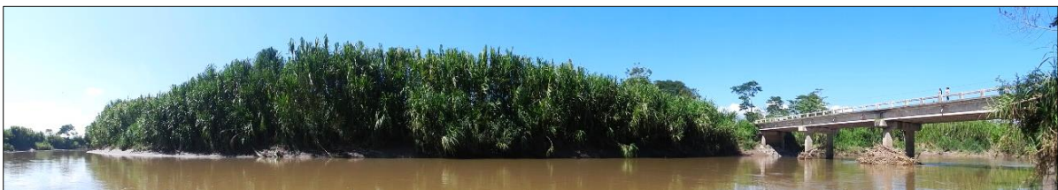
Fotografía 16 y 17. Puente vial, invasión y eliminación de las riberas.
