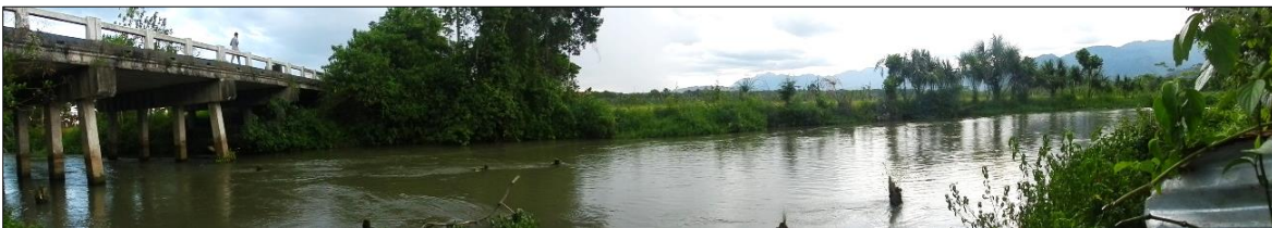
Fotografía 29. Ruptura de continuidad en el corredor ribereño con deforestación
