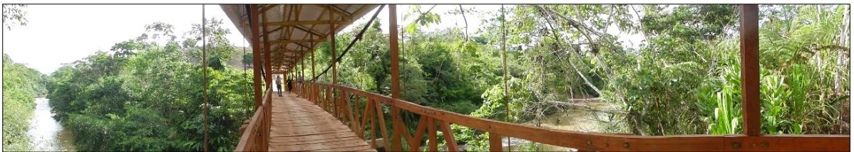
Fotografía 82. Puente vial y peatonal.
