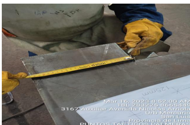
Figura N°60: Habilitado de cartelas. Fuente: Elaboración Propia .
