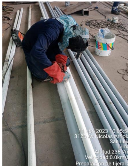
Figura N°74: Preparación superficial de arriostres. Fuente: Elaboración Propia.
