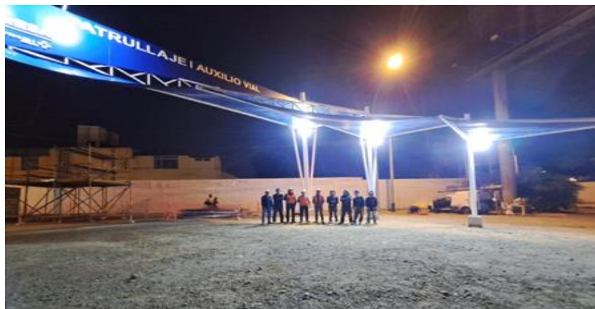
Figura N°110: Instalación de luminarias. Fuente: Elaboración propia.
