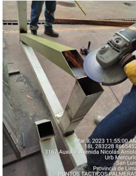
Figura N°66: Limpieza de exfoliaciones. Fuente: Elaboración Propia.
