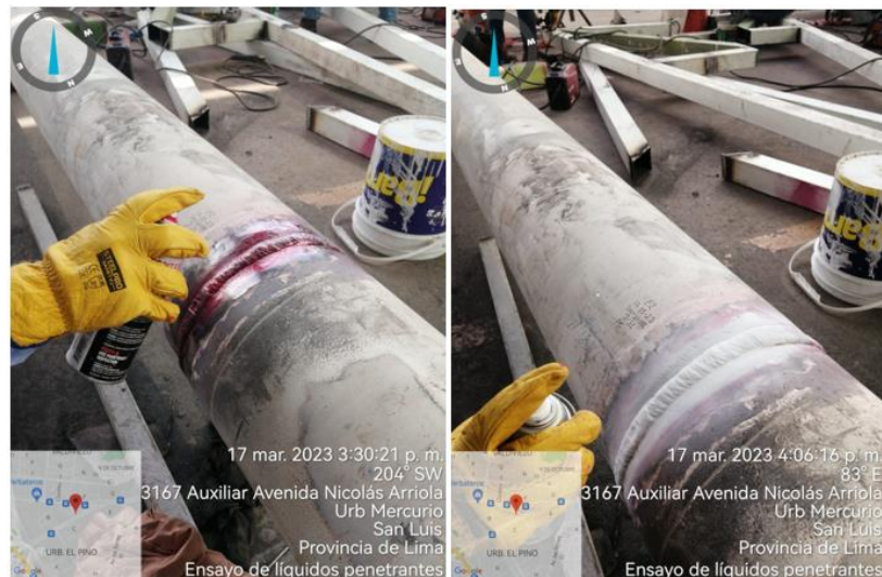
Figura N°71: Ensayo de líquido penetrante CM-1. Fuente: Elaboración Propia.
