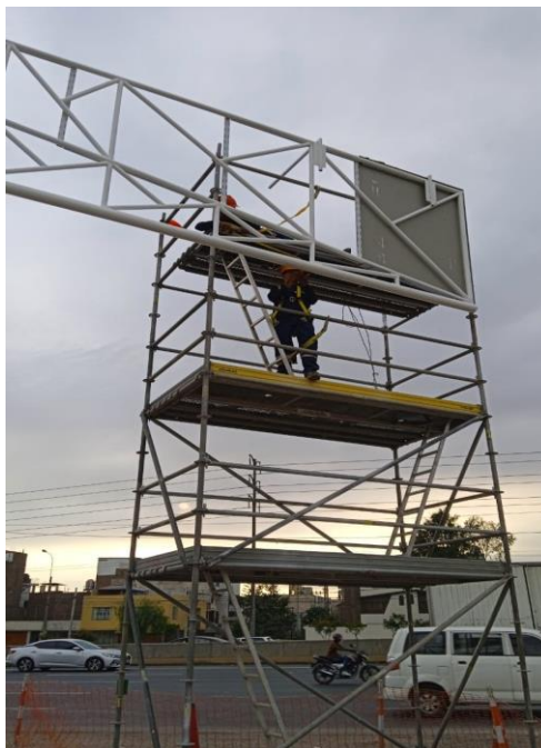
Figura N°107: Instalación de perfiles de aluminio. Fuente: Elaboración propia.
