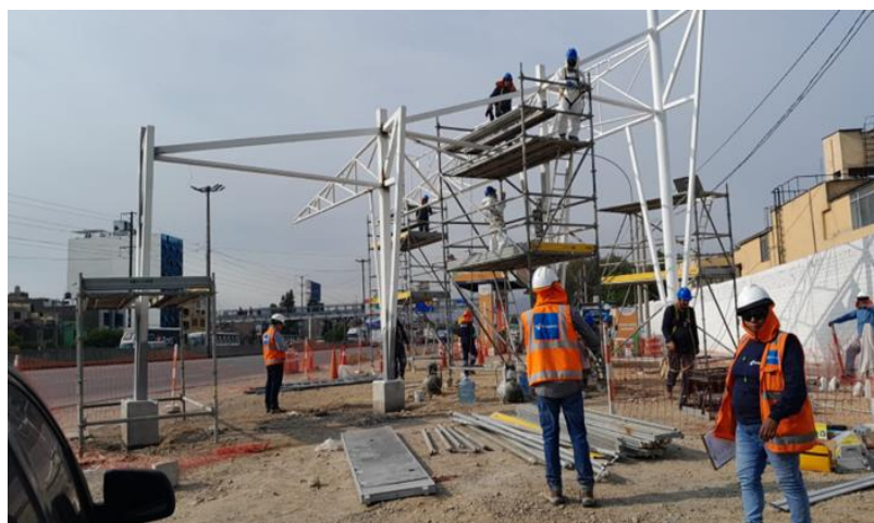
Figura N°106: Pintado de estructura. Fuente: Elaboración propia.
