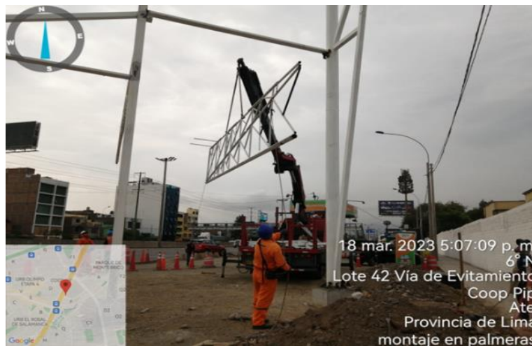
Figura N°96: Montaje de tijeral T-1. Fuente: Elaboración propia.
