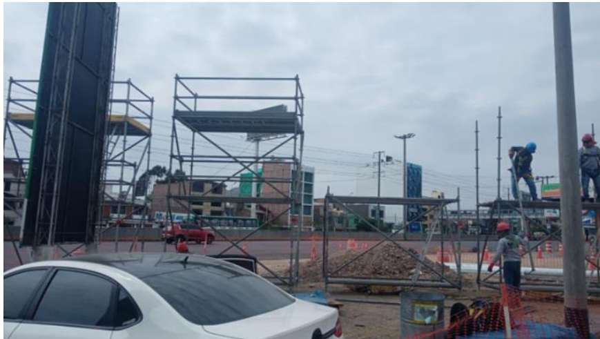
Figura N°86: Armado de andamios. Fuente: Elaboración propia.
