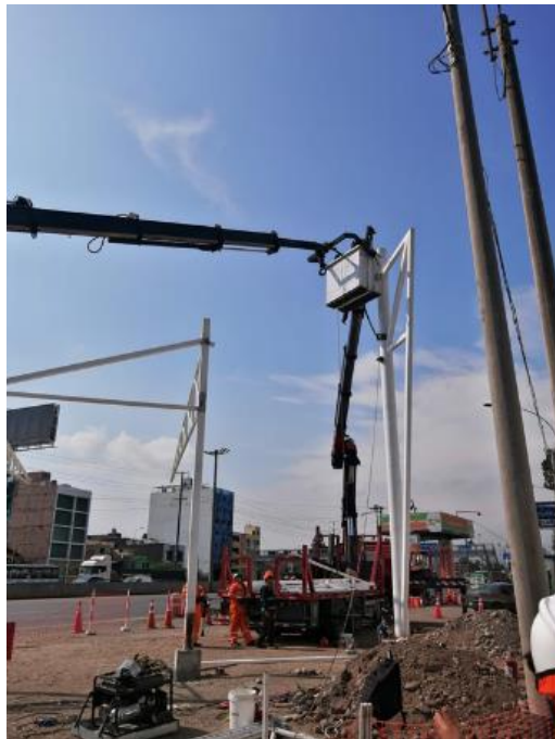
Figura N°93: Montaje de columna CM-1. Fuente: Elaboración propia.
