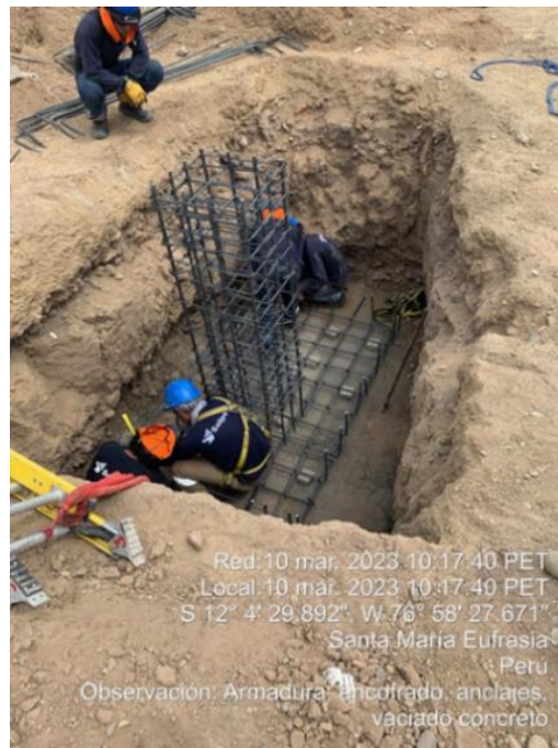
Figura N°85: Colocación de acero de pedestal. Fuente: Elaboración propia.
