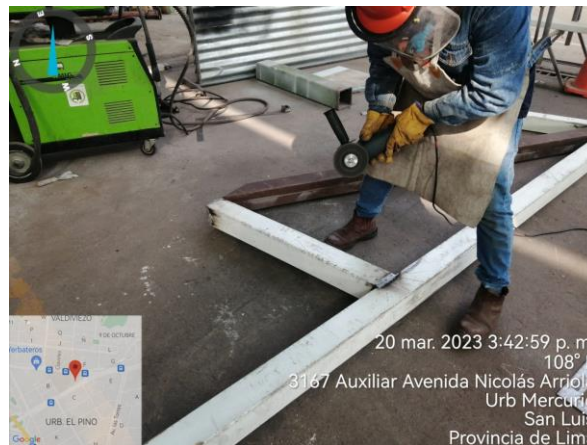
Figura N°51: Habilitación de apoyo AM-2. Fuente: Elaboración Propia .
