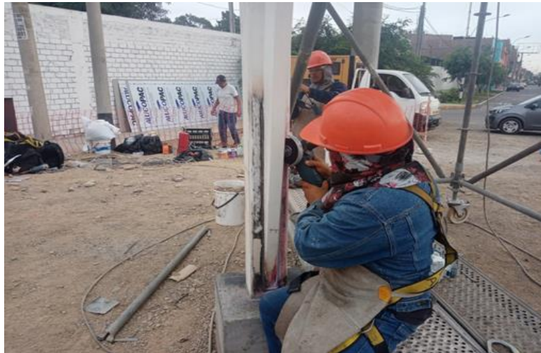
Figura N°105: Reparación de pintura. Fuente: Elaboración propia.
