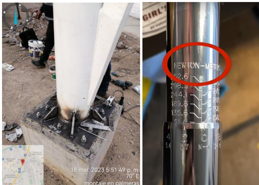
Figura N°95: Aplicación del Torquímetro a los pernos de anclaje. Fuente: Elaboración propia.
