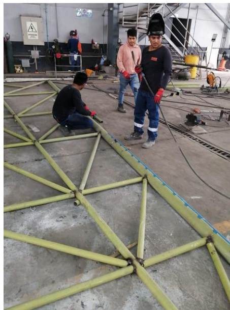
Figura N°69: Soldadura del tijeral T-1. Fuente: Elaboración Propia.
