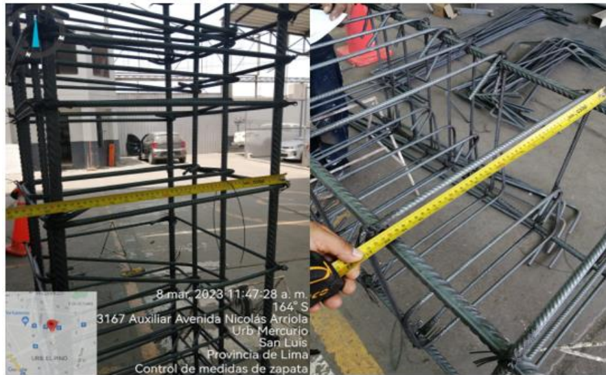
Figura N°84: Armado de acero de pedestales. Fuente: Elaboración propia.
