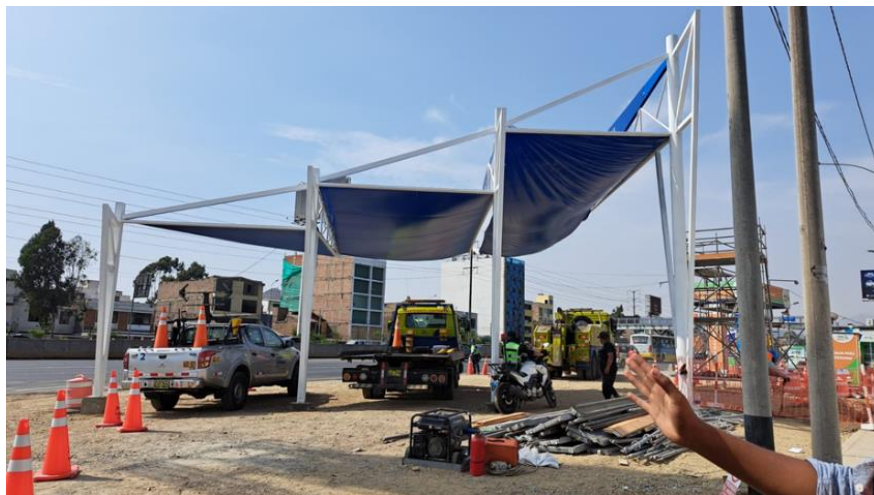
Figura N°112: Tensado de la lona AT. Fuente: Elaboración propia.
