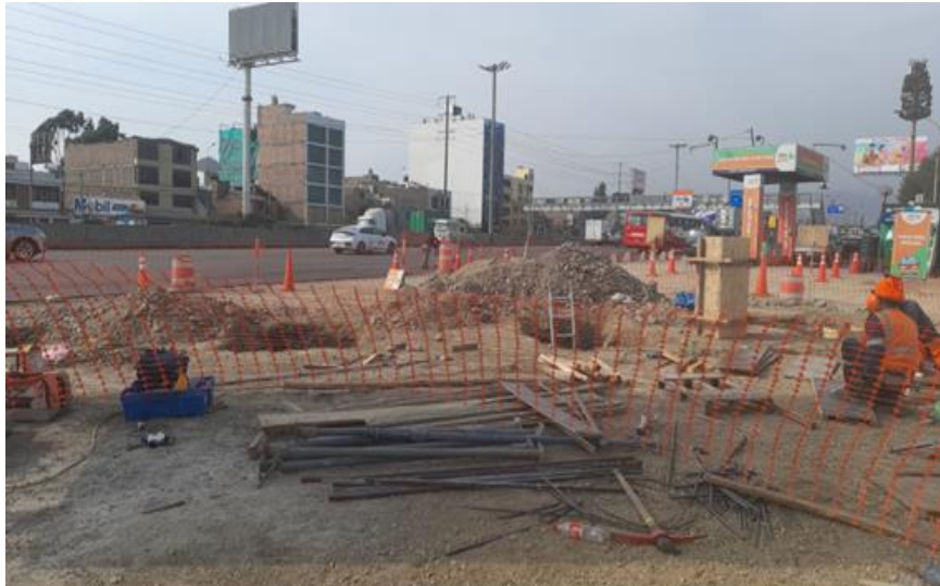
Figura N°79: Colocación de afirmado. Fuente: Elaboración Propia.
