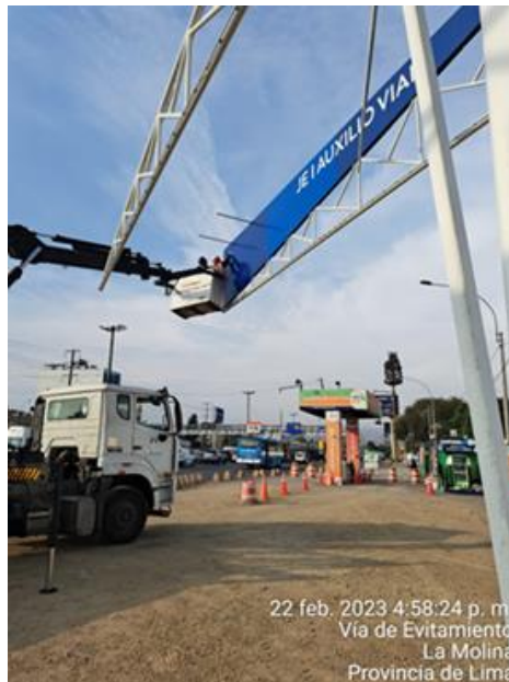
Figura N°108: Izaje de alucobond. Fuente: Elaboración propia.
