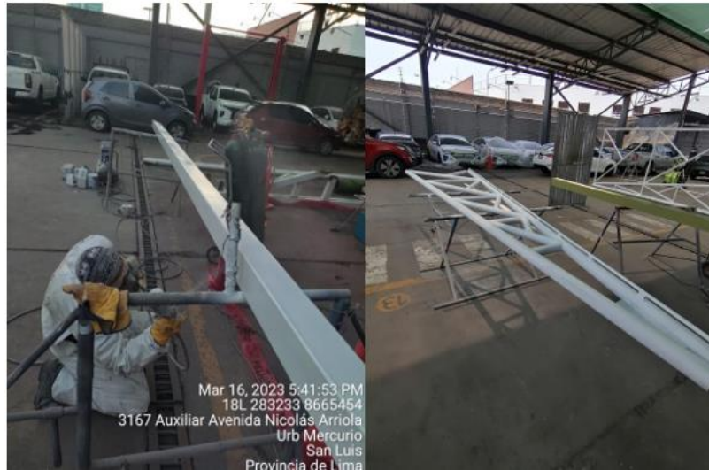
Figura N°77: Aplicación de capa de acabado. Fuente: Elaboración Propia.
