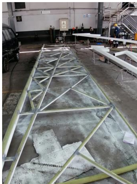
Figura N°76: Aplicación de primera capa de pintura. Fuente: Elaboración Propia.
