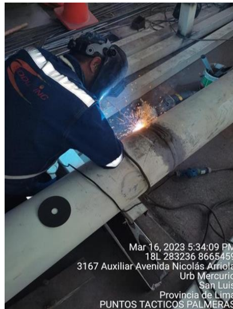
Figura N°68: Soldadura de columna CM-1. Fuente: Elaboración Propia.
