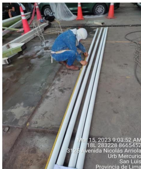
Figura N°59: Habilitado de arriostre. Fuente: Elaboración Propia .
