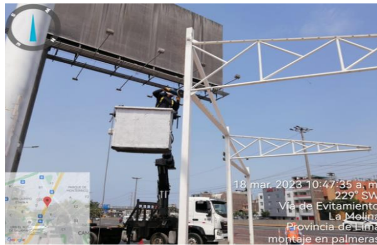
Figura N°98: Montaje de vigas VM-1. Fuente: Elaboración propia.
