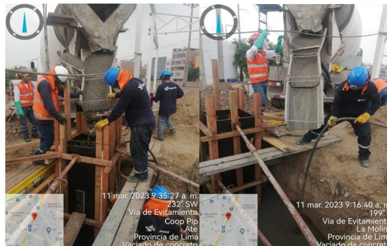
Figura N°89: Vaciado de zapatas. Fuente: Elaboración propia.
