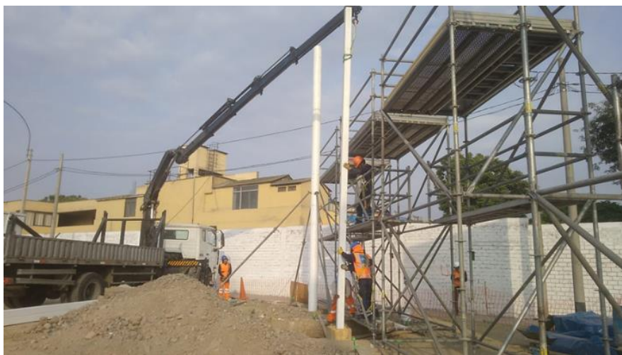
Figura N°87: Aplomado de columnas. Fuente: Elaboración propia.
