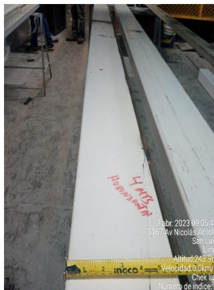
Figura N°114: Apoyo- tubo rectangular 50x150x3mm. Fuente: Elaboración propia.
