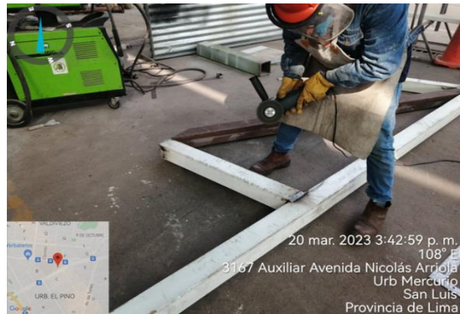
Figura N°70: Retiro del material de aporte. Fuente: Elaboración Propia.
