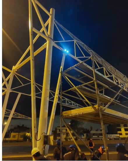
Figura N°109: Instalación de interruptores. Fuente: Elaboración propia.
