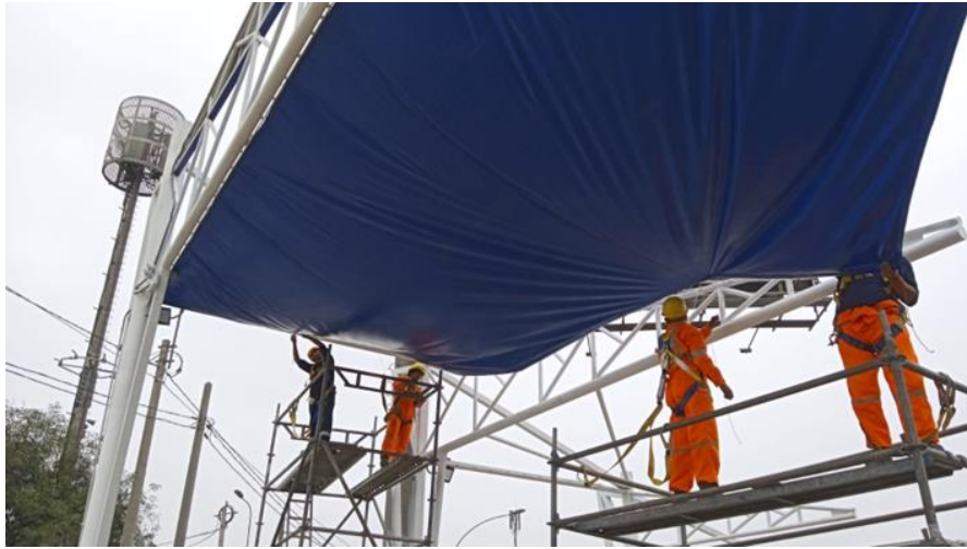
Figura N°111: Instalación de lona AT. Fuente: Elaboración propia.
