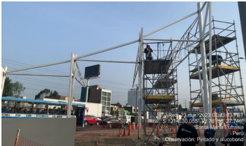
Figura N°100: Montaje de arriostres. Fuente: Elaboración propia.
