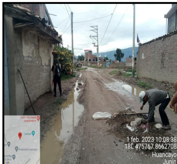
Figura N°07 Av. 9 de Diciembre, charcos de agua en épocas de lluvia. Fuente: IOARR proyecto 01.
