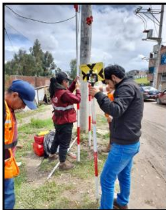
Figura N°09 Levantamiento topográfico de postes para el proyecto. Fuente: IOARR del proyecto 1.
