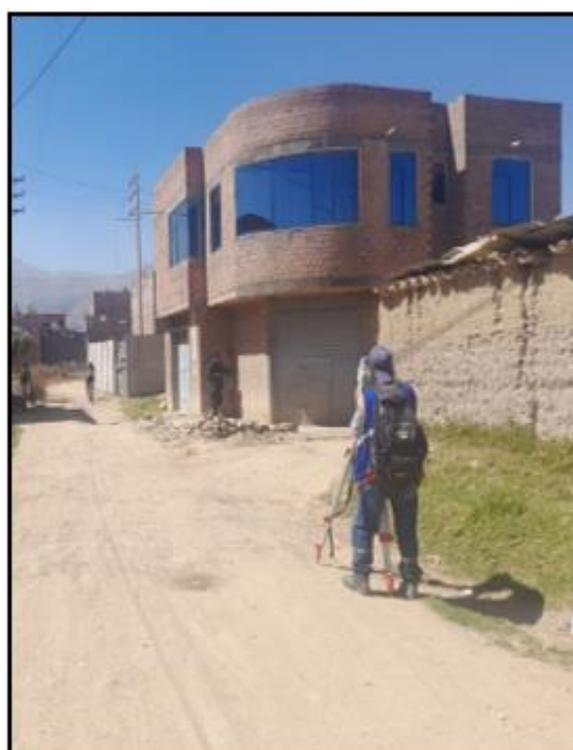
Figura N°20. Levantamiento topográfico Pasaje Mendoza. Fuente: IOARR del proyecto 02.
