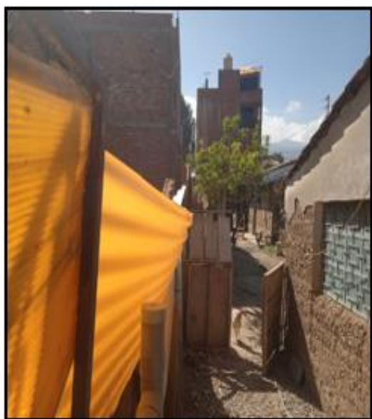
Figura N°30 Vista de los accesos a las viviendas. Fuente: Expediente técnico del proyecto 4.
