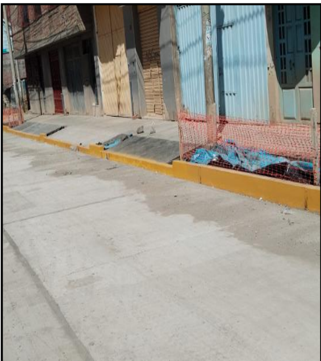
Figura N° 41. Pavimento ejecutado del proyecto 5. Fuente: propia.
