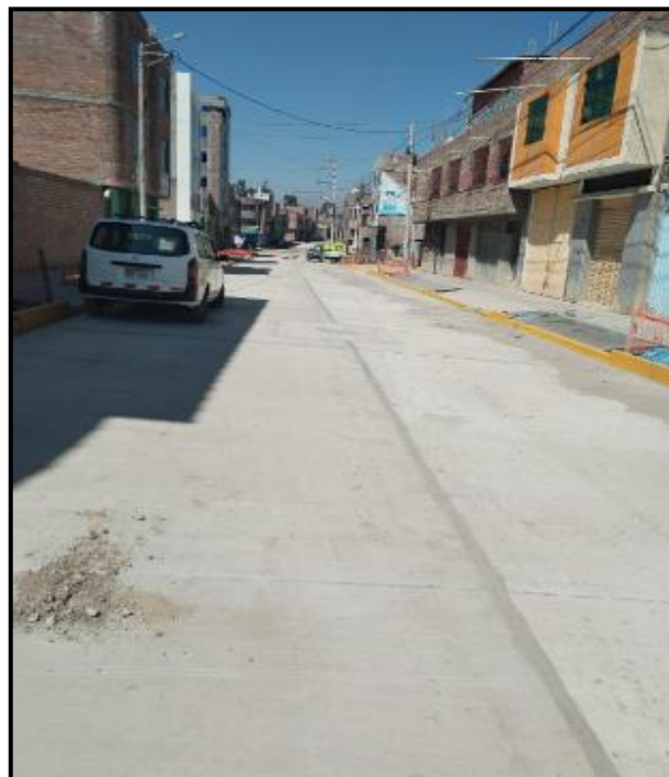
Figura N° 43. Pavimento ejecutado del proyecto 5. Fuente: propia.
