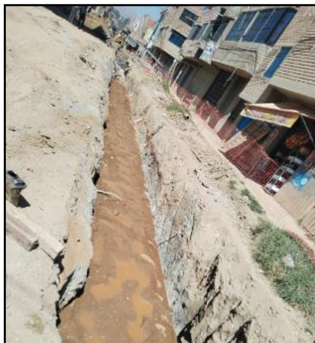
Figura N° 40. Curado de red principal de alcantarillado. Proyecto 1. Fuente: propia.
