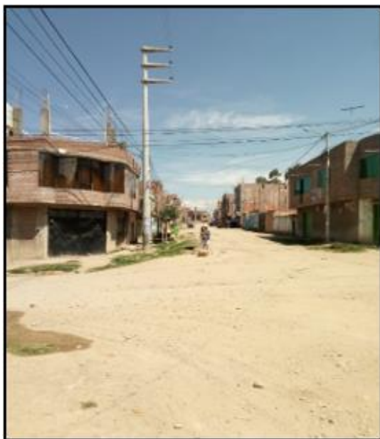
Figura N° 35 Vista panorámica del proyecto. Fuente: Expediente técnico del proyecto 5.
