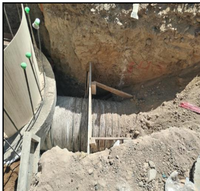
Figura N° 38. Construcción de buzón del proyecto 1. Fuente: propia.
