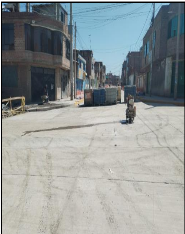
Figura N° 42. Pavimentado de calles del proyecto 5. Fuente: propia.
