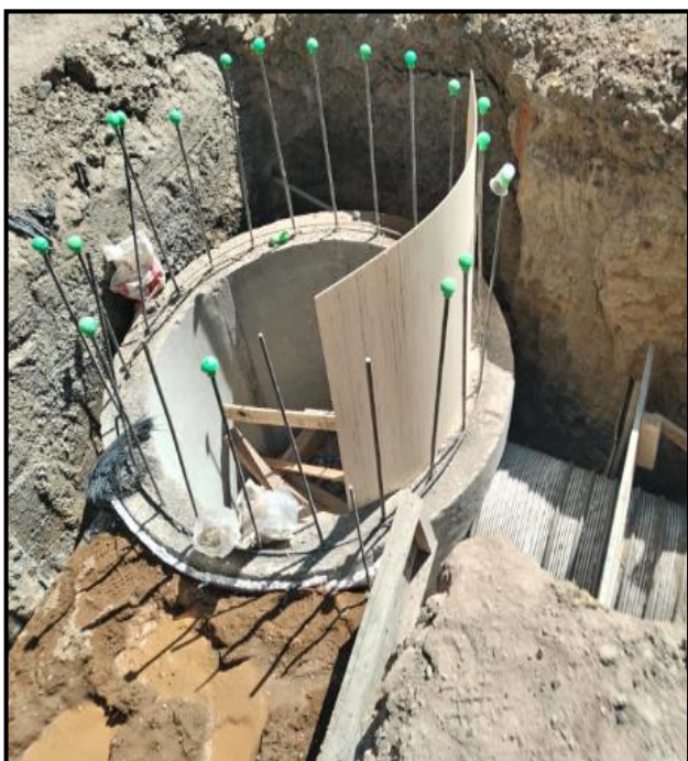
Figura N° 39. Construcción de buzón del proyecto 1. Fuente: propia.
