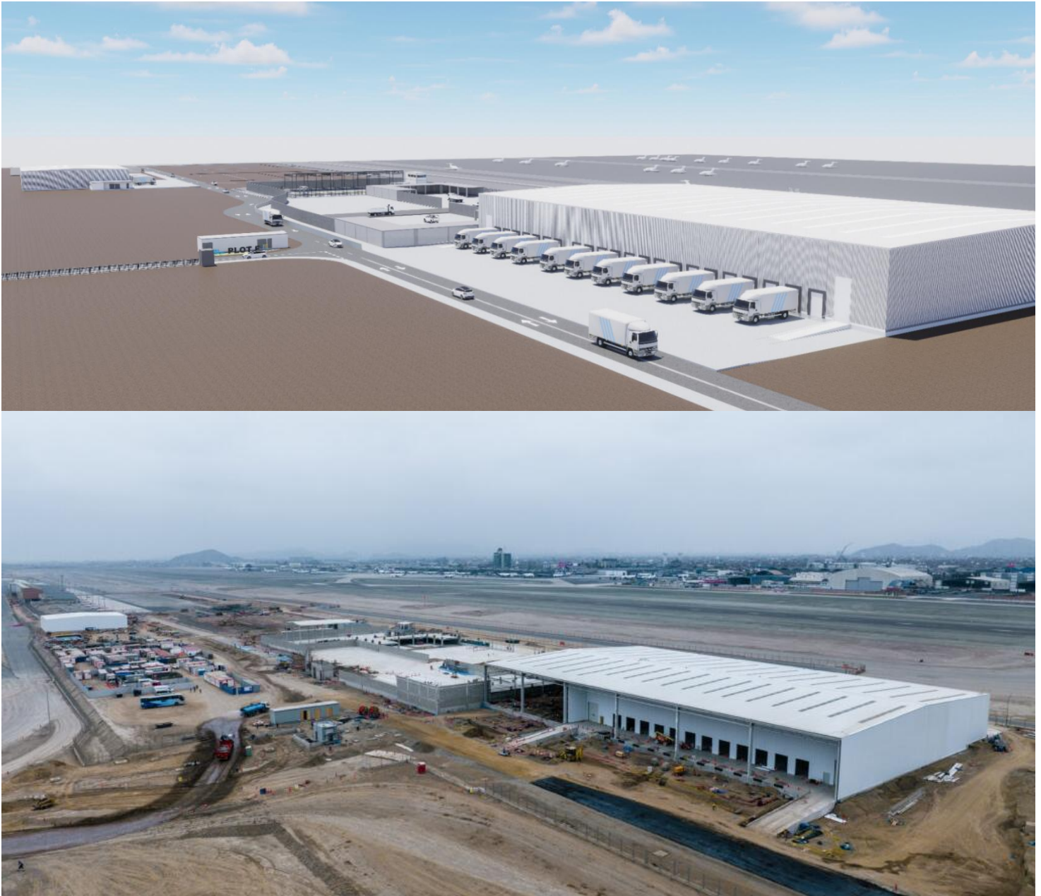
Figura 9. Comparativa entre el Renderizado y la Ejecución del Proyecto Zona de Carga Sur
