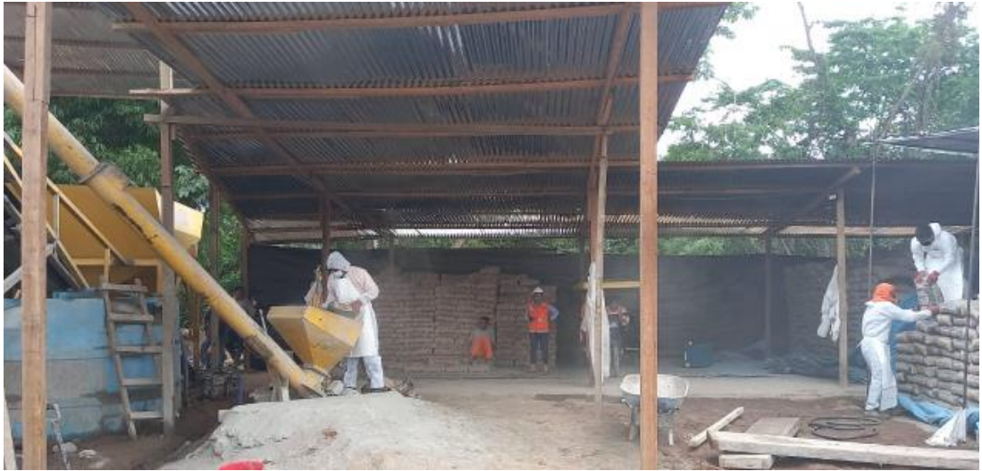
IMAGEN Nº 3 Preparación del concreto Premezclado
