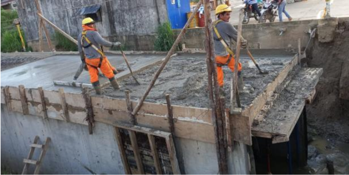
IMAGEN Nº 5 Trabajos en altura
